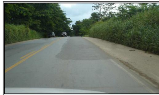
Sinalização horizontal inadequada, com linha de bordo gasta e incompleta depois de reparo no pavimento
