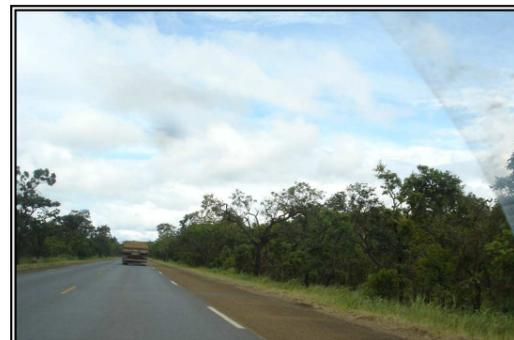
Árvores sem proteção e sinalização horizontal incorreta (linha de bordo seccionada)
