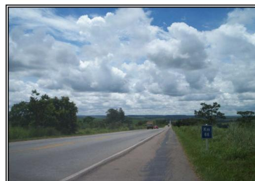
Sinalização horizontal sem tachas e acostamento pavimentado e desnivelado
