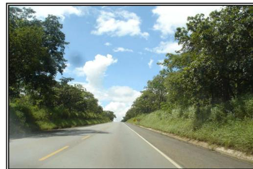
Trecho com pavimento e sinalização horizontal novos, inclusive com tachas da linha separadora de fluxos
