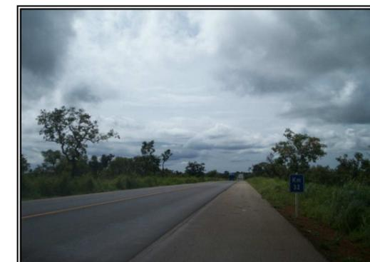
Seção em pista simples, com uma faixa por sentido e acostamento desnivelado
