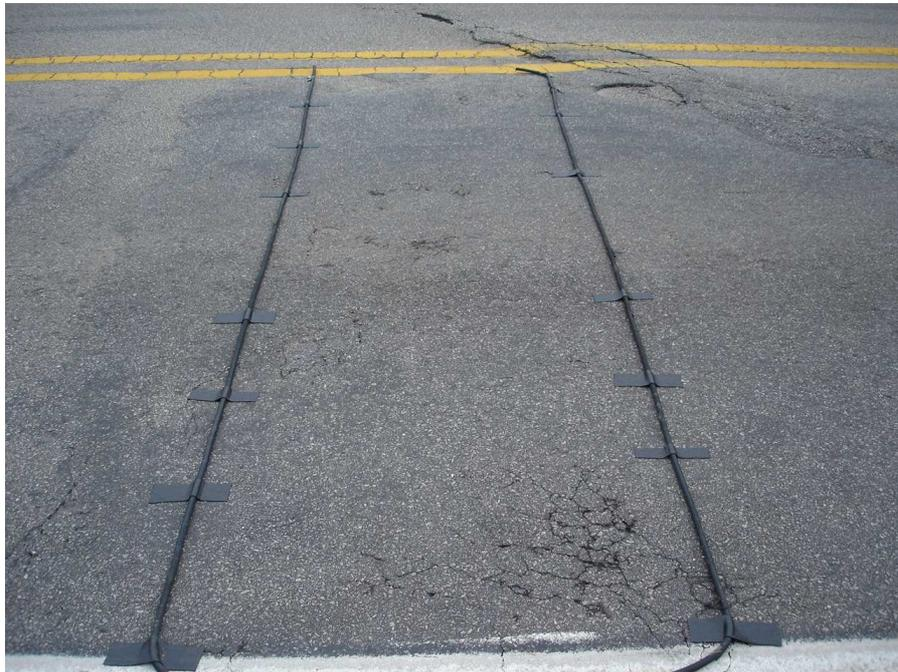
Tubos pneumáticos instalados na via
