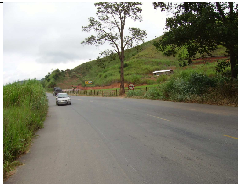
Figura 10 - Vista da cerca junto ao acostamento.
