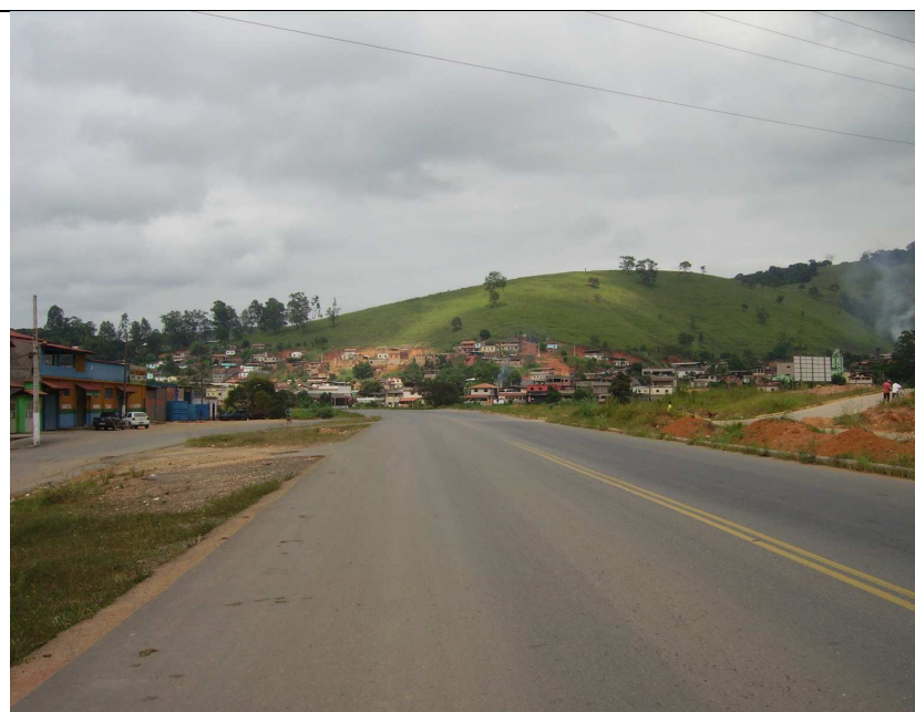
Figura 22 - É notável a insuficiência da infraestrutura urbana.
