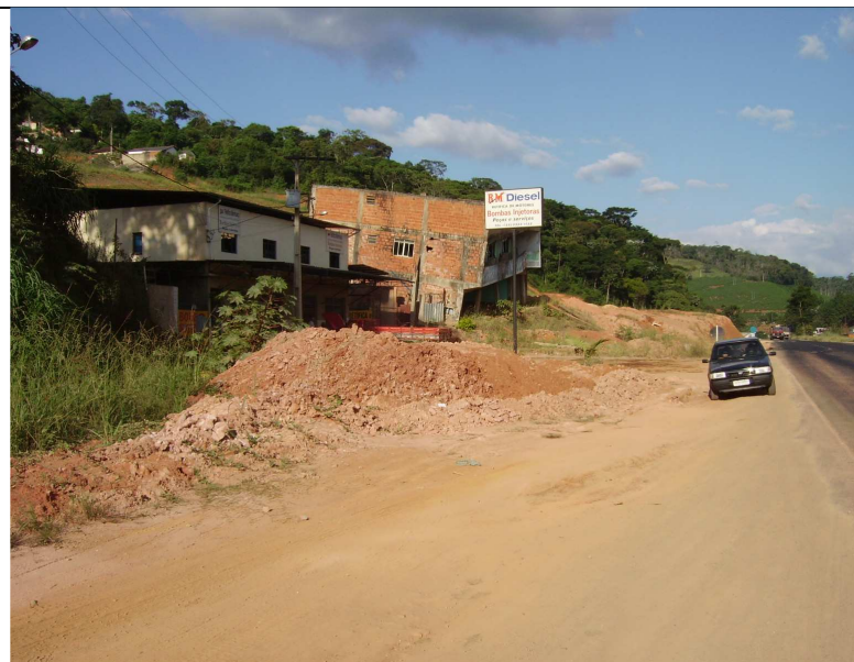
Figura 7 - Vista das edificações em situação irregular junto ao acostamento.
