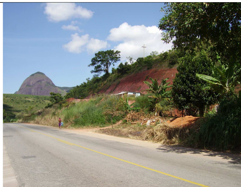
Figura 26 - Início da ocupação irregular, com cerca de 4 casas.
