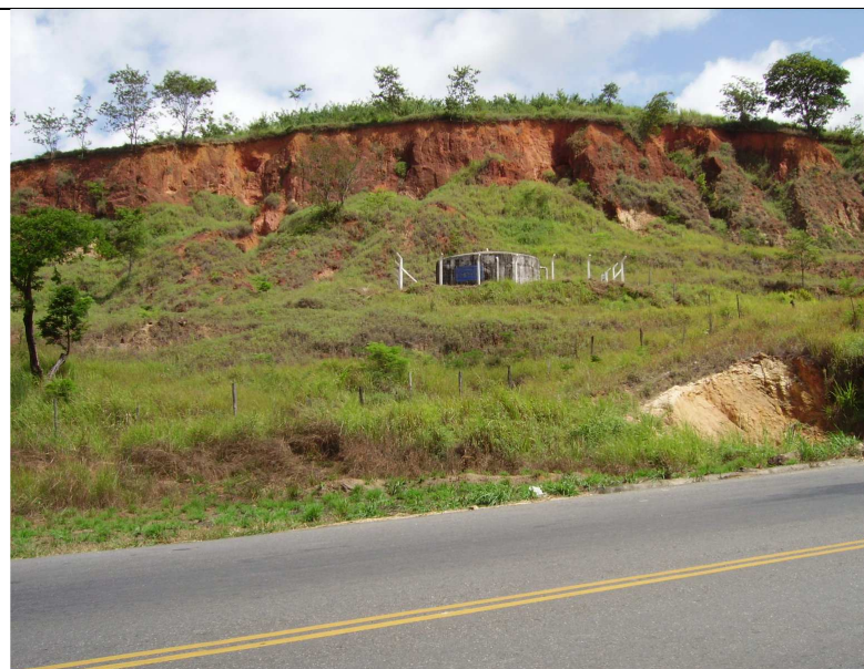
Figura 14 - Aparentemente o reservatório situa-se na Faixa de domínio da rodovia.
