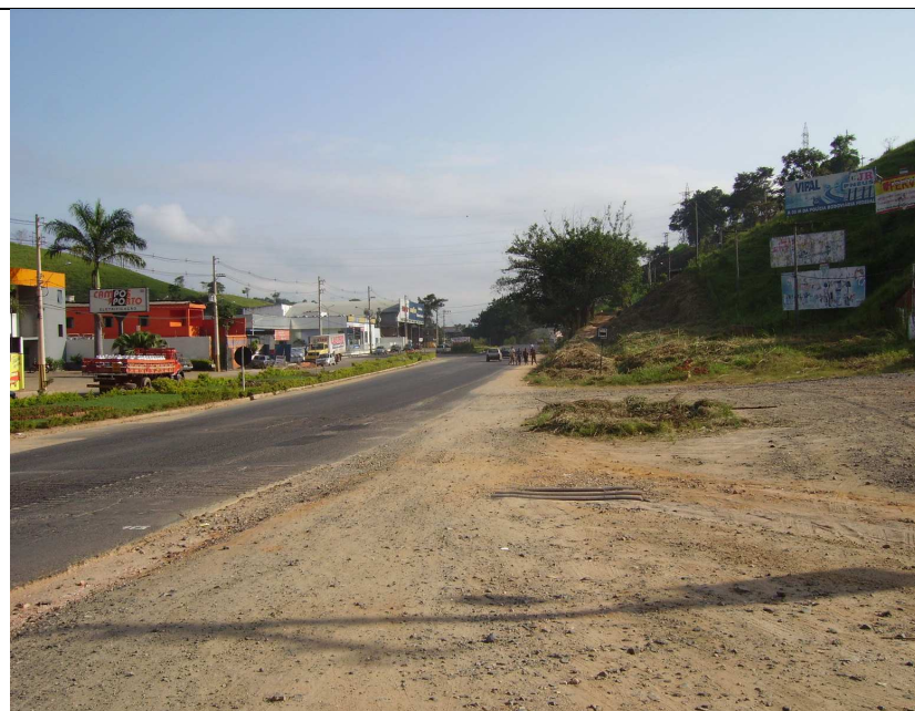
Figura 17 - Condições de acesso indefinidas e parca sinalização geram conflitos entre tráfego rodoviário e local.
