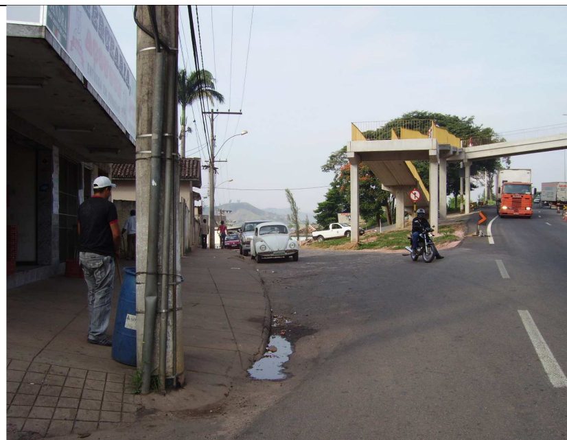
Figura 4 – O uso e ocupação do solo próximo à pista gera risco de acidentes.
