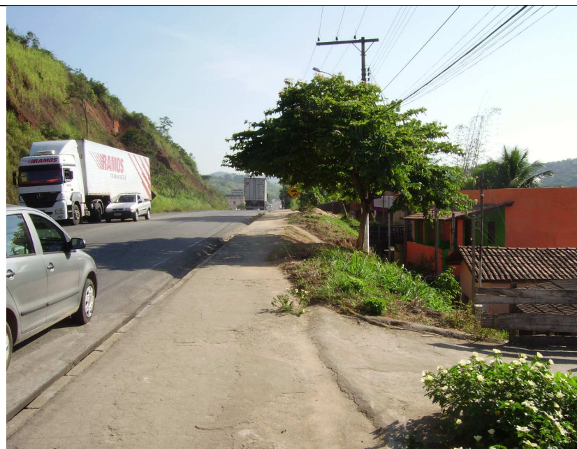
Figura 41 - Talude de corte à esquerda e talude de aterro no lado direito complementado por ocupação da faixa de domínio abaixo do nível da pista, é o passivo ambiental dominante nas passagens urbanas da BR-116.
