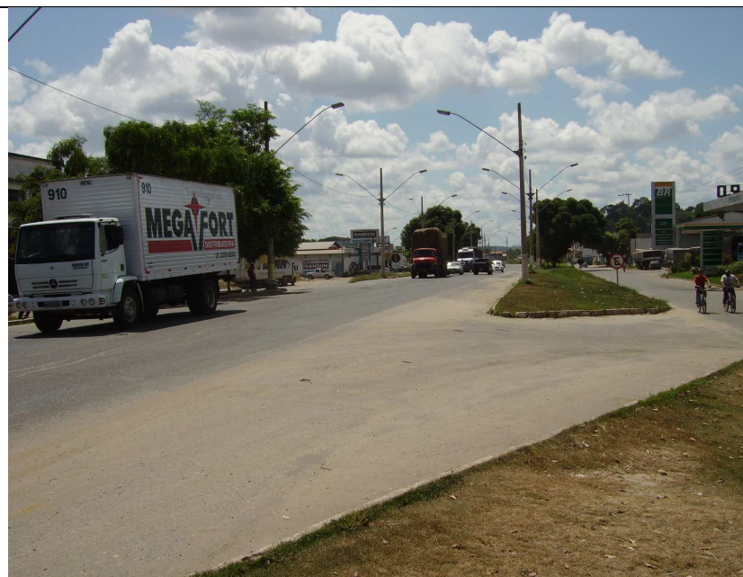
Figura 31 - A descontinuidade das vias marginais leva o tráfego local para a rodovia.
