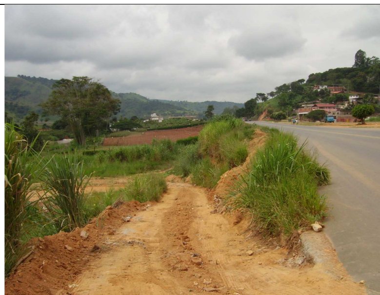
Figura 12 - Além de depósito irregular de lixo o acesso também é irregular.
