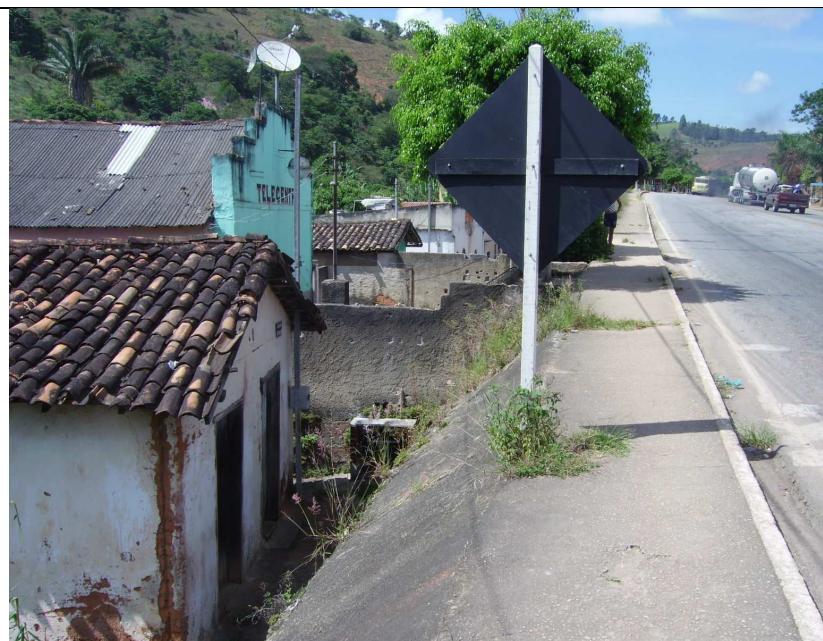
Figura 47 - A invasão da faixa de domínio prejudica a rodovia e o talude da rodovia compromete a integridade das edificações.
