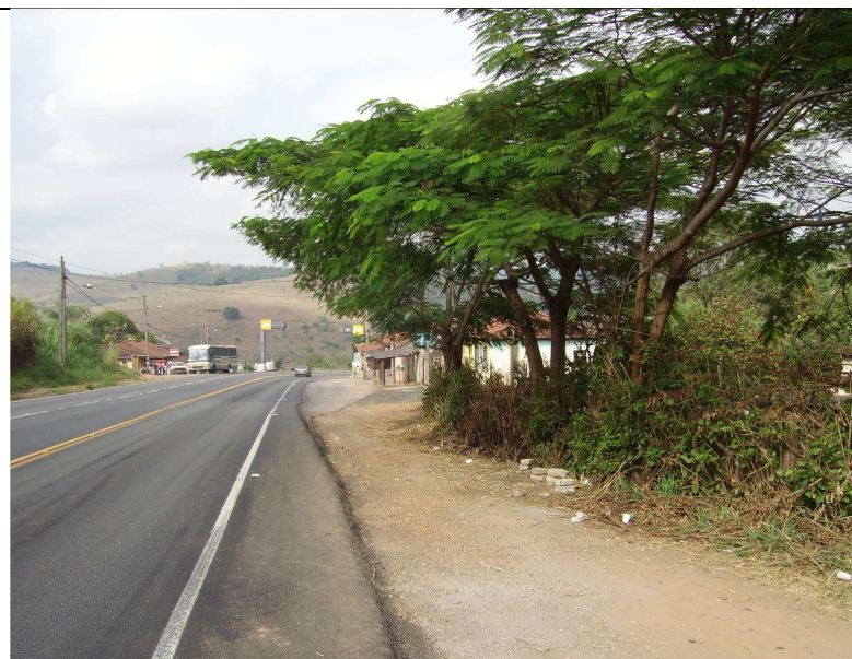
Figura 9 - As edificações situam-se junto à pista invadindo o acostamento.
