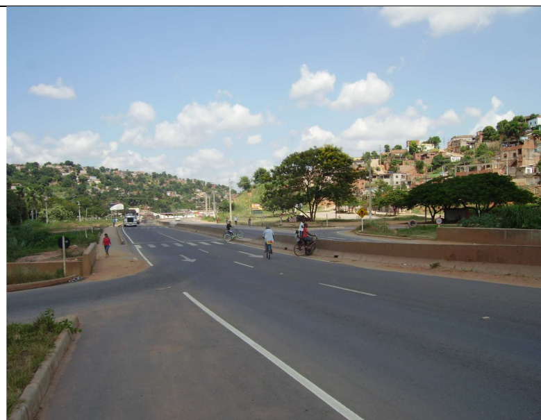
Figura 15 - Vista da ciclovia no acostamento e da travessia inadequada da rodovia.
