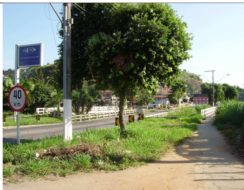
Figura 38 - As antigas e estreitas pontes sobre os rios e córregos são restritores de implantação de melhoramentos na estrutura rodoviária, em particular na travessias urbanas, onde provocam o seccionamento de vias locais.
