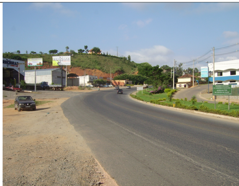
Figura 16 - A descontinuidade da via marginal obriga o tráfego local a utilizar a rodovia para conversões e percursos.
