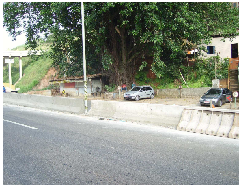
Figura 3 - A atividade dos barraqueiros gera risco de acidentes ao longo do acostamento. Atualmente o trecho está em obras.
