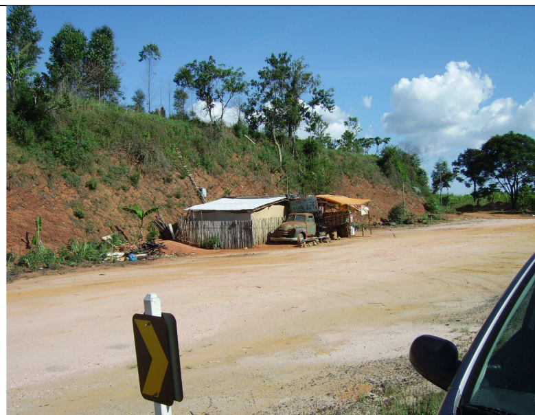
Figura 4 - Vista da invasão da faixa de domínio.
