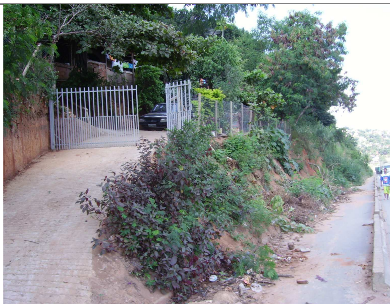
Figura 18 - Apesar de bem execurado o acesso é irregular, assim como a ocupação.
