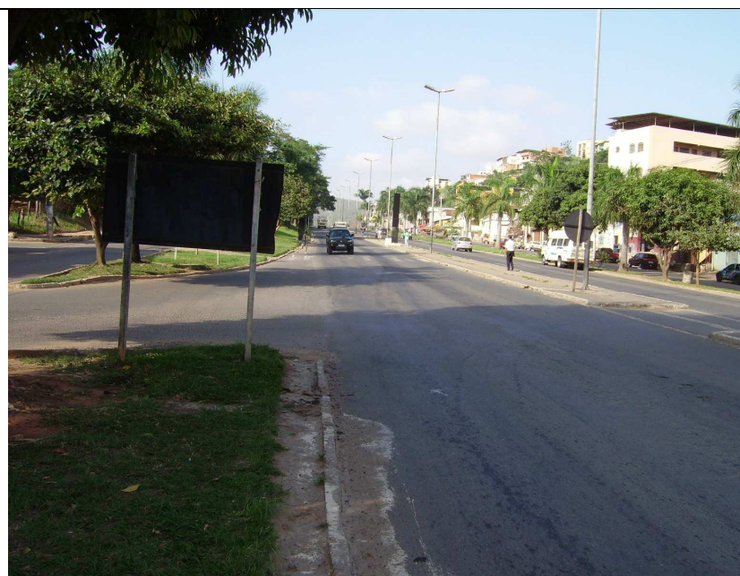
Figura 15 - A descontinuidade da via marginal obriga o tráfego local a utilizar a rodovia para conversões e percursos.
