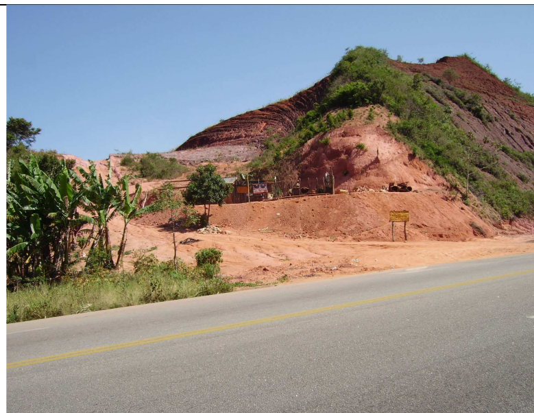
Figura 25 - Além de irregular provoca erosão do terreno.
