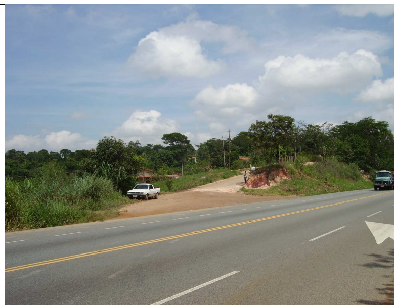
Figura 11 - A ausência de acostamento agrava a situação da acesso irregular. A conversão à esquerda esta sinalizada na 3ª. Faixa.
