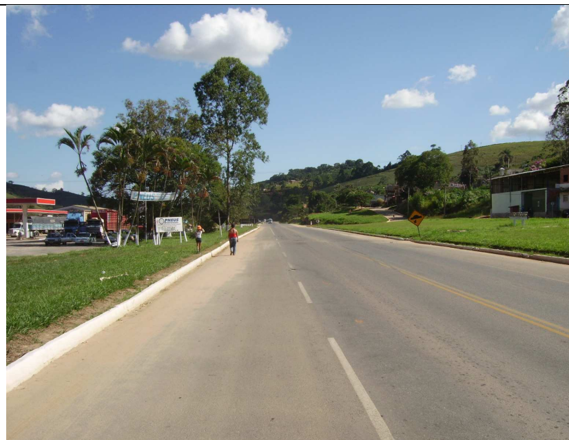
Figura 5 – Travessia da BR 116 pela área urbana de Fervedouro. Note-se ausência de qualquer dispositivo de travessia e conversão de tráfego urbano.
