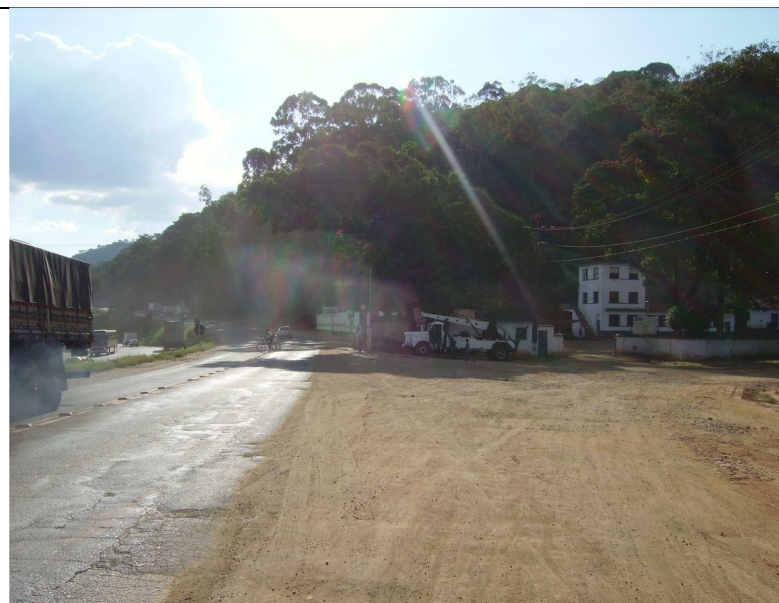
Figura 6 - Vista da área com acesso irregular.
