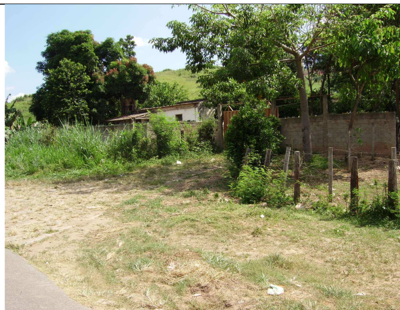
Figura 1 - A cerca da foto não delimita corretamente a faixa de domínio da rodovia.
