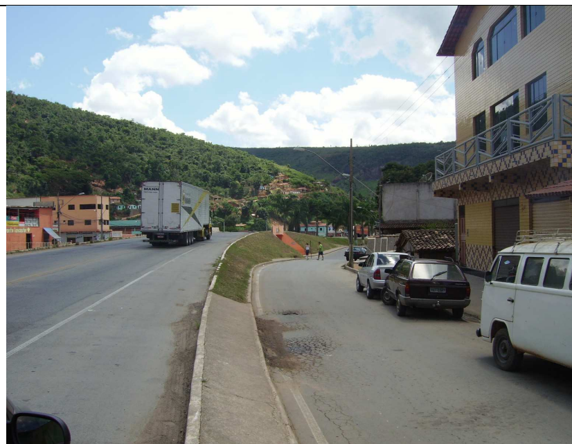
Figura 49 - Vista da área urbana de Padre Paraíso e seu peculiar e eficiente dispositivo de travessia, conversão e retorno sob a rodovia.
