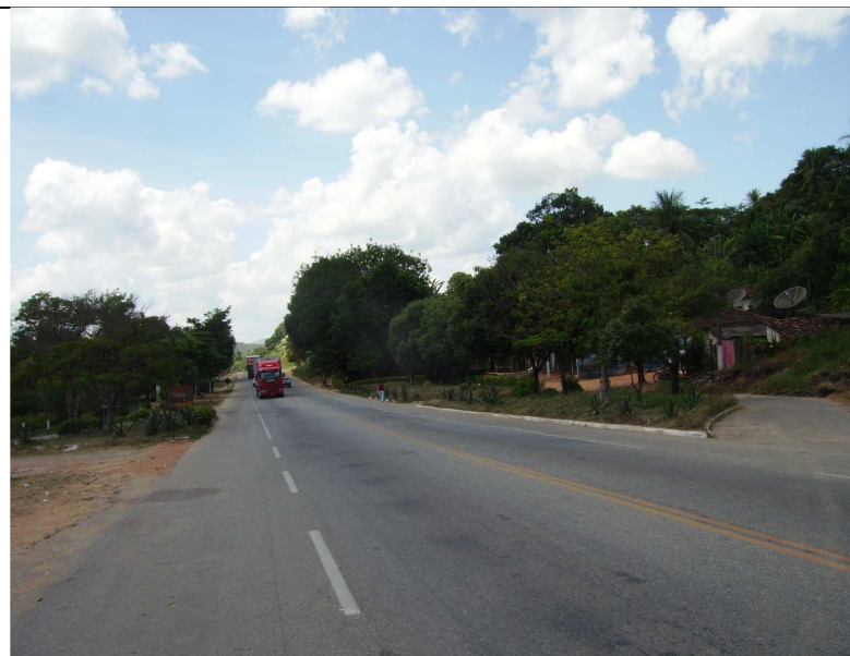
Figura 20 - O controle de acesso e travessia é nitidamente insuficiente.
