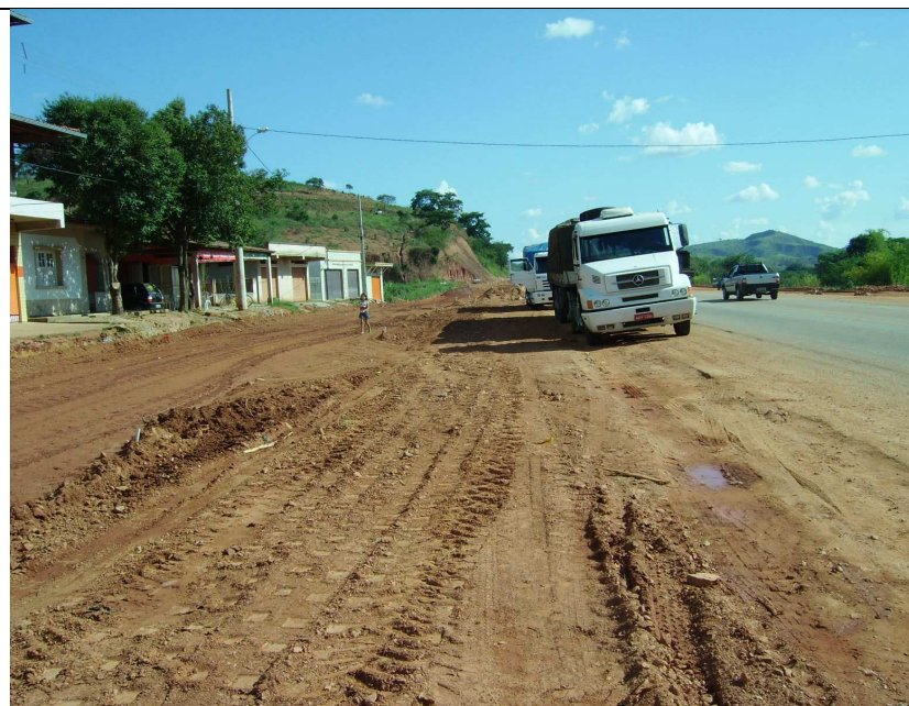
Figura 34 - Em Campanário as obras devem recuperar eventual passivo ambiental.
