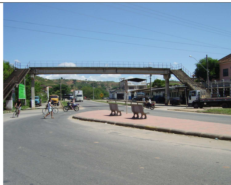
Figura 3 – A despeito da existência da passarela de pedestres o tráfego de pedestres continua sendo feito à “sombra” da mesma.
