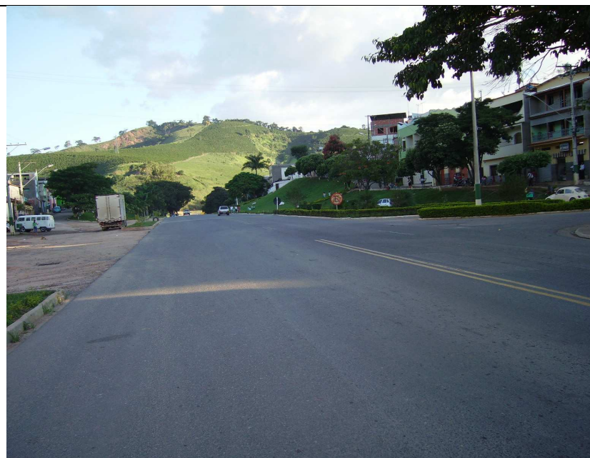
Figura 11 - Nota-se a ausência de vias marginais e de dispositivos de acesso e retorno adequados. Além disso, total falta de placas informativas.
