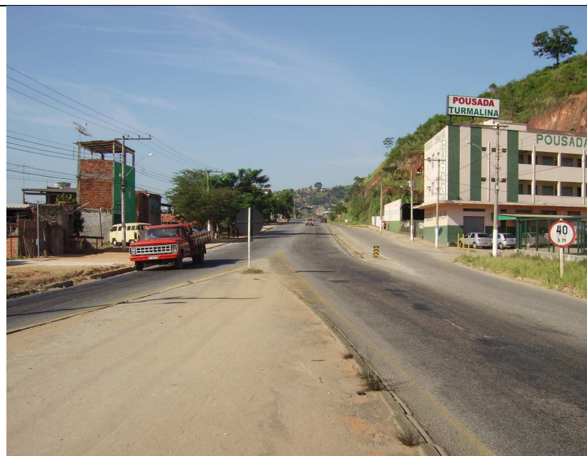
Figura 42 - A descontinuidade das vias marginais é uma das causas de conflito entre tráfego local e rodoviário
