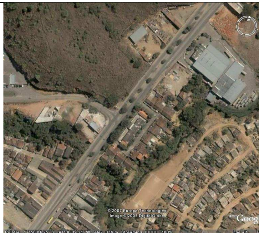
Figura 37 - A descontinuidade das vias marginais é uma das causas de conflito entre tráfego local e rodoviário
