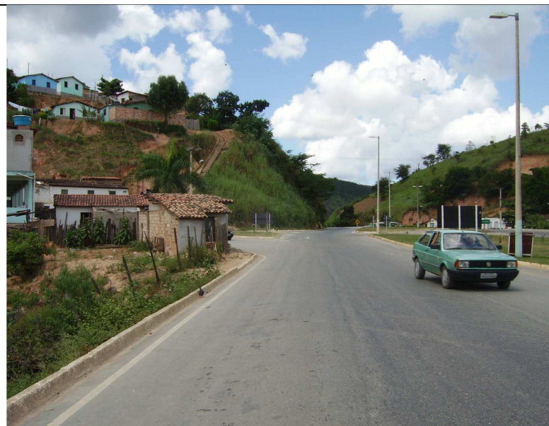
Figura 30 - O acesso à casa é direto da rodovia.
