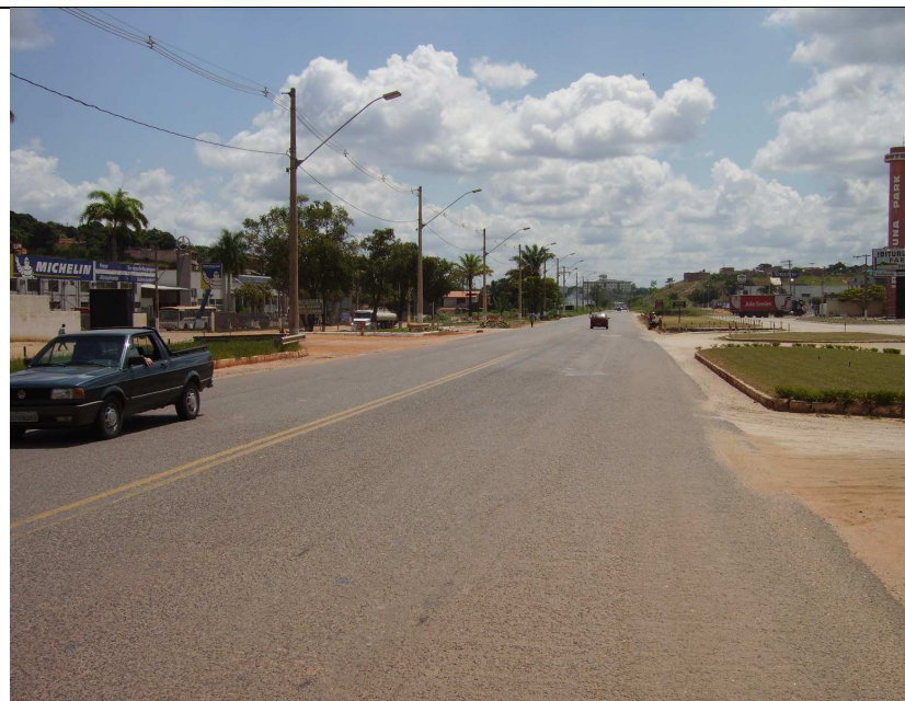
Figura 28 - As vias marginais apresentam descontinuidade levando o tráfego local para a rodovia.
