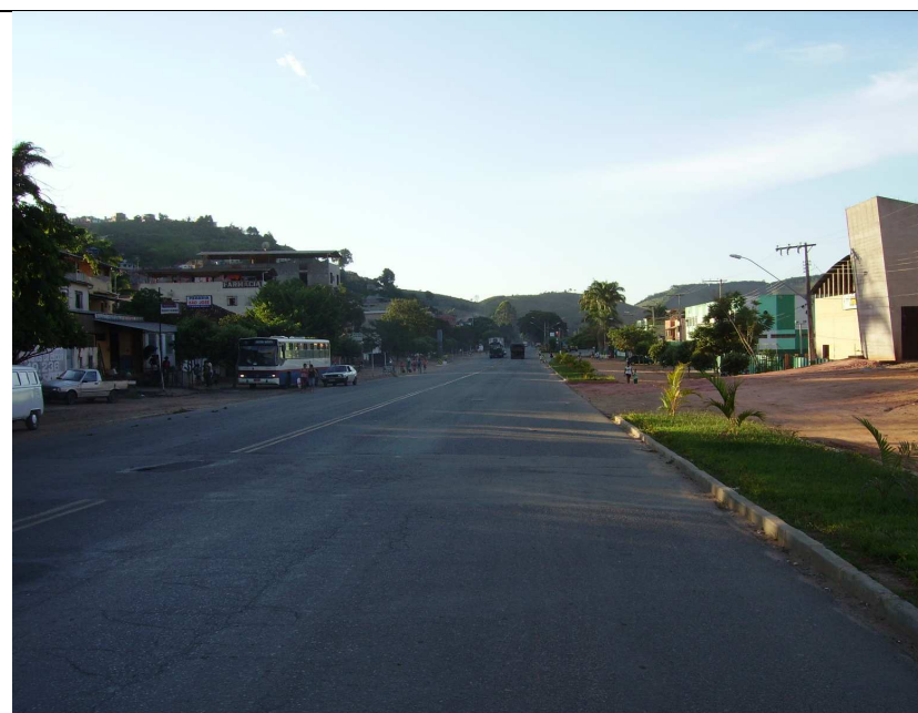
Figura 12 - Embora não ocorra tráfego urbano intenso, os riscos de acidentes estão presentes. A ausência de sinalização é um fator de risco.
