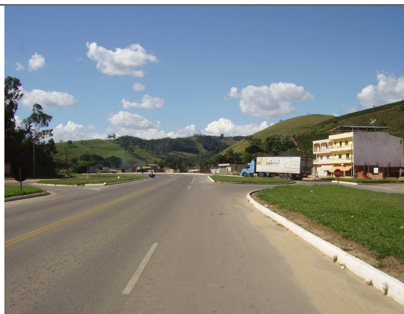
Figura 6 - Tráfego de pedestres cruzando a pista sem dispositivos de travessia nas pistas e nos canteiros.
