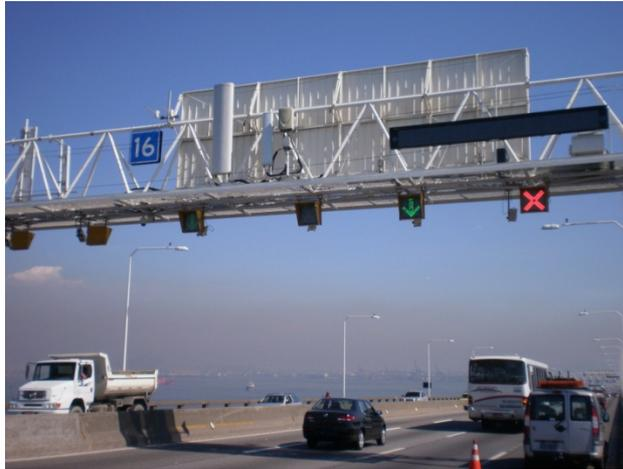
Mini PMV instalado no pórtico
