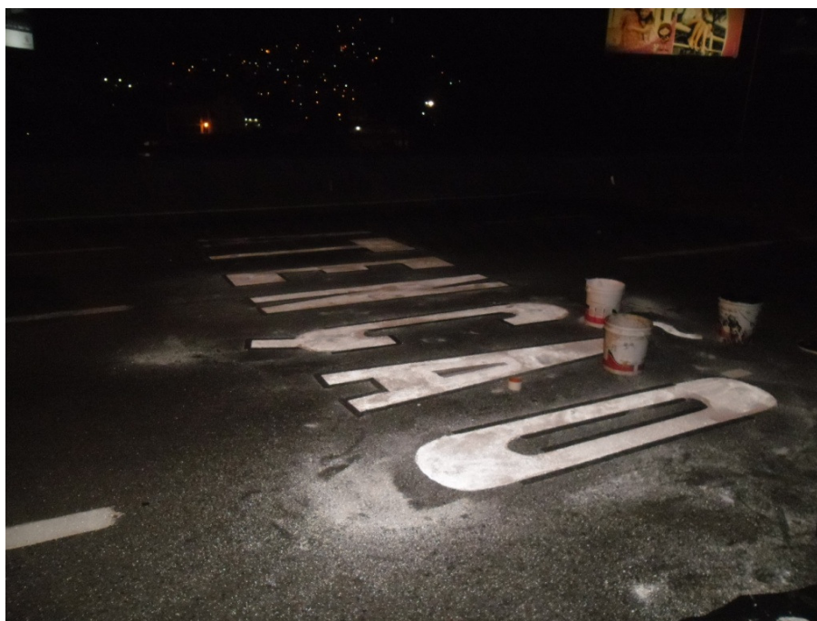
Foto 19 - Reparo localizado na pintura de texto indicativo no pavimento – Próximo ao poste 383 – Sentido Nit./RJ – Trecho sobre o Mar
