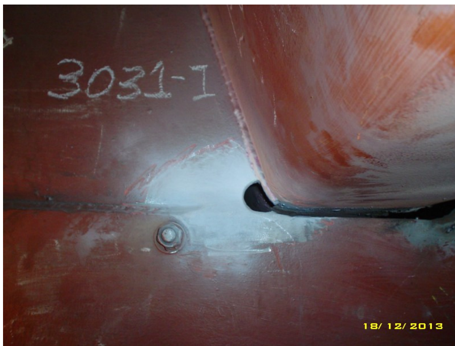
Foto 12 – Reparo da trinca 3031-I - Transversina SN 26/ – CMR 34N
