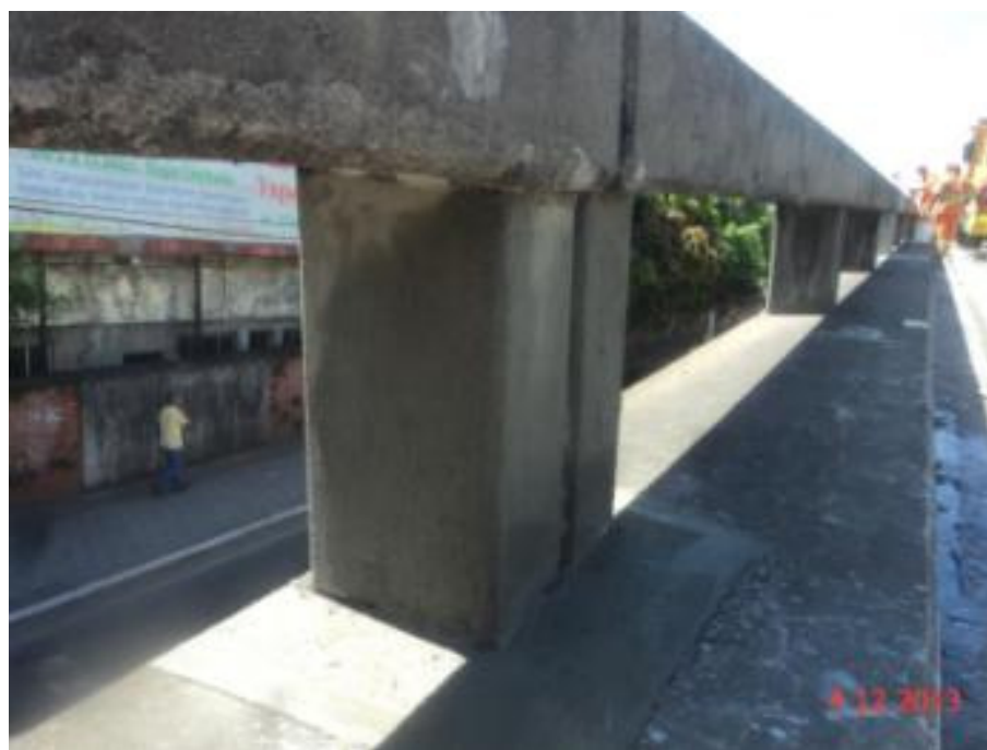
Foto 10 – Guarda-corpo de concreto recuperado – Próximo ao poste 14 – Rampa 8 – Acesso Niterói
