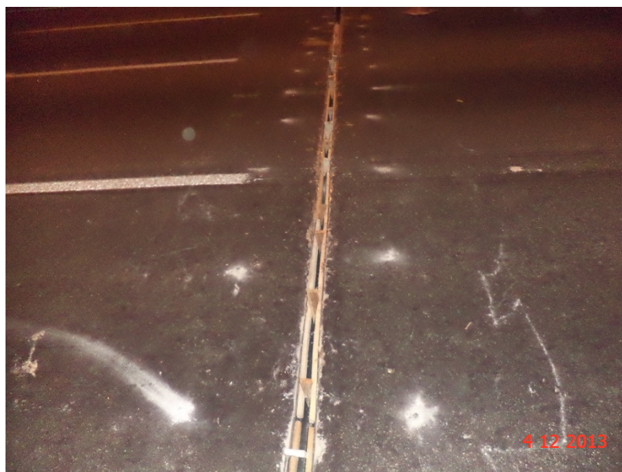
Foto 4 – Substituição do dispositivo de vedação - Vão 88/89 – Trecho sobre o Mar
