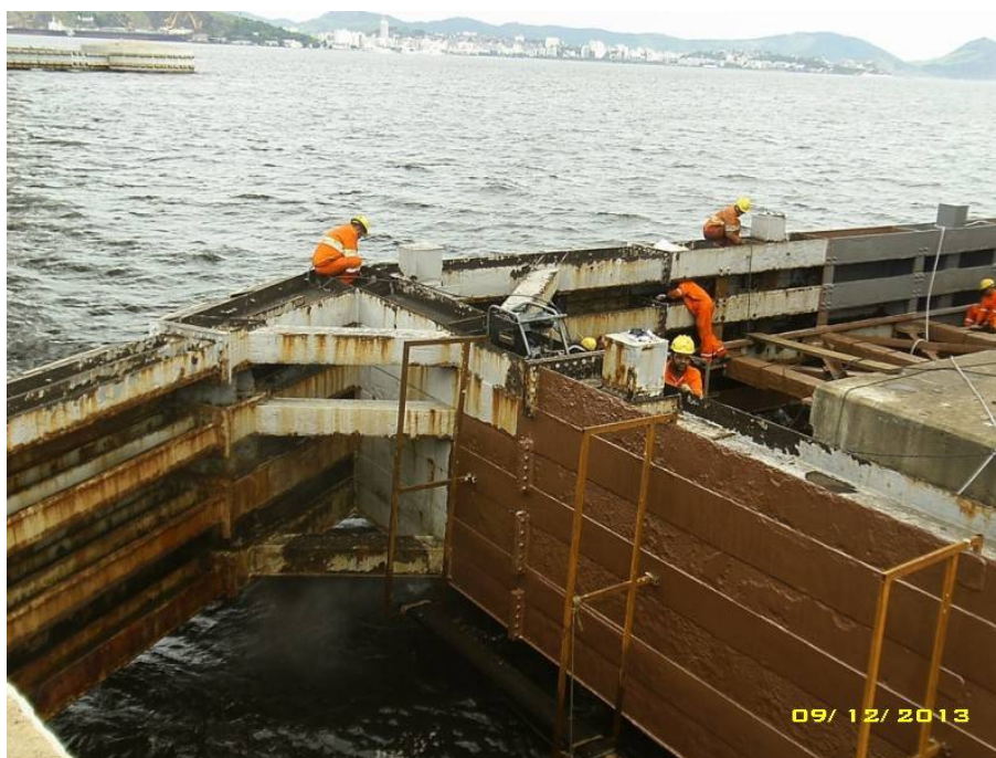
Foto 1 - Recuperação da estrutura metálica das defensas dos vãos navegáveis – Pilar 99 – Trecho sobre o Mar
