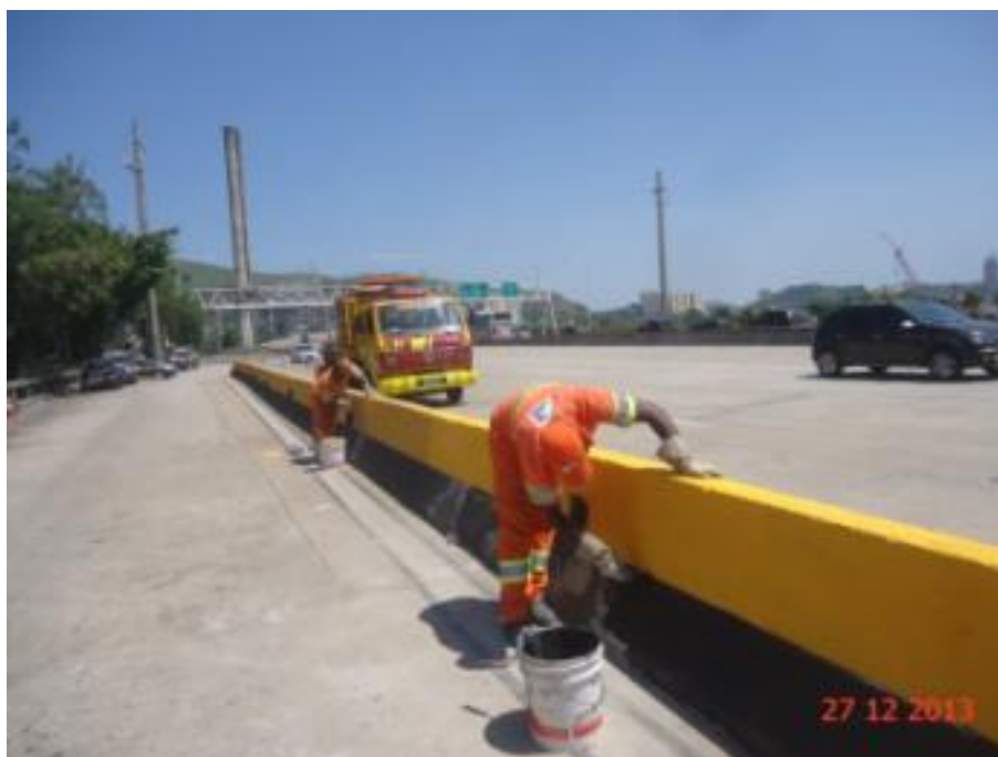
Foto 11 – Recuperação da mediana de concreto – Próximo a Base Operacional Niterói – Sentido Nit./RJ – Praça de Pedágio
