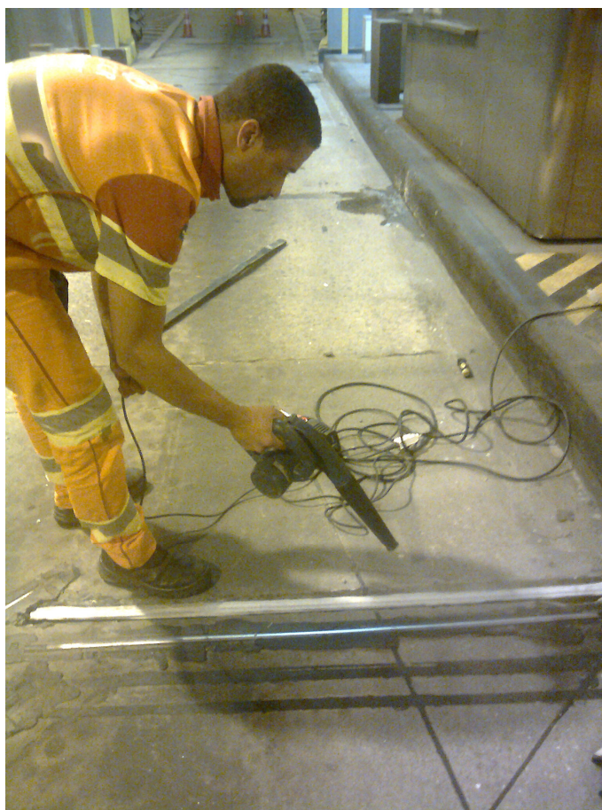
Foto 27 – Manutenção corretiva do sensor – Pista 3 de arrecadação - Praça de Pedágio
