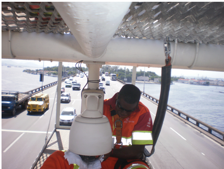
Foto 23 - Manutenção preventiva da câmera de CFTV – Pórtico 23 – Trecho sobre o Mar
