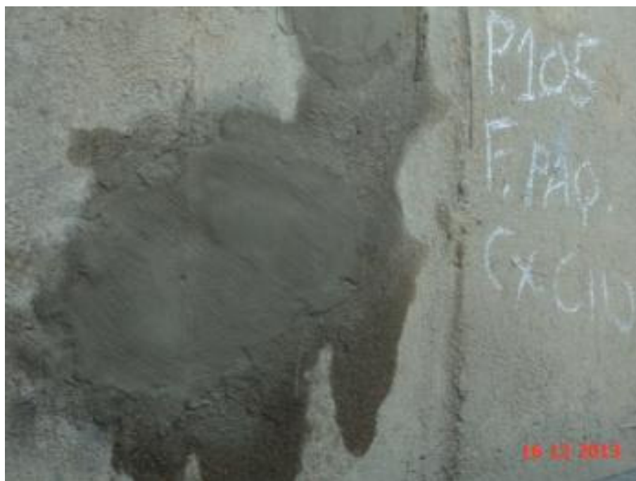
Foto 9 – Área de concreto desagregado recuperada – Pilar 105 - Sentido RJ/Nit. – Trecho sobre o Mar
