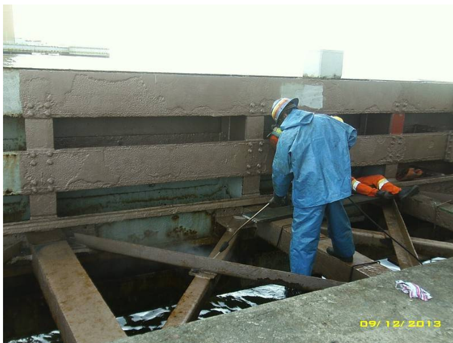
Foto 2 - Recuperação da estrutura metálica das defensas dos vãos navegáveis – Pilar 99 – Trecho sobre o Mar
