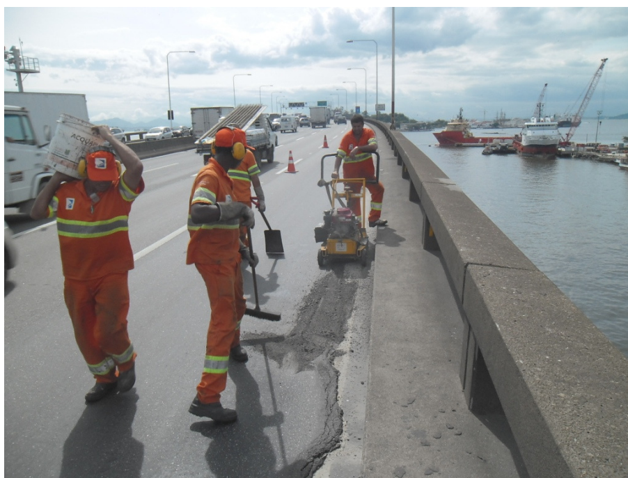
Foto 15 – Reparo localizado no pavimento flexível – Próximo ao poste 367 – Sentido Nit./RJ – Trecho sobre o Mar
