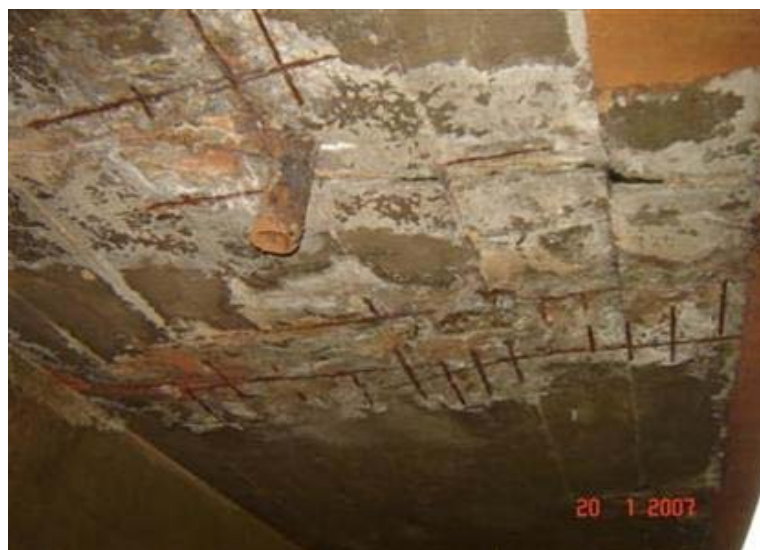
FOTO 5: Laje com C.D. + A.E.O.
