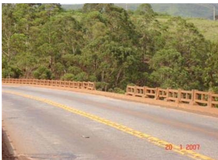
FOTO 4: Guarda - Corpo Faltante
