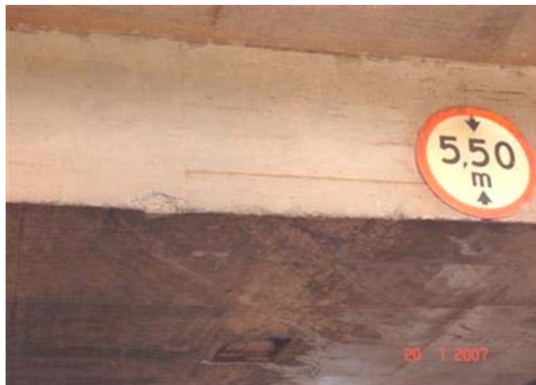
FOTO 5: Marca de Impacto na Laje
