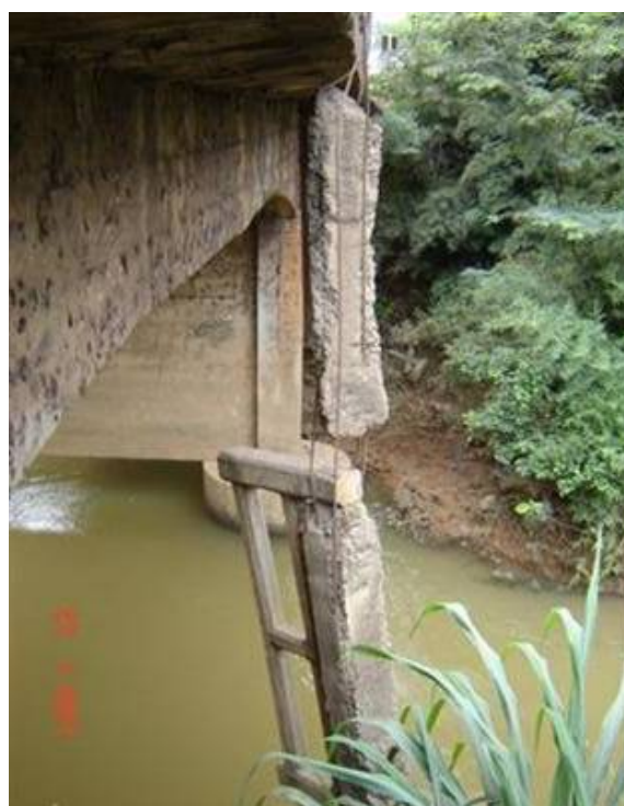
FOTO 4: Guarda - Corpo Rompido
