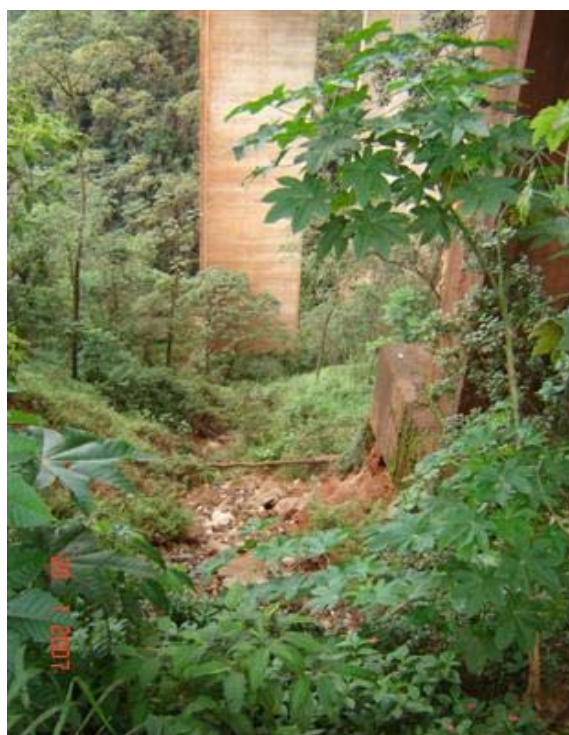
FOTO 4: Erosão c/ Desconfinamento
