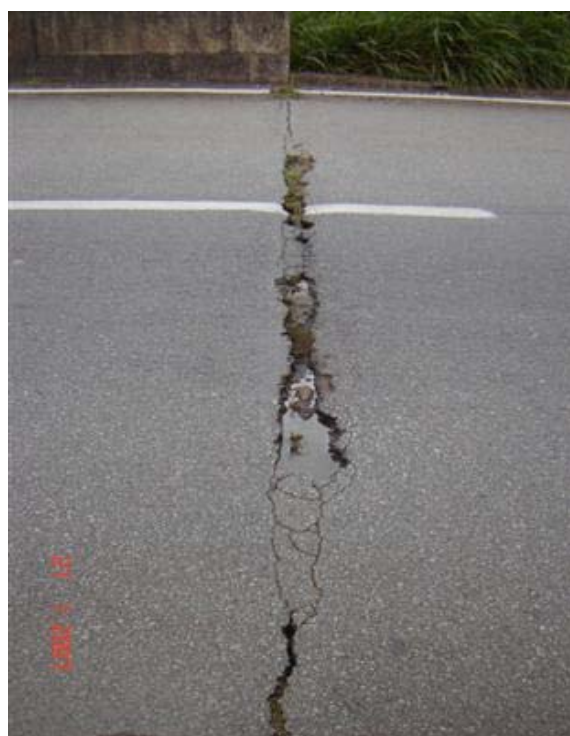
FOTO 4: Junta de Dilatação Deteriorada
