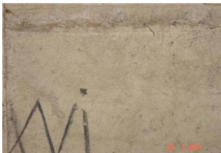
FOTO 5: Fissura na Lateral do Caixaão
