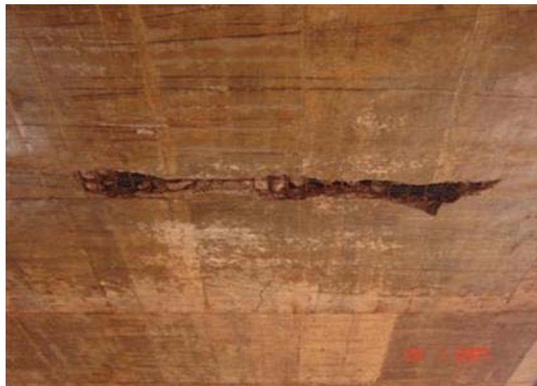
FOTO 4: Ruptura de Trecho da Laje
