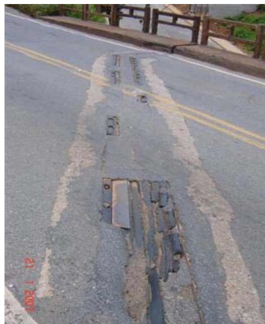
FOTO 5: Junta de Dilatação Deteriorada
