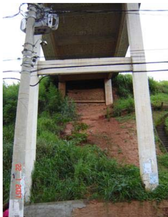
FOTO 4: Erosão Talude Encontro Sul
