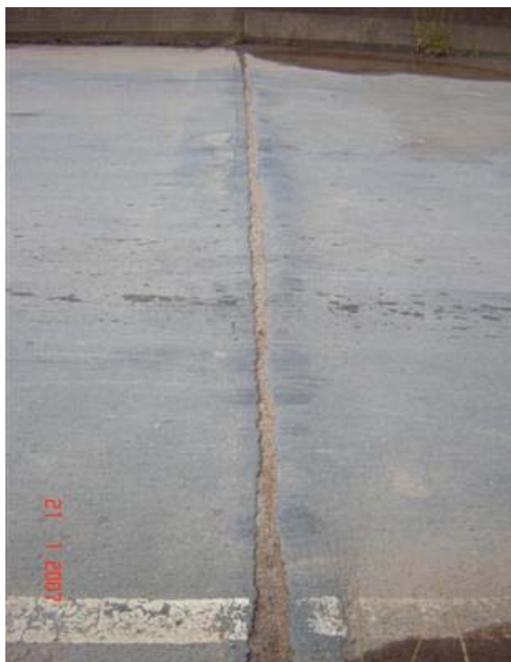
FOTO 4: Junta de Dilatação Deteriorada
