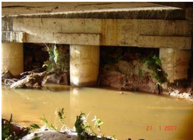
FOTO 4: Erosão no Talude Norte
