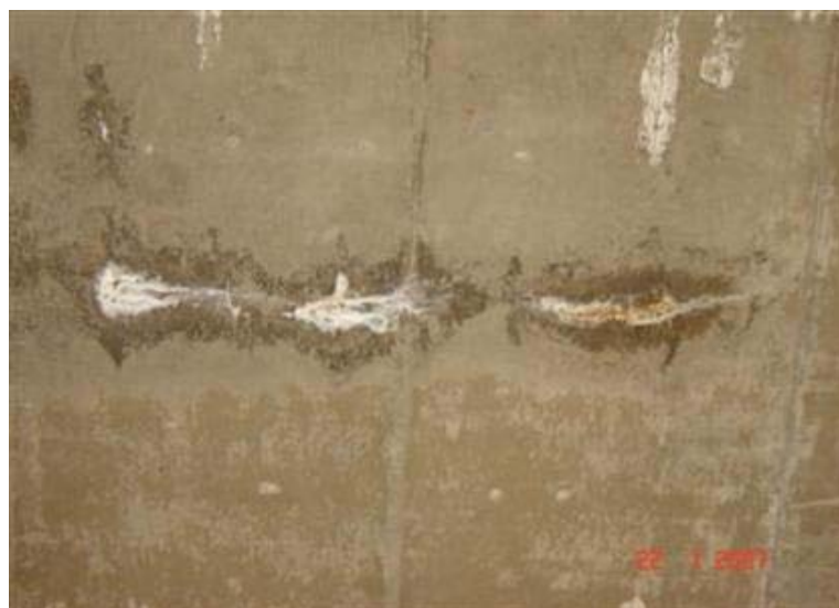
FOTO 4: Fissura com Carbonatação
