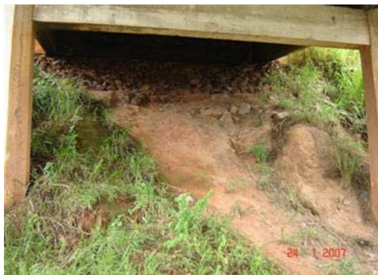
FOTO 4: Erosão no Talude Sul
