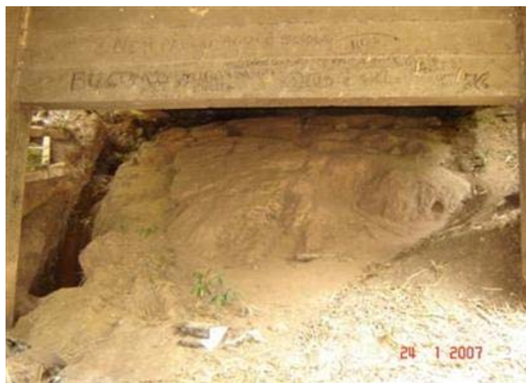
FOTO 4: Erosão no Terraplino
