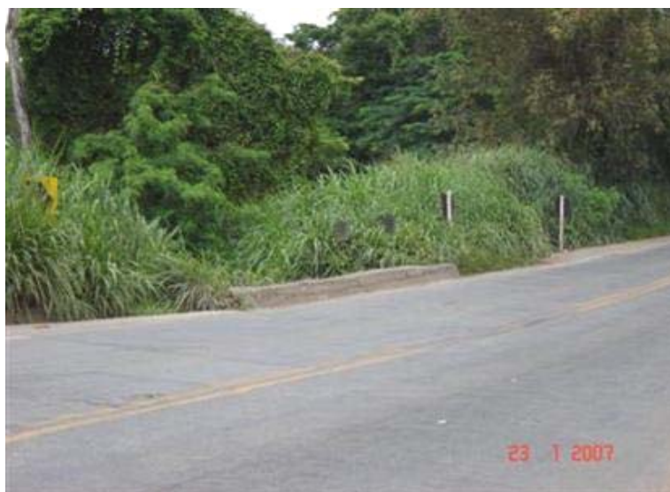
FOTO 2: Guarda - Corpo Faltante
