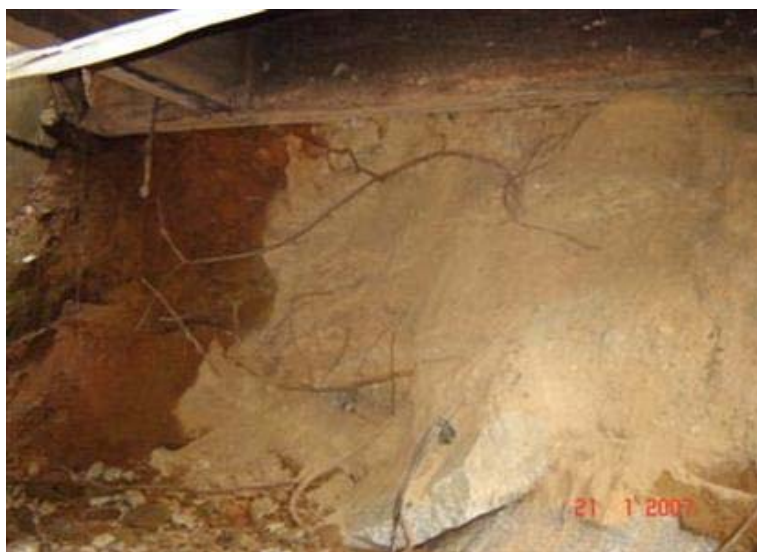
FOTO 4: Talude Norte Desprotegido
