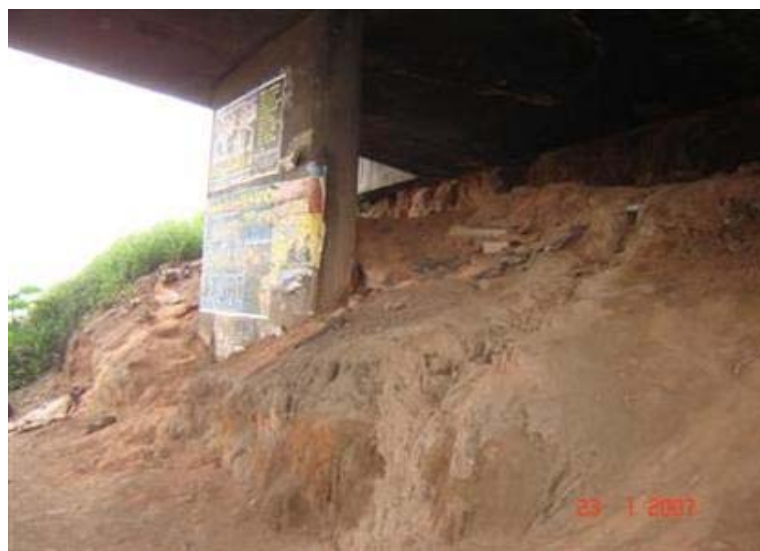
FOTO 4: Erosão no Talude de Encontro
