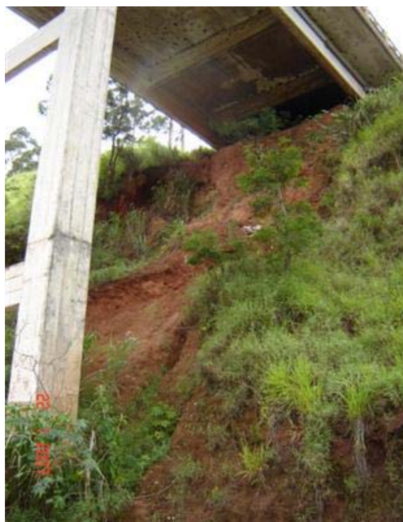
FOTO 4: Erosão no Talude Sul
