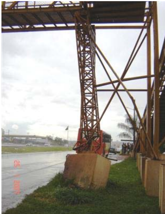
FOTO 3 e 4: Marcas do Impacto nos Pilares Metálicos
