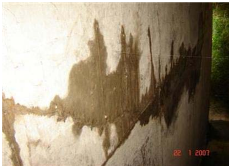
FOTO 4: Infiltração de água no Caixaão
