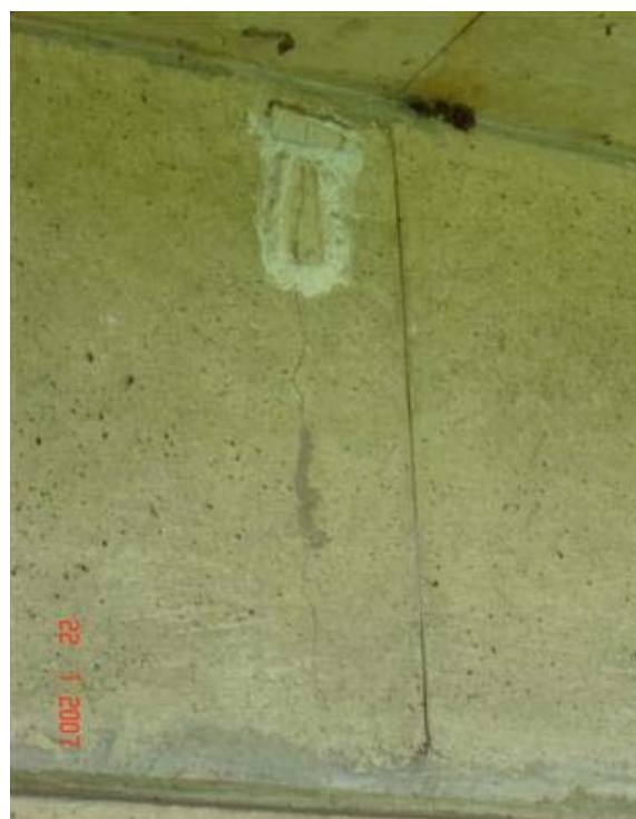
FOTO 4: Fissura na Lateral do Caixaão
