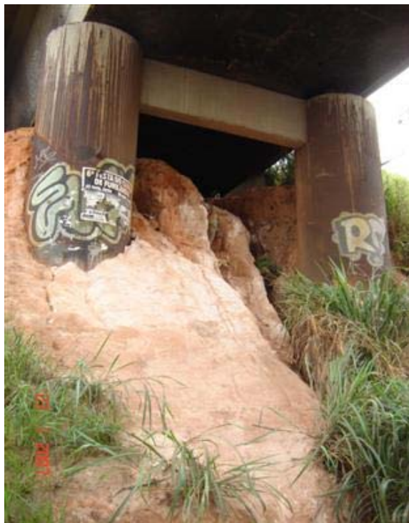
FOTOS 4 e 5: Erosão nos Taludes Desprotegidos
