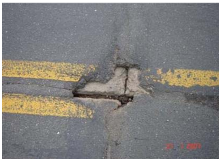
FOTO 4: Trinca no Pavimento
