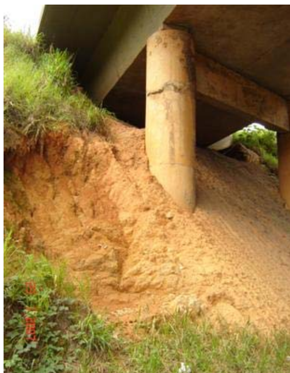
FOTO 4: Erosão no Talude Norte
