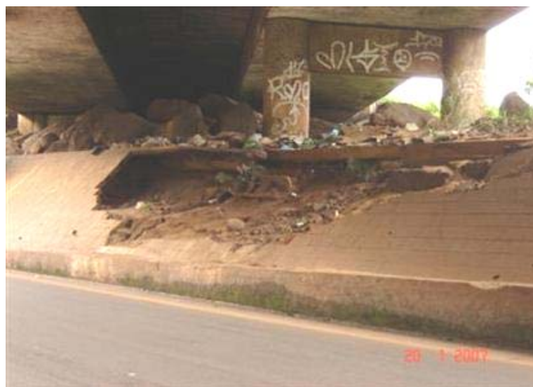
FOTO 4: Erosão no Talude Sul
