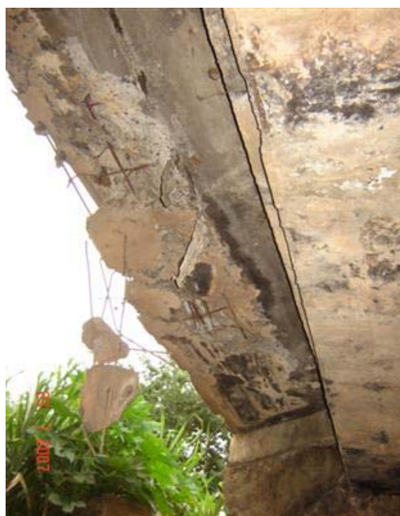
FOTO 4: Balanço Lateral Rompido
