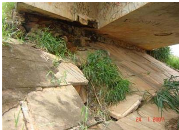
FOTO 4: Erosão Talude Encontro
