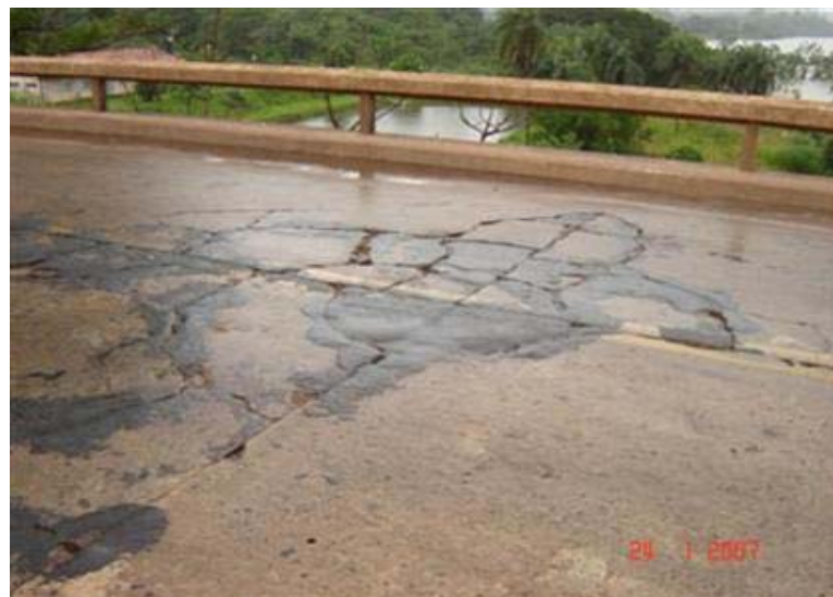
FOTO 5: Pavimento Rígido Deteriorado
