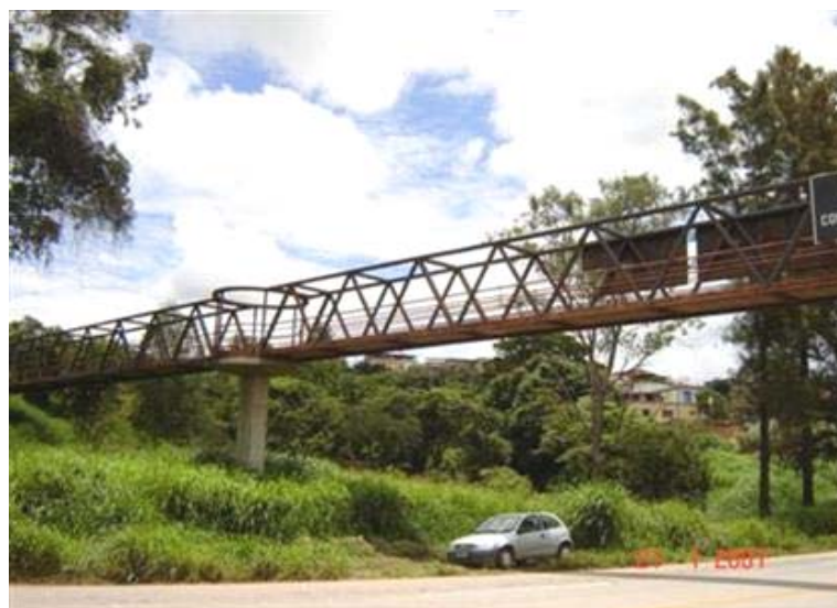
FOTO 4: Pilar e Trelça Metálica
