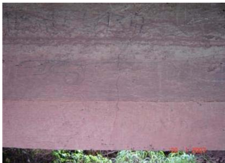
FOTO 4: Fissura Típica na Longarina
