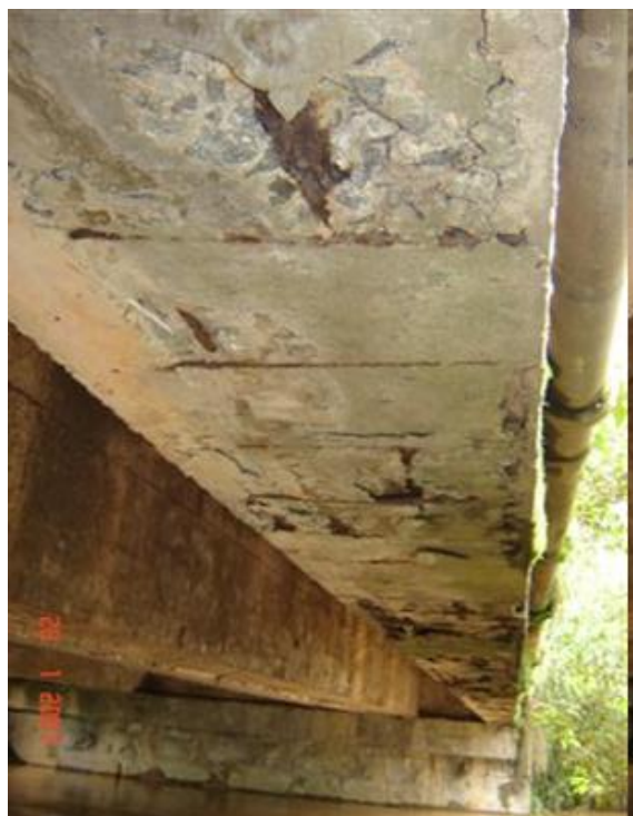
FOTO 4: Longarina c/ Armadura Exposta
