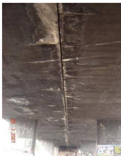
FOTO 5: Junta Longitudinal entre Obras
