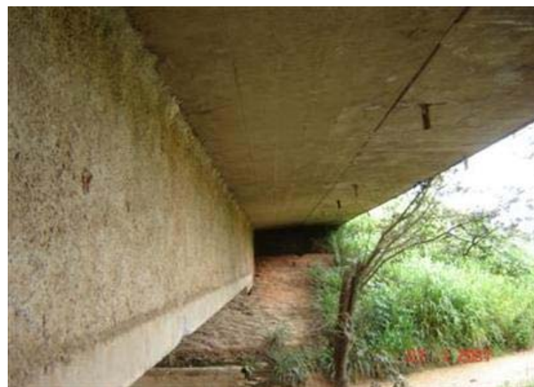
FOTO 4: Lateral da Longarina com Concreto Projetado
