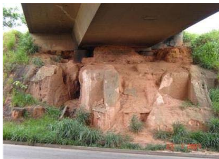
FOTO 4: Talude Leste com Erosão
