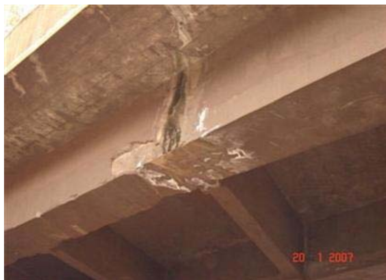
FOTO 4: Marca de Impacto na Viga
