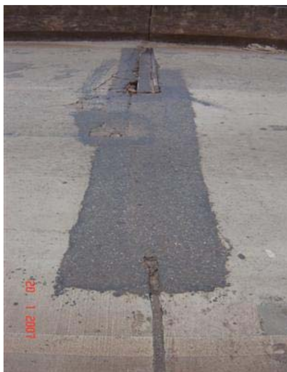
FOTO 4: Pavimento Rígido Deteriorado
