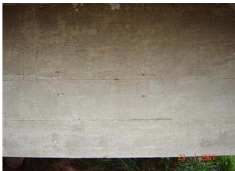
FOTO 4: Fissura na Viga Longarina
