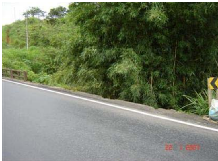
FOTO 3: Guarda - Corpo Faltante
