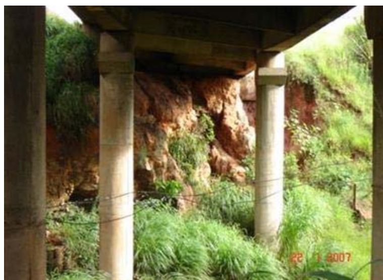
FOTO 4: Erosão no Talude Sul
