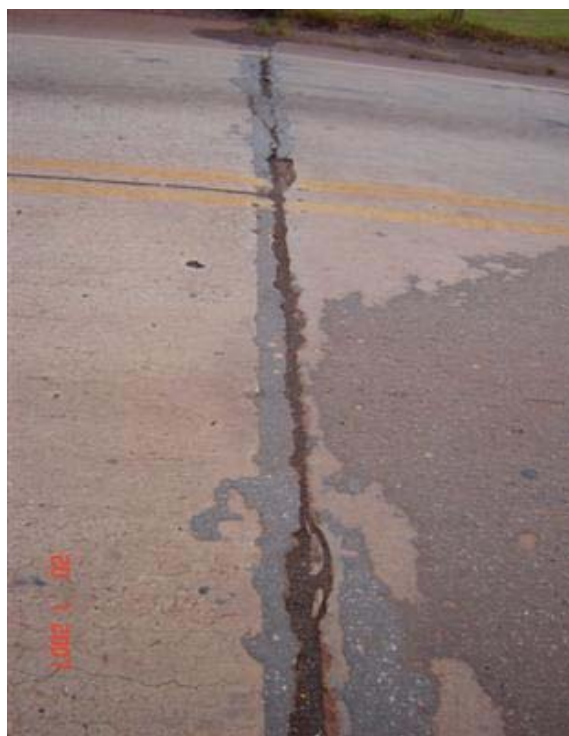
FOTO 4: Trinca na Pista Enc. Sul
