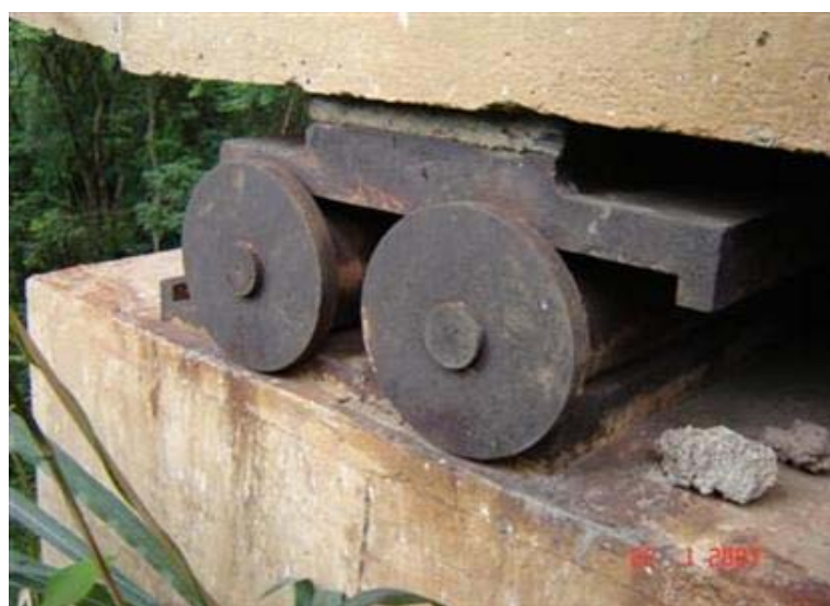
FOTO 4: Ap. Apoio Rolete Metálico
