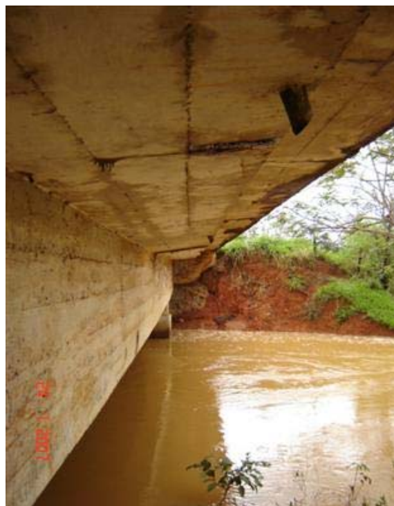
FOTO 4: Erosão no Talude Sul
