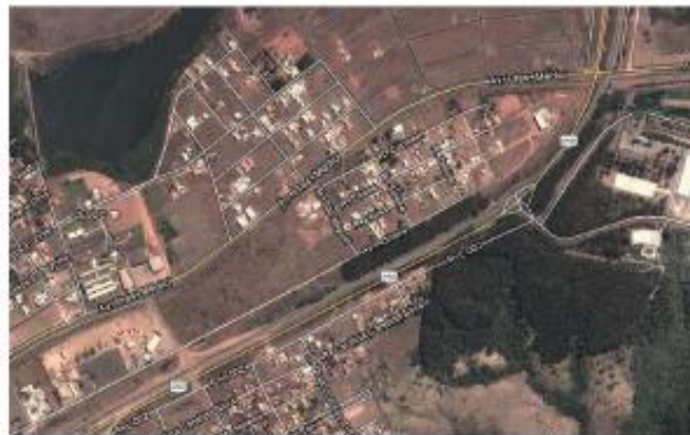
Figura 2: Vista aérea do trevo de acesso utilizado atualmente pela maioria dos caminhões que se dirigem a Anglo American Fosfatos e misturadoras de fertilizantes.
