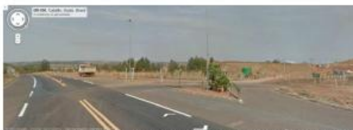
Figura 14: Outra vista do acesso para as atividades da mina Boa Vista da Anglo American Nióbio na altura do km 263 da BR-050.
