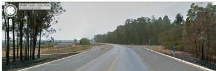
Figura 9: Trecho da BR-050 onde poderá ser alocado a Interseção tipo Diamante para acesso às misturadoras, Anglo American Fosfatos e Vale Fertilizantes, previsto na alternativa de estudo 2.
