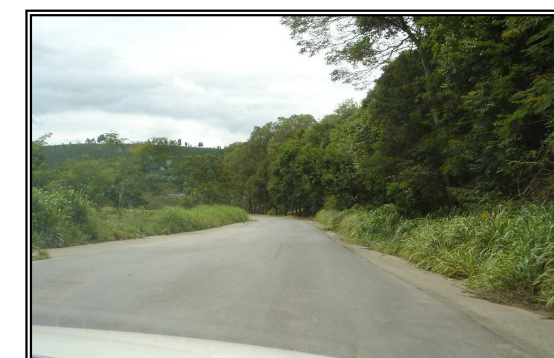
Trecho sem qualquer sinalização vertical, acostamento desnivelado invadido pela vegetação
