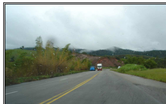
Trecho de serra com terceira faixa, sem defensas e sem linha de bordo
