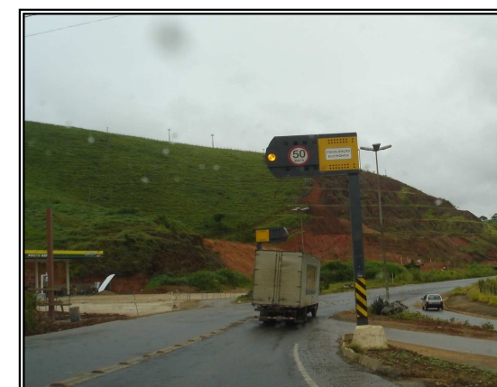
Linha dupla amarela com tachões, fiscalização eletrônica de velocidade
