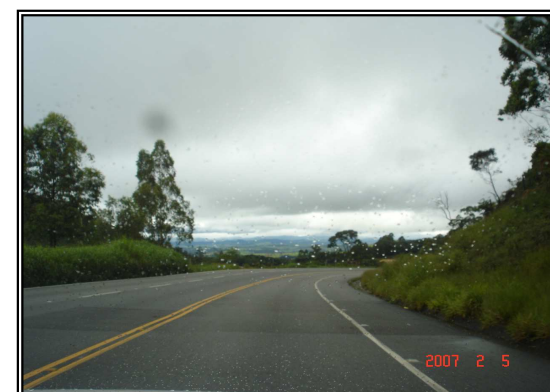
Sinalização horizontal adequada, com tachas refletivas no bordo e na dupla amarela
