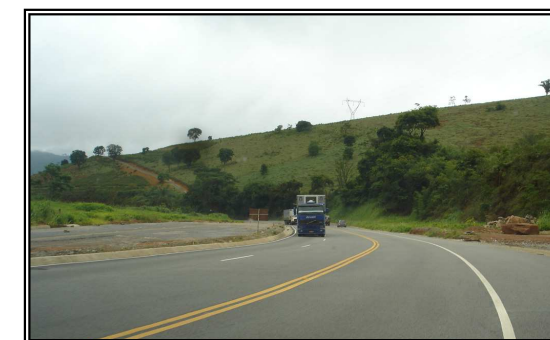
Sinalização horizontal completa, acostamento nivelado
