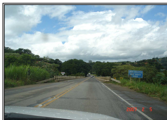
Sinalização horizontal completa, inclusive com tachas refletivas
