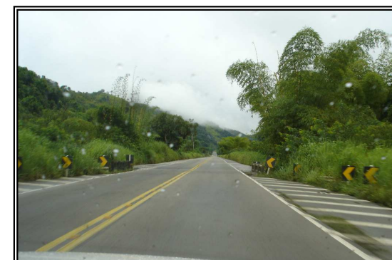
Marcadores de perigo na aproximação de ponte, linha separadora de fluxos
