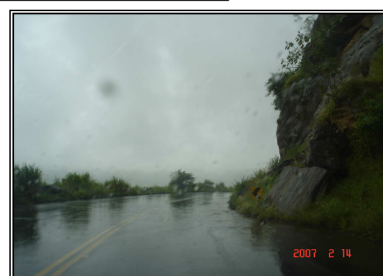
Sinalização horizontal apenas com dupla amarela, curva sem proteção, marcadores de perigo insuficientes
