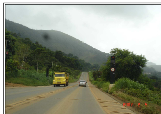
Linha separadora de fluxos com tachões, fiscalização eletrônica de velocidade
