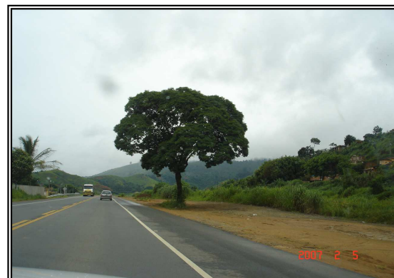
Sinalização horizontal adequada, com defensas metálicas insuficientes (árvore sem proteção)
