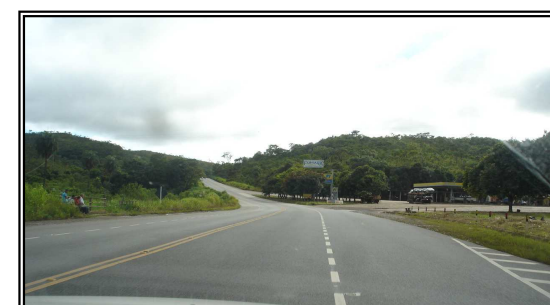
Linha seccionada com tachas refletivas, linha de bordo incompleta
