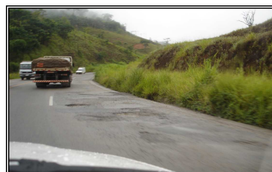
Pavimento ruim, buracos na terceira faixa, falta de sinalização vertical e horizontal irregular
