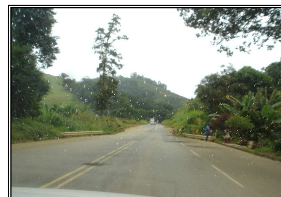
Estreitamento de pista para passagem sobre ponte sem sinalização de advertência
