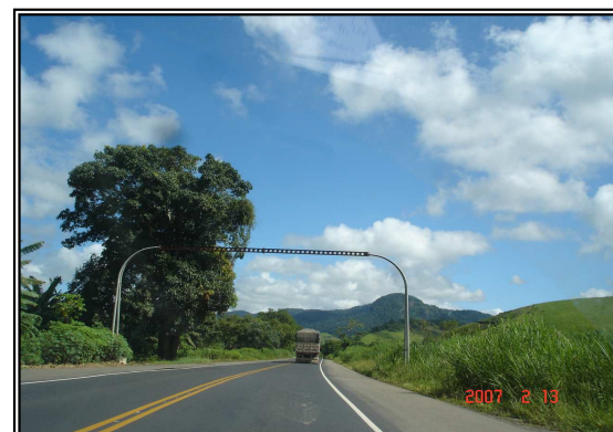
Pórtico sem placa de sinalização, acostamento desnivelado, sinalização horizontal em boas condições
