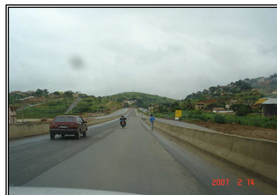
Trecho de pista dupla, com barreiras rígidas sem sinalização horizontal (Governador Valadares)
