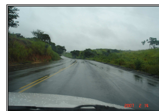
Pavimento bom e sinalização horizontal apenas com dupla amarela, sinalização vertical insuficiente
