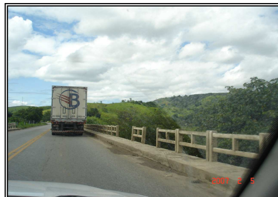
Sobre ponte, falta pintura de bordo, tachas no bordo estão desgastadas, mureta acidentada
