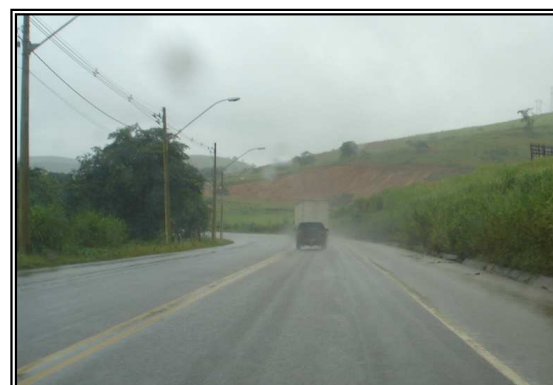
Sinalização horizontal adequada, acostamento nivelado e vertical insuficiente (faltam placas de advertência em curvas)
