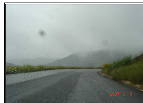
Trecho sem sinalização horizontal, curva sem proteção
