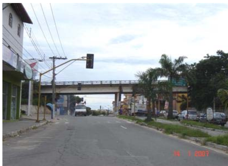
FOTO 2: Vista Lateral da Obra
