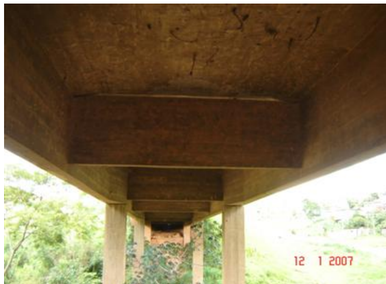
FOTO 3: Vista Inferior da Obra
