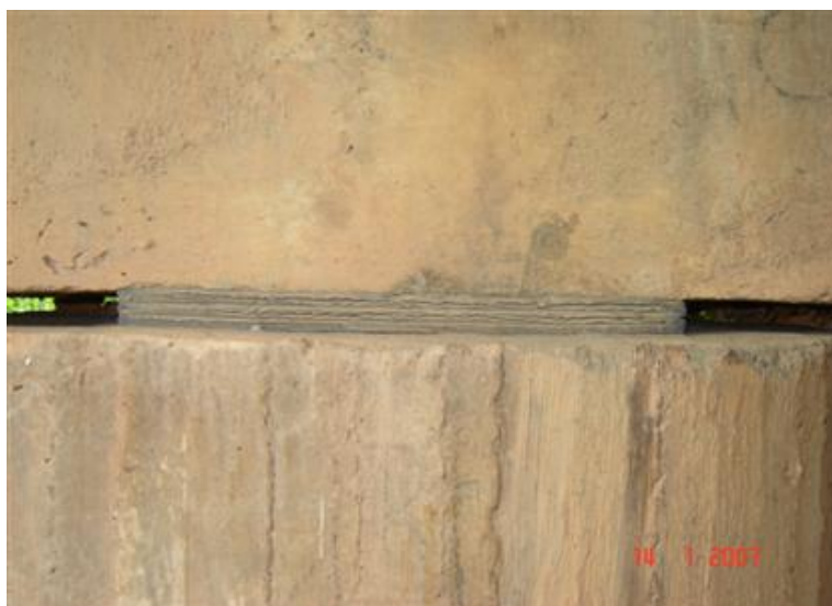
FOTO 4: Aparelho de Apoio Neoprene
