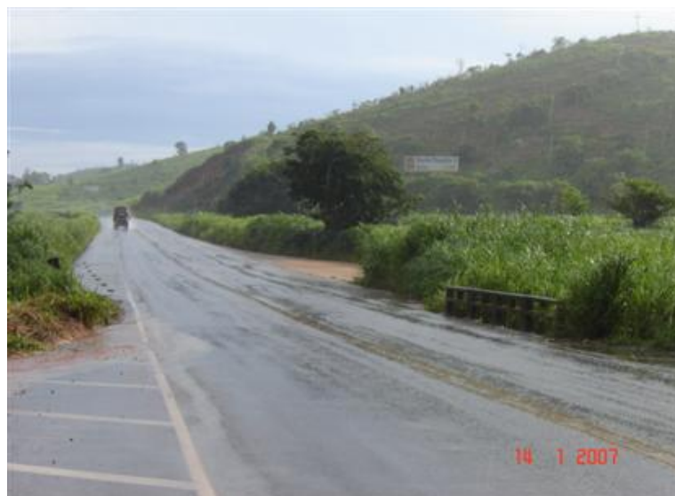
FOTO 1: Vista Superior da Obra
