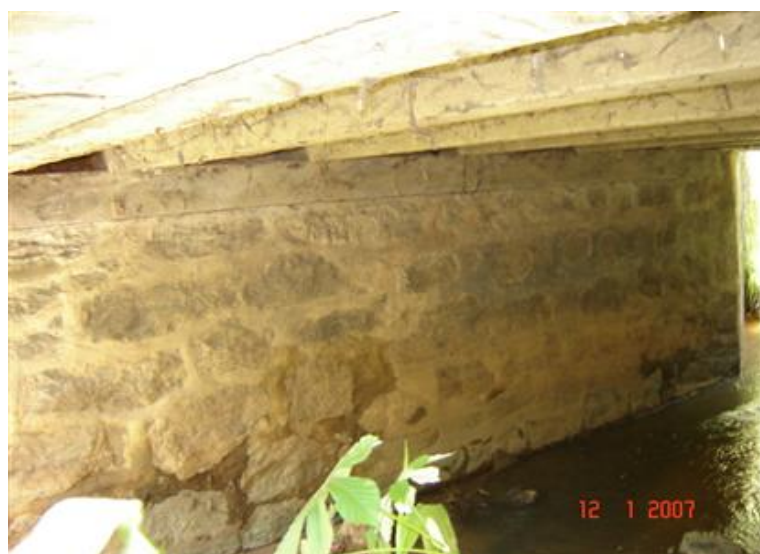
FOTO 4: Vista Lateral Inferior da Obra
