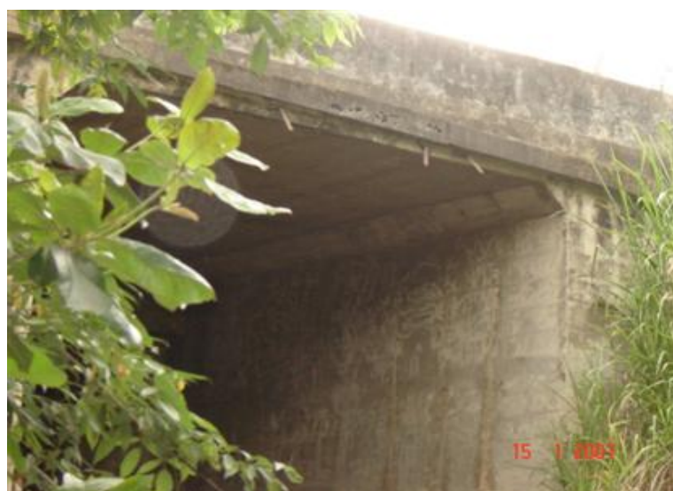
FOTO 4: Vista Lateral Trecho Laje
