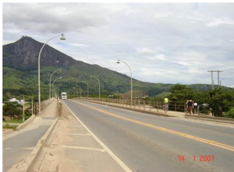
FOTO 1: Vista Superior da Obra
