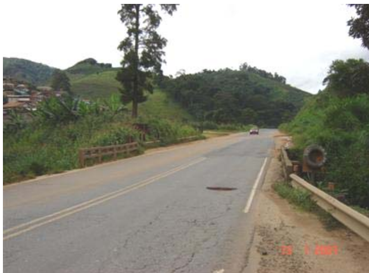
FOTO 1: Vista Superior da Obra
