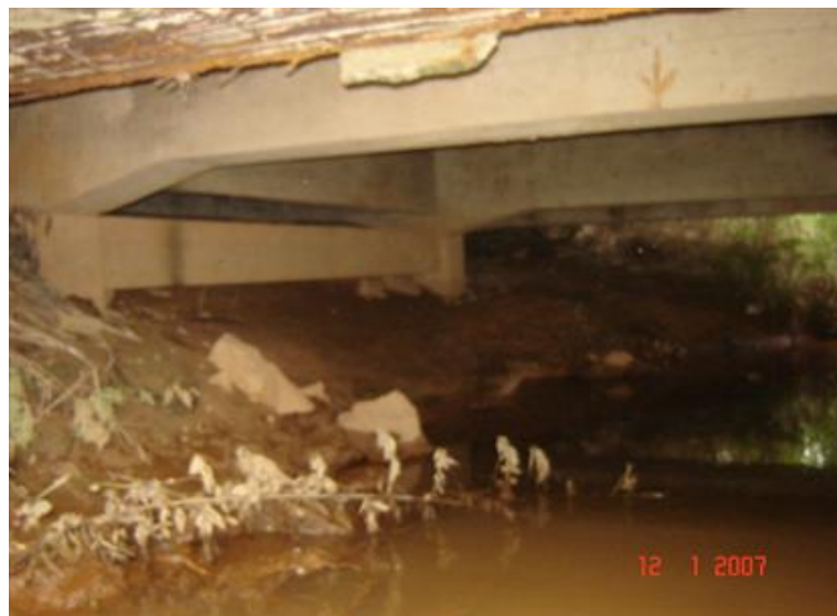
FOTO 3: Vista Inferior da Obra
