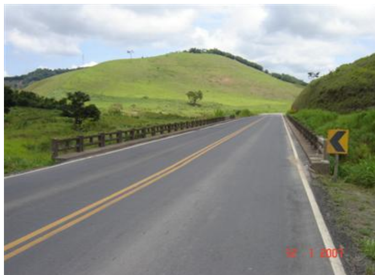
FOTO 1: Vista Superior da Obra
