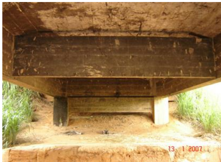
FOTO 3: Vista Inferior da Obra
