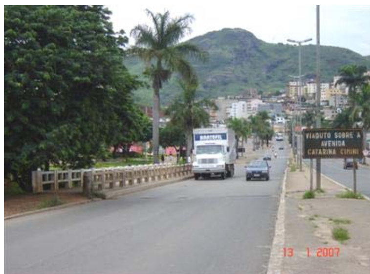
Vista Superior da Obra
