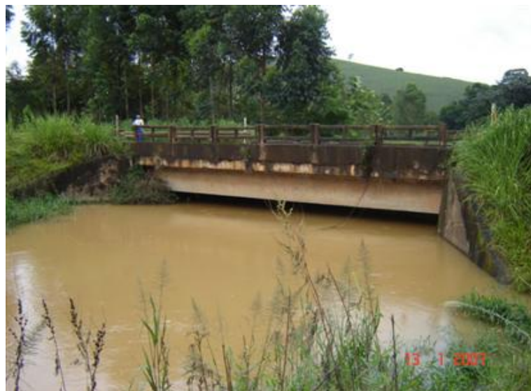
FOTO 3: Vista Lateral Leste da Obra
