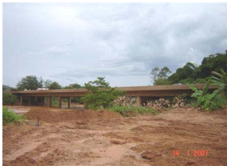
Vista Lateral da Obra
