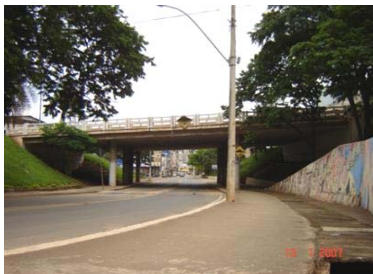
Vista Lateral da Obra
