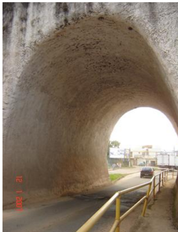
FOTO 3: Vista Interior da Obra
