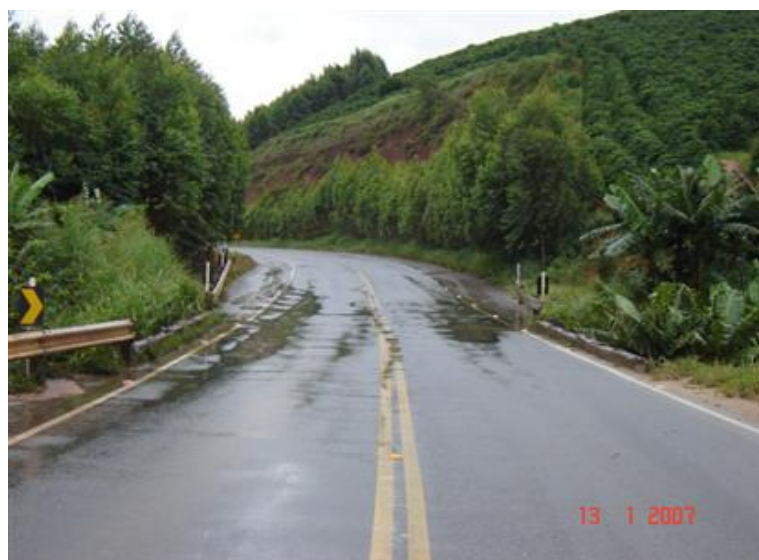
FOTO 1: Vista Superior da Obra
