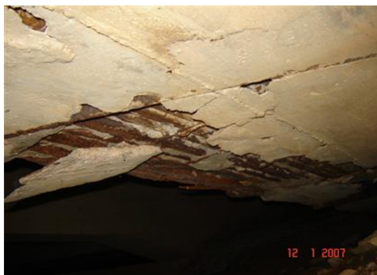
FOTO 4: Laje c/ C.D. + A.E.O.
