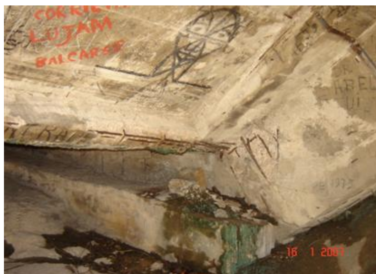
FOTO 4: Trecho com C.D. + A.E.O.
