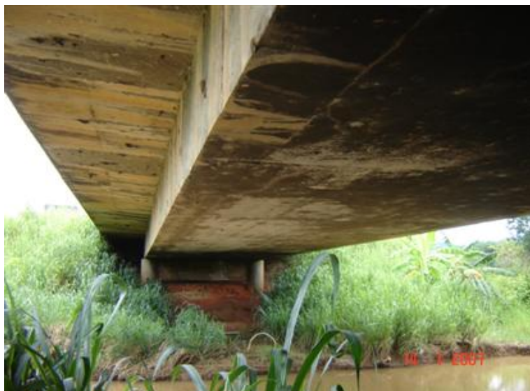
FOTO 3: Vista Inferior da Obra
