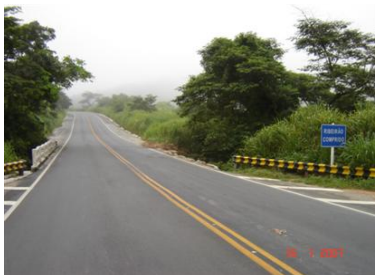
FOTO 1: Vista Superior da Obra
