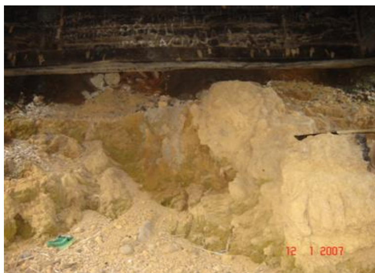
FOTO 4: Terrapleno encontro norte
