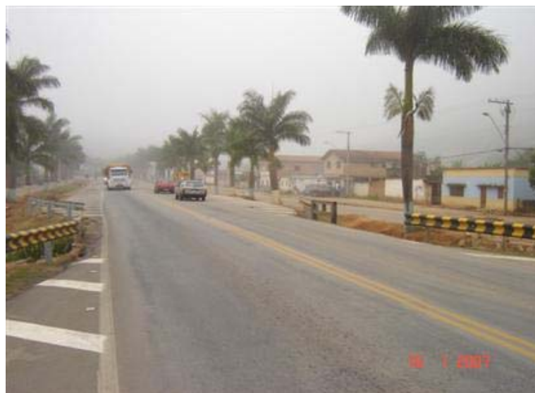
FOTO 1: Vista Superior da Obra
