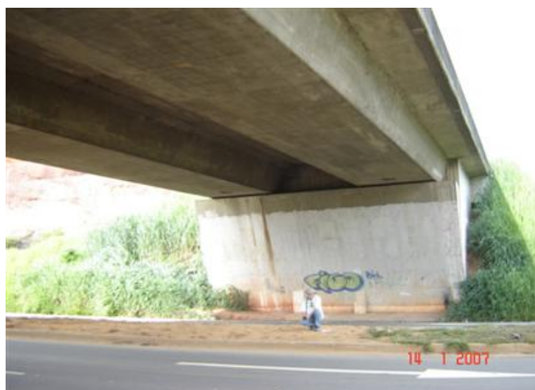
FOTO 4: Vista Lateral Inferior da Obra
