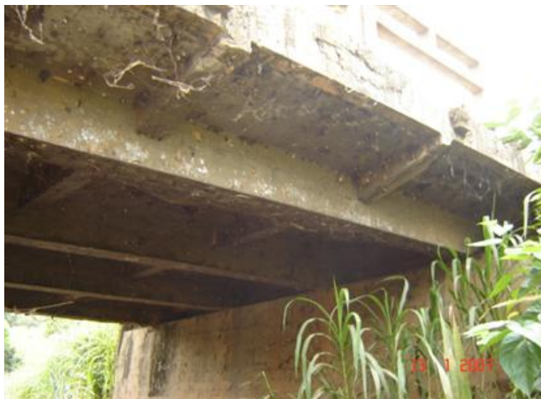
FOTO 3: Vista Inferior da Obra
