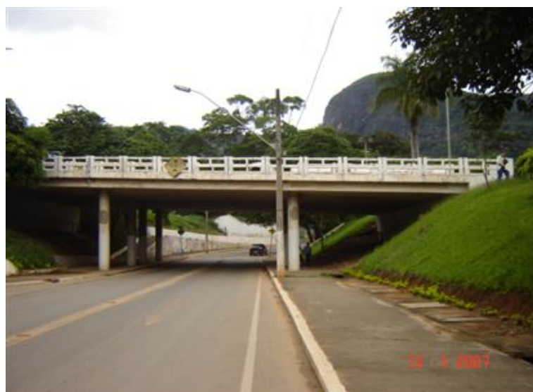
Vista Lateral da Obra
