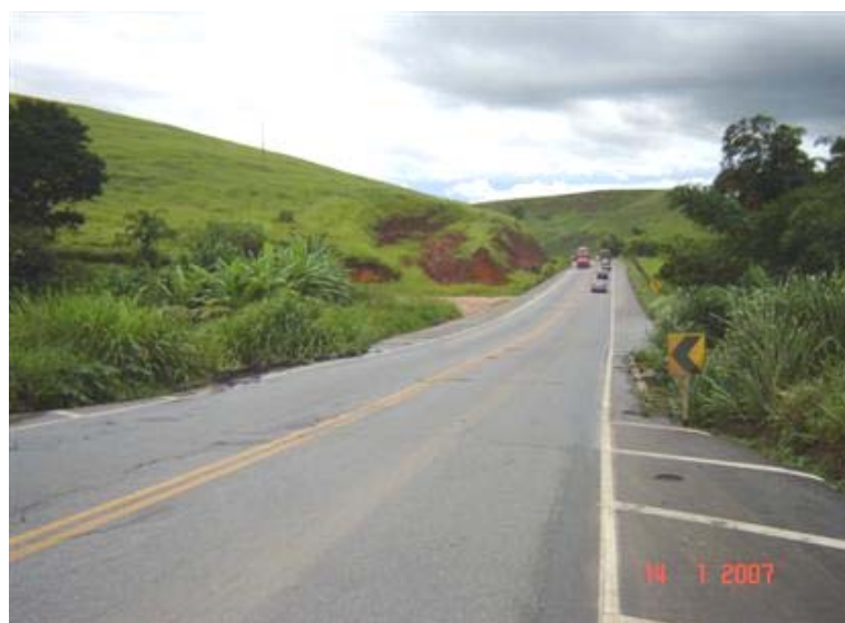
FOTO 1: Vista Superior da Obra
