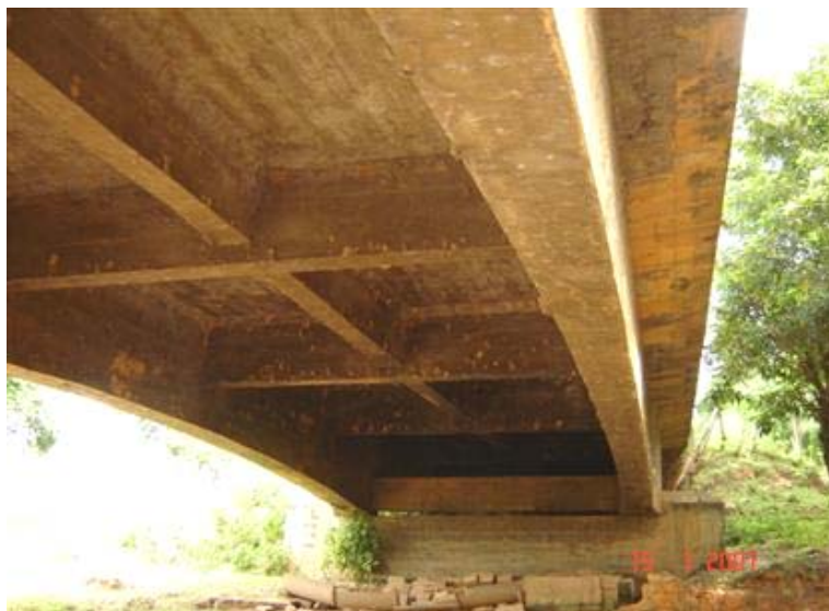
FOTO 3: Vista Inferior da Obra
