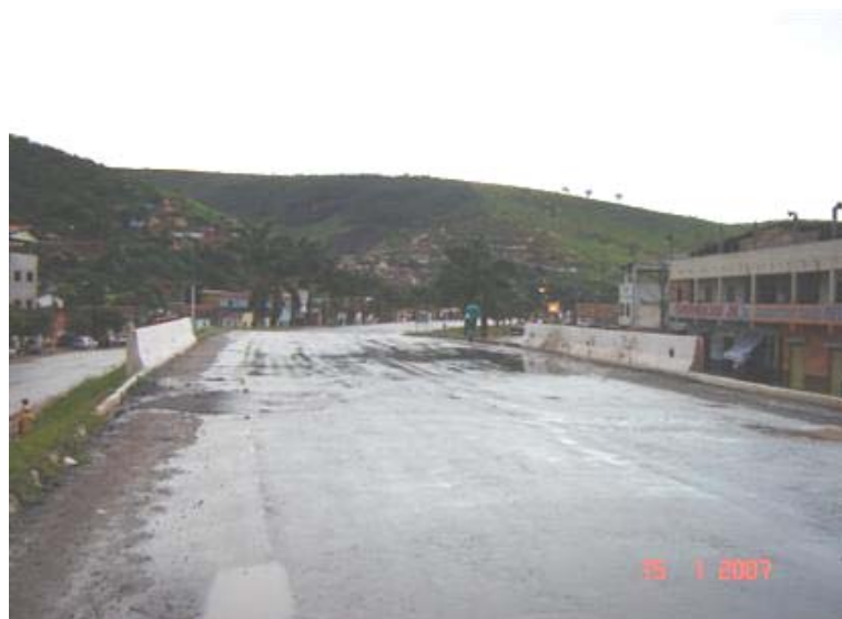
FOTO 1: Vista Superior da Obra
