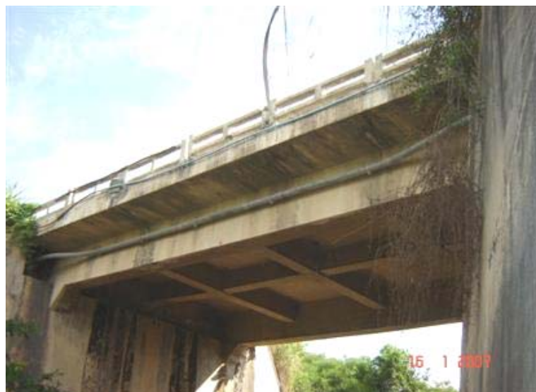
FOTO 2: Vista Lateral Inferior da Obra
