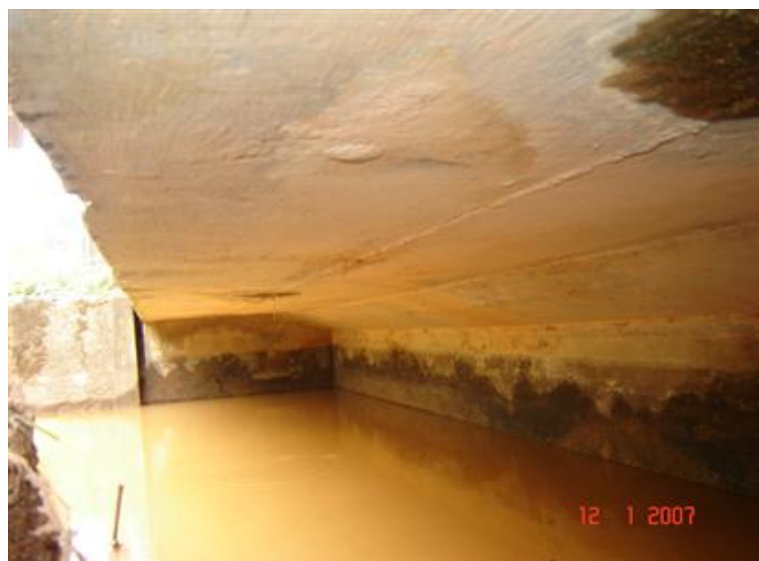
FOTO 3: Vista Inferior da Obra
