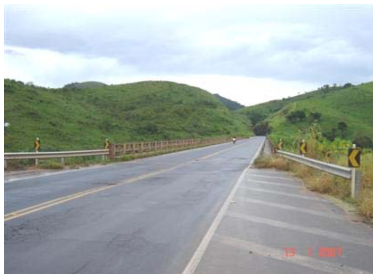
FOTO 1: Vista Superior da Obra
