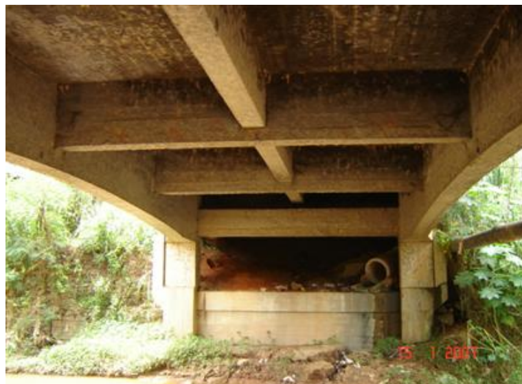
FOTO 3: Vista Inferior da Obra
