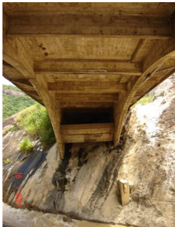
FOTO 3: Vista Inferior da Obra
