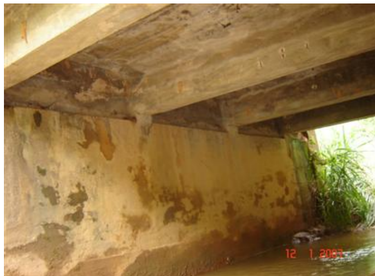
FOTO 3: Vista Inferior da Obra
