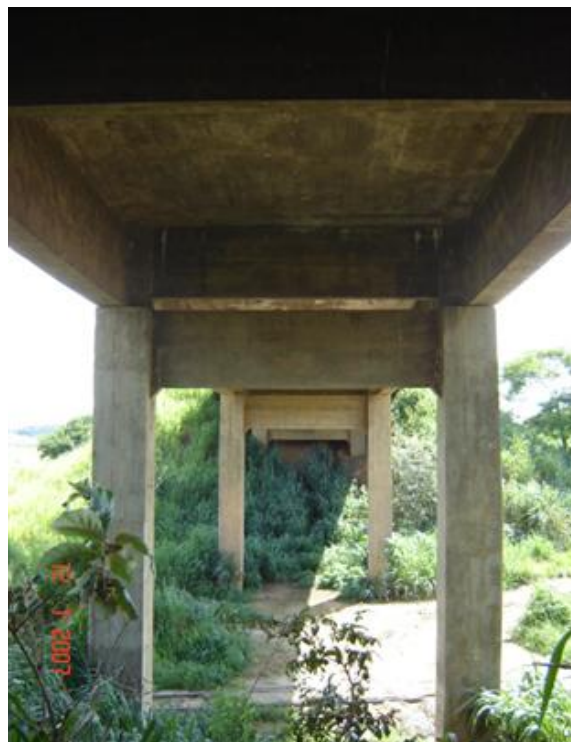
FOTO 3: Vista Inferior da Obra
