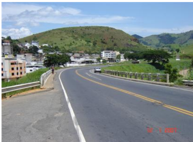
FOTO 1: Vista Superior da Obra
