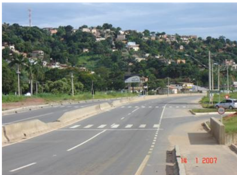
FOTO 1: Vista Superior da Obra
