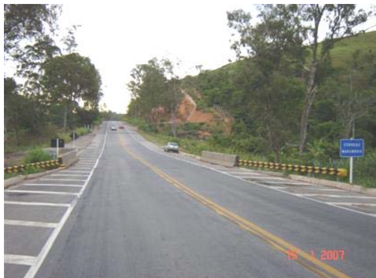
FOTO 1: Vista Superior da Obra
