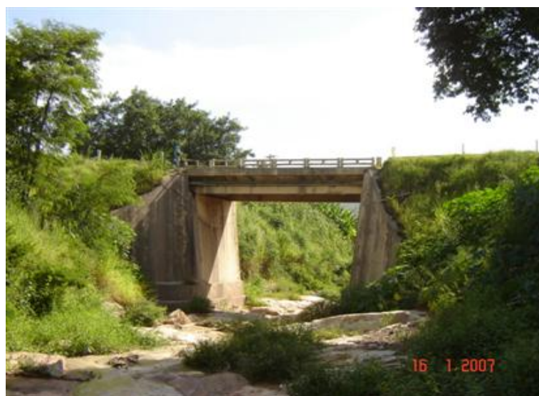
FOTO 2: Vista Lateral da Obra
