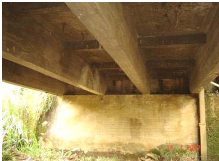
FOTO 3: Vista Inferior da Obra
