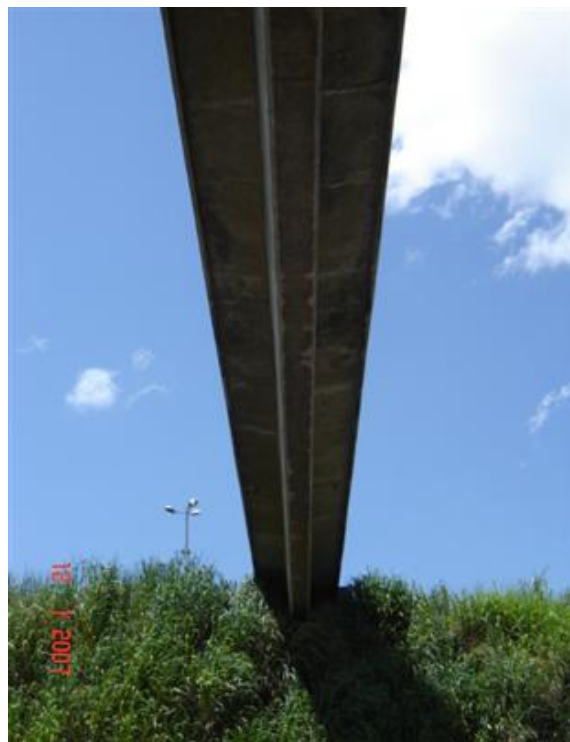
FOTO 3: Vista Inferior da Obra
