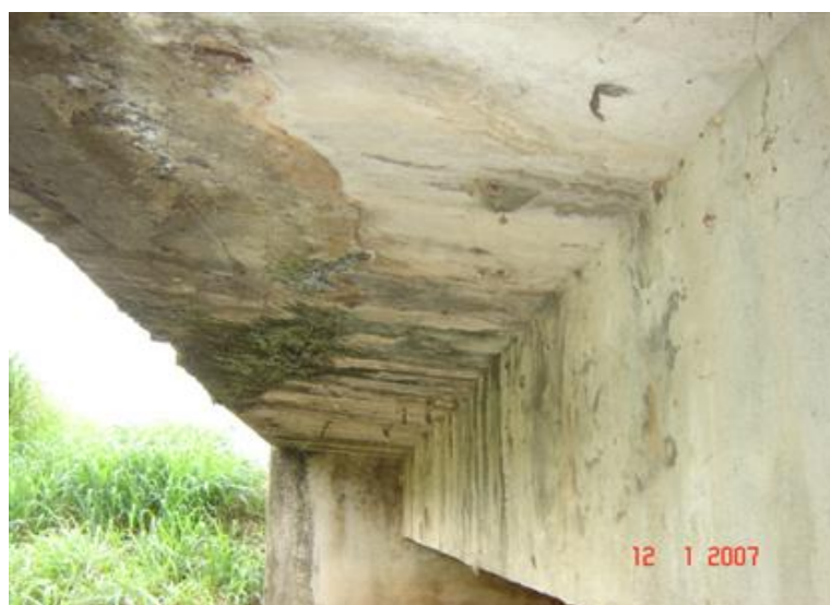
FOTO 4: Vista Lateral Inferior da Obra
