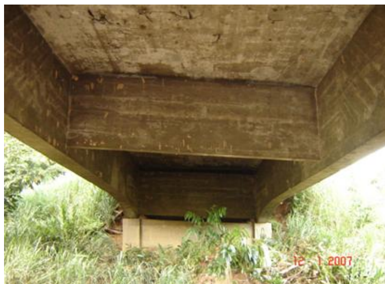
FOTO 3: Vista Inferior da Obra
