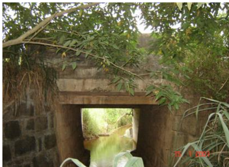
FOTO 2: Vista Lateral Trecho Grelha
