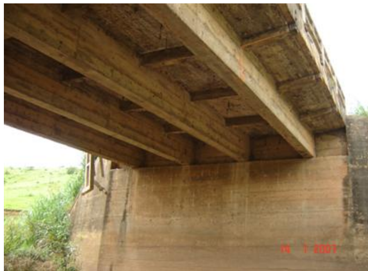
FOTO 3: Vista Inferior da Obra
