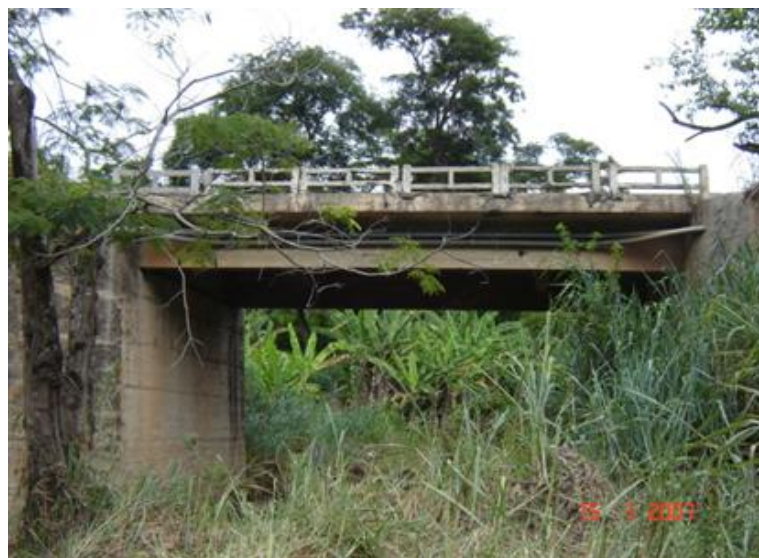
FOTO 2: Vista Lateral da Obra
