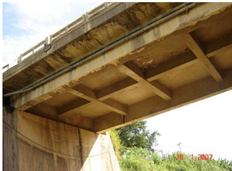
FOTO 3: Vista Inferior da Obra
