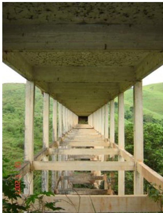
FOTO 3: Vista Inferior da Obra
