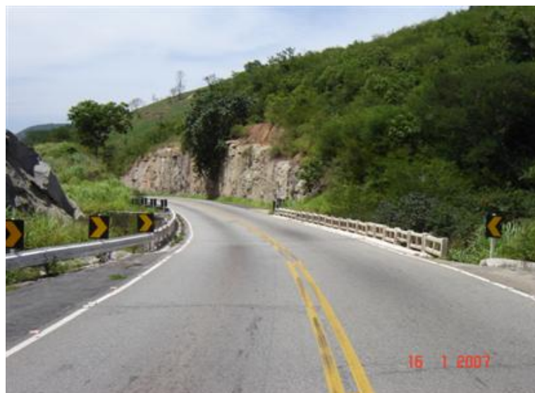
FOTO 1: Vista Superior da Obra
