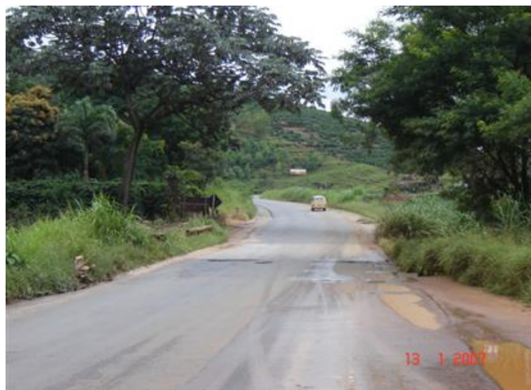
FOTO 1: Vista Superior da Obra
