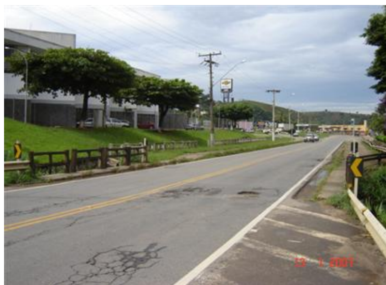
FOTO 1: Vista Superior da Obra
