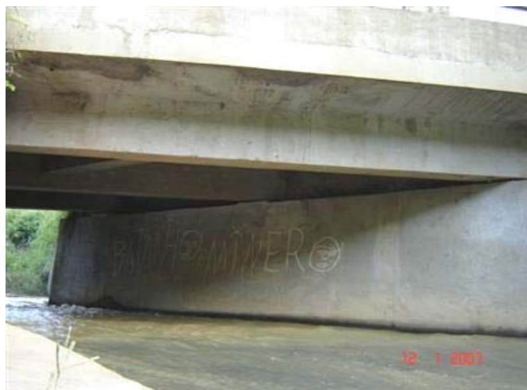
FOTO 3: Vista Inferior da Obra
