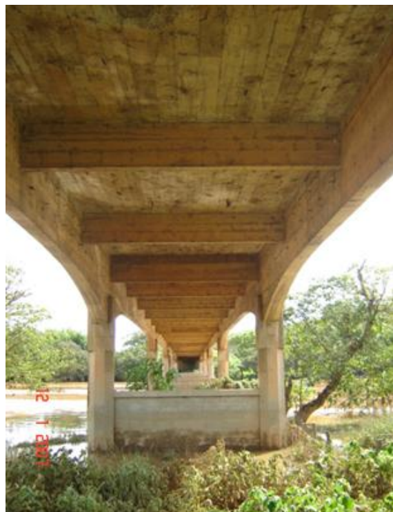
FOTO 3: Vista Inferior da Obra
