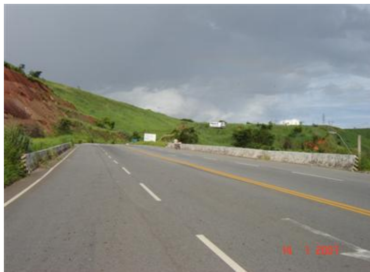
FOTO 1: Vista Superior da Obra
