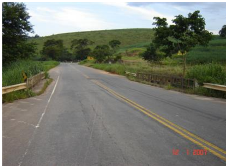
FOTO 1: Vista Superior da Obra
