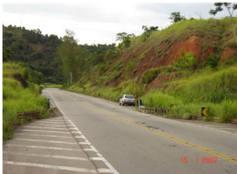
FOTO 1: Vista Superior da Obra
