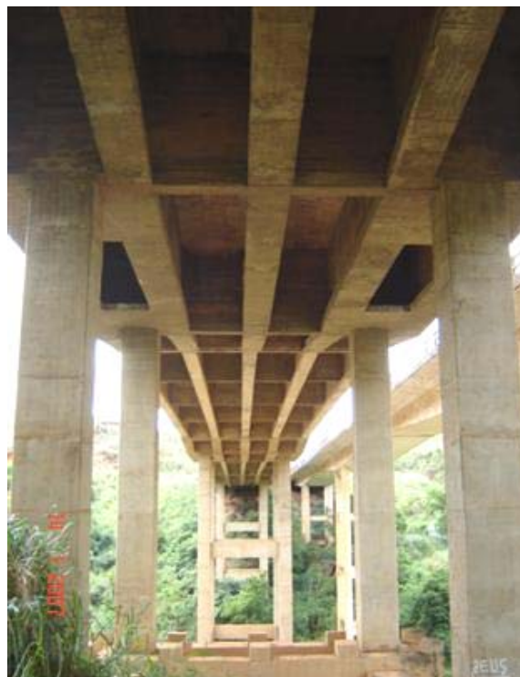
FOTO 3: Vista Inferior da Obra
