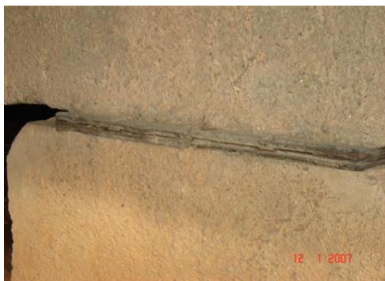
FOTO 4: Neoprene Deteriorado
