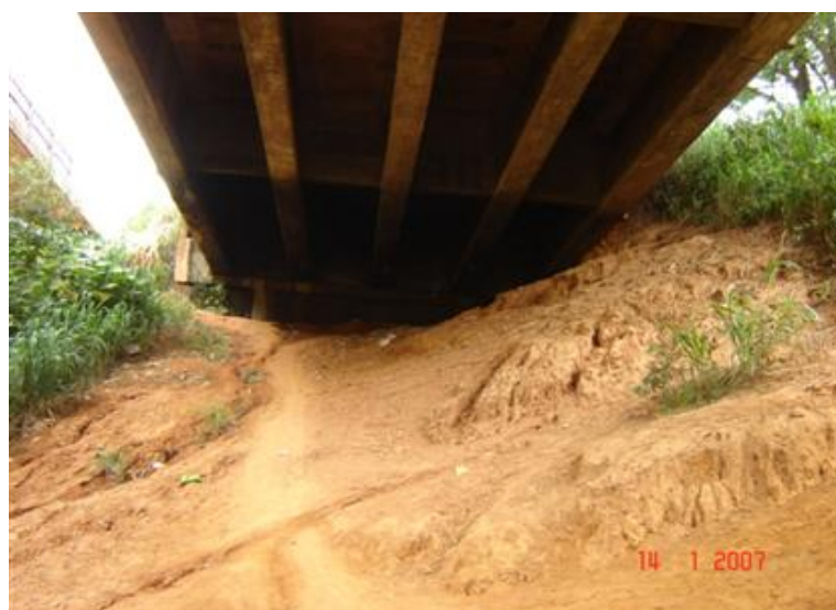
FOTO 4: Talude Desprotegido
