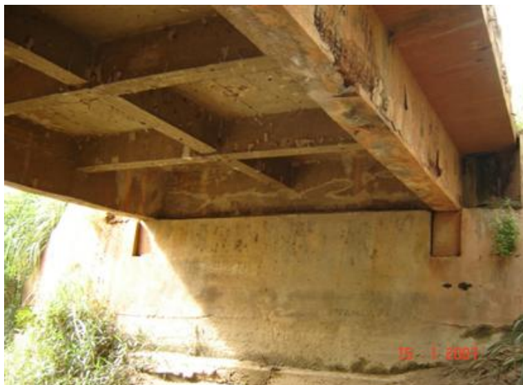
FOTO 3: Vista Inferior da Obra
