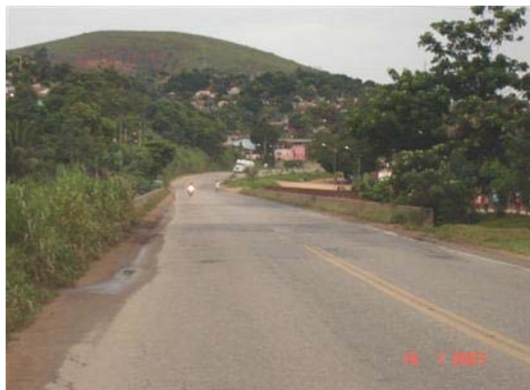
Vista Superior da Obra
