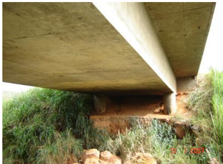
FOTO 3: Vista Inferior da Obra
