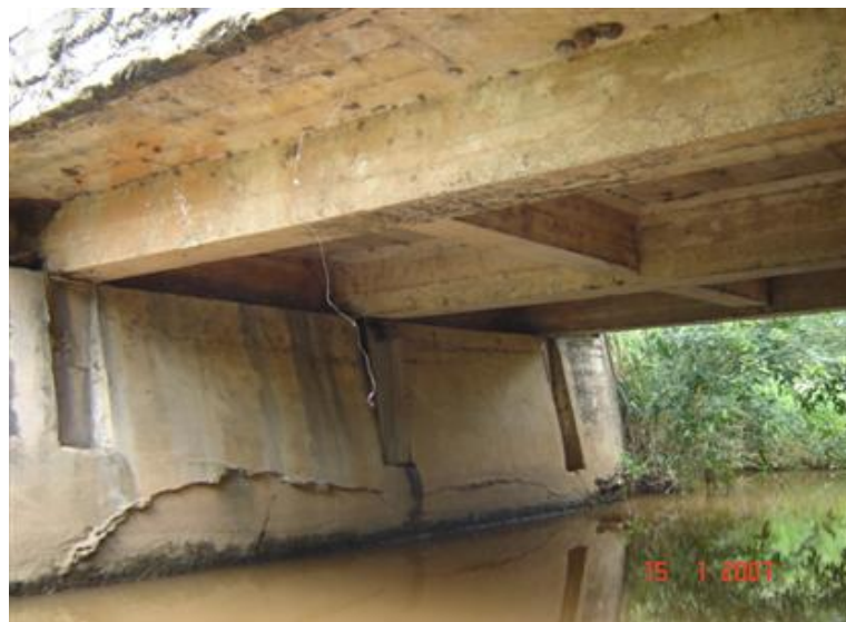
FOTO 3: Vista Inferior da Obra
