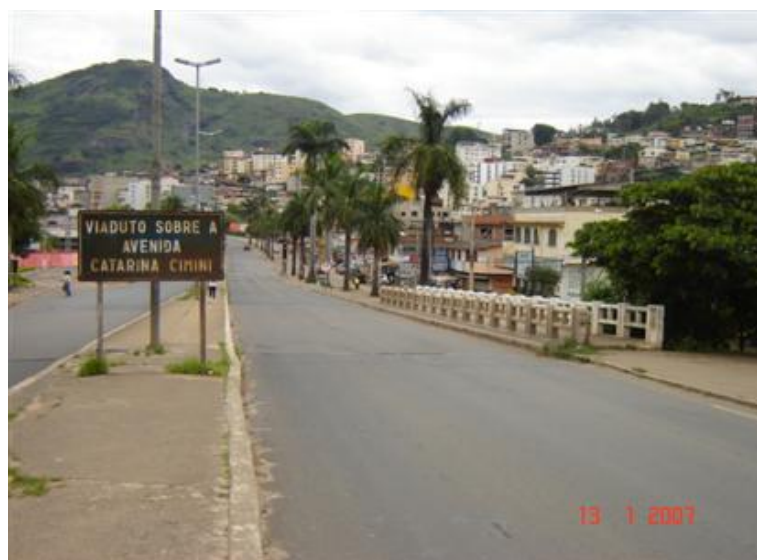
Vista Superior da Obra
