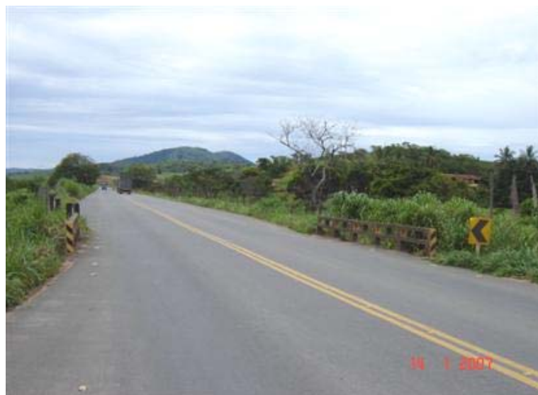
FOTO 1: Vista Superior da Obra
