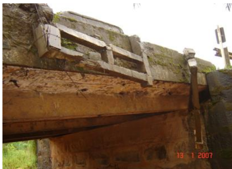
FOTO 4: Guarda-Corpo Faltante
