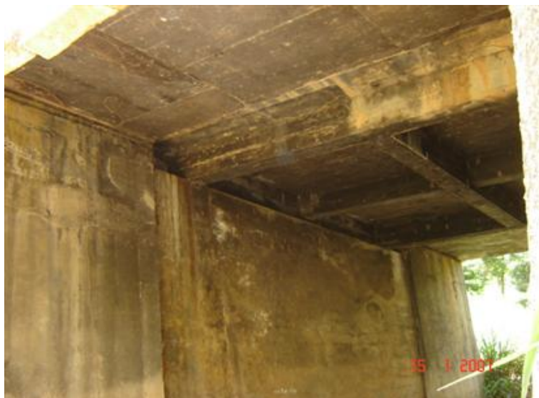
FOTO 3: Vista Inferior da Obra Alargamento Lateral em Laje
