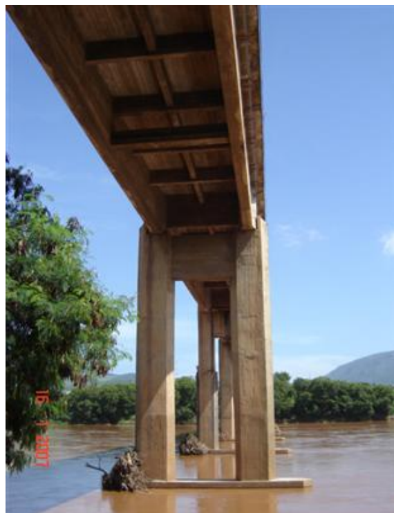
FOTO 3: Vista Inferior da Obra
