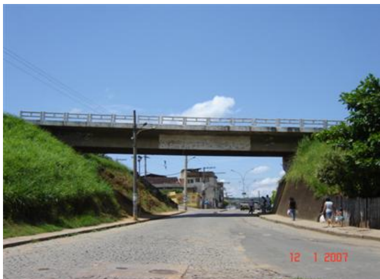
FOTO 2: Vista Lateral da Obra
