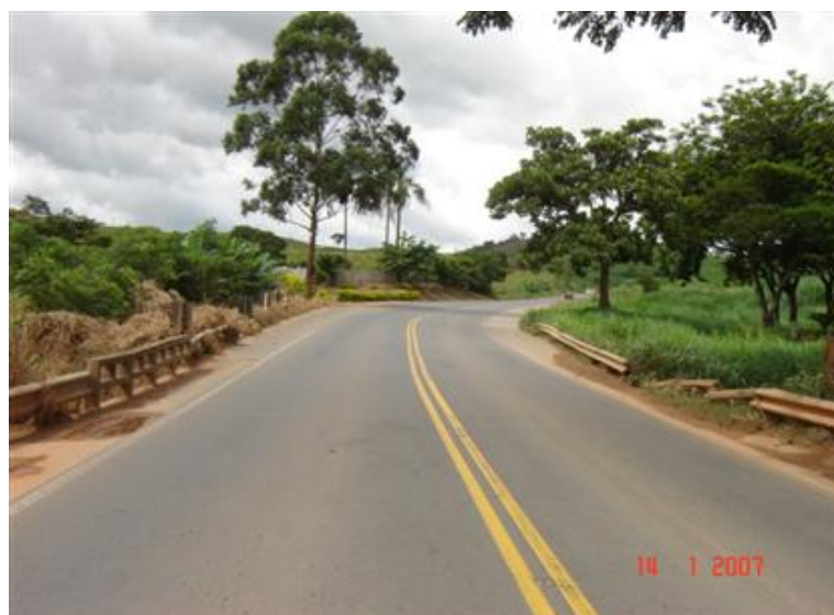
FOTO 1: Vista Superior da Obra
