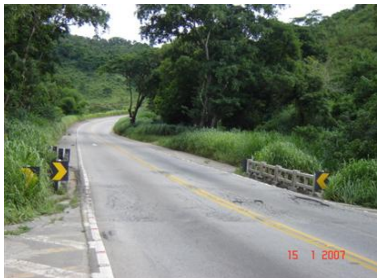
FOTO 1: Vista Superior da Obra
