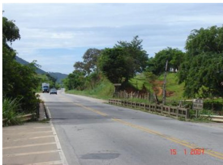
FOTO 1: Vista Superior da Obra
