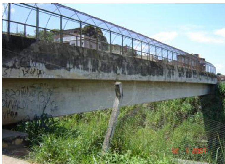
FOTO 4: Vista Lateral Inferior da Obra
