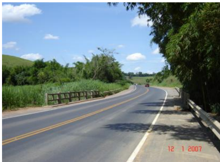
FOTO 1: Vista Superior da Obra
