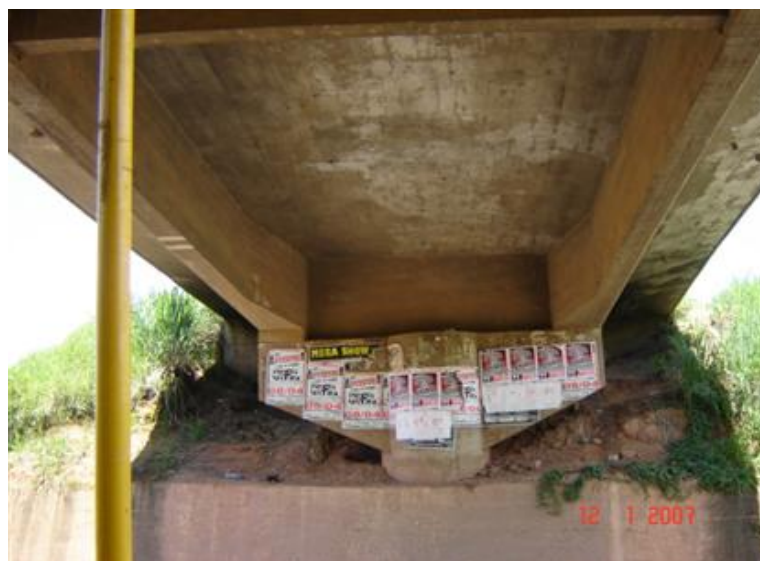
FOTO 3: Vista Inferior da Obra
