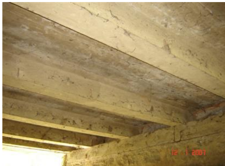
FOTO 3: Vista Inferior da Obra
