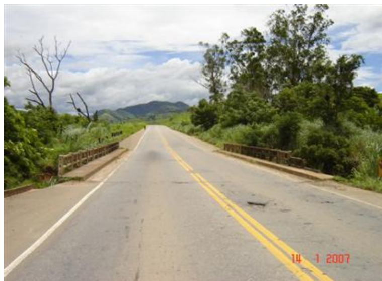
FOTO 1: Vista Superior da Obra
