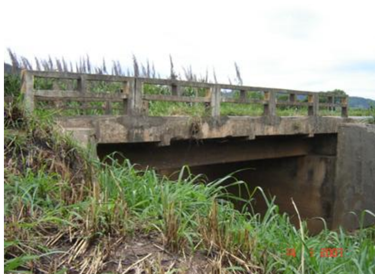
FOTO 2: Vista Lateral da Obra
