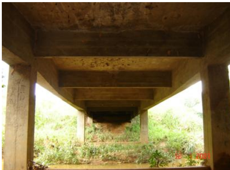
FOTO 3: Vista Inferior da Obra
