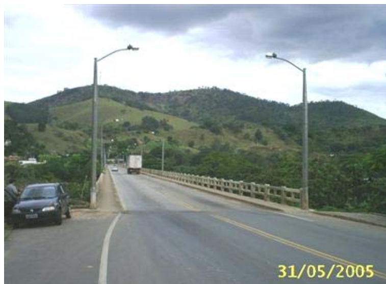
Vista Superior da Obra
