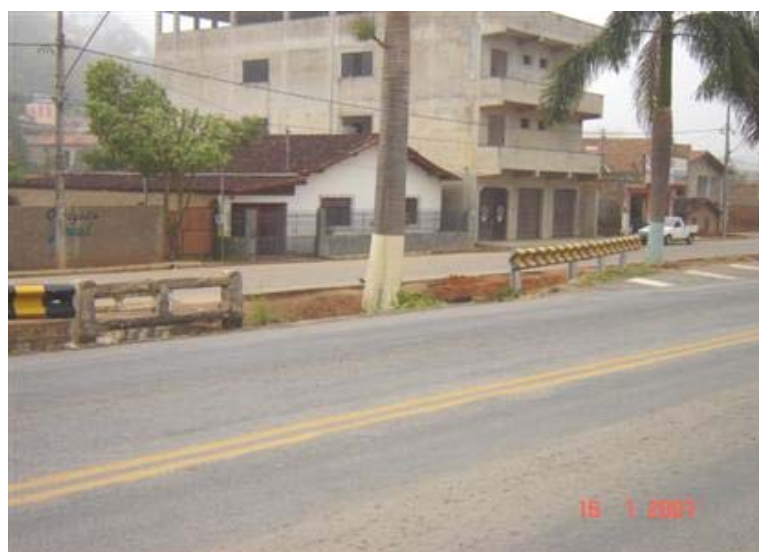
FOTO 4: Ausência de Guarda-Corpo
