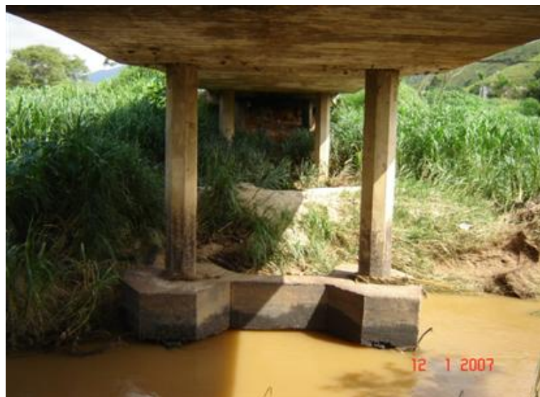
FOTO 3: Vista Inferior da Obra
