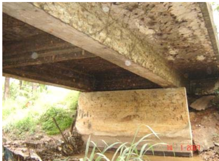
FOTO 3: Vista Inferior da Obra
