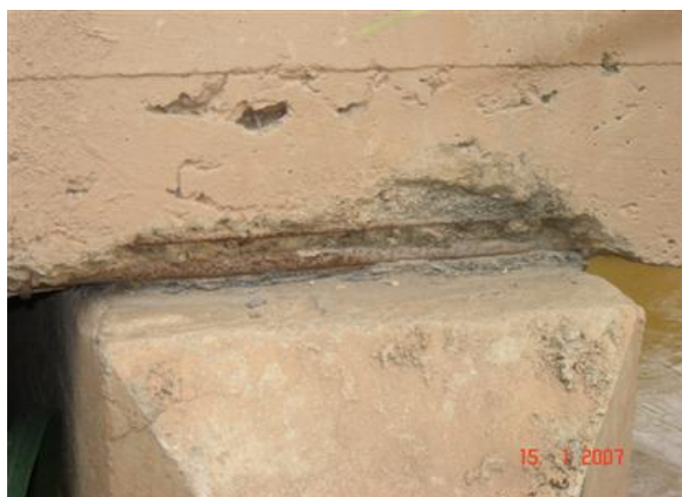
FOTO 4: Detalhe do Aparelho de Apoio
