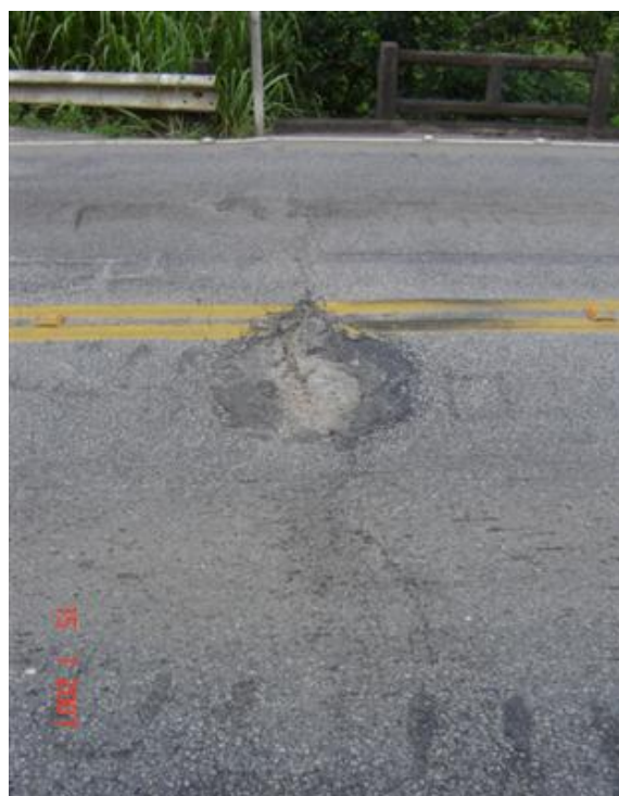
FOTO 4: Pavimento Desgastado
