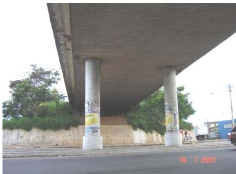
FOTO 3: Vista Inferior da Obra
