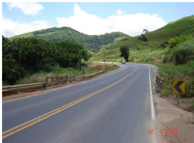
FOTO 1: Vista Superior da Obra
