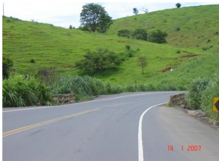
FOTO 1: Vista Superior da Obra
