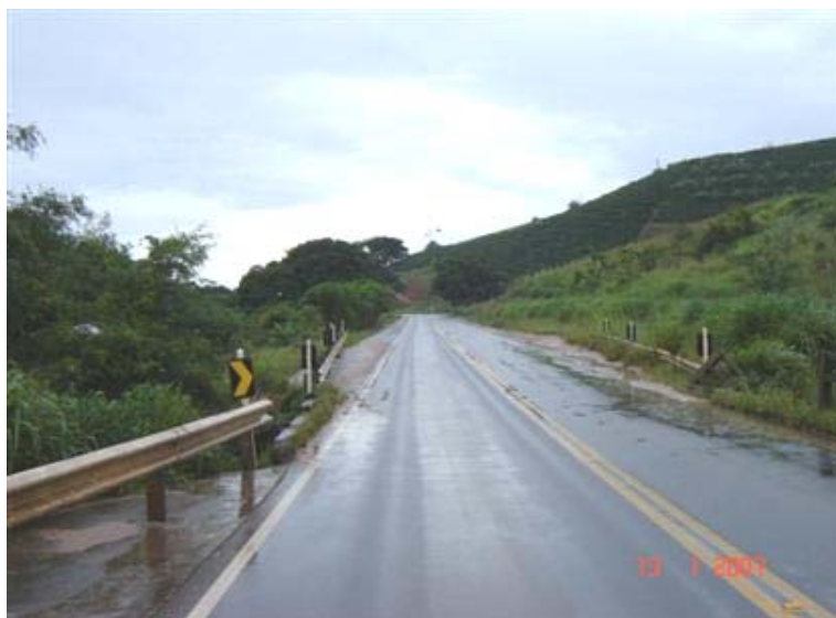
FOTO 1: Vista Superior da Obra
