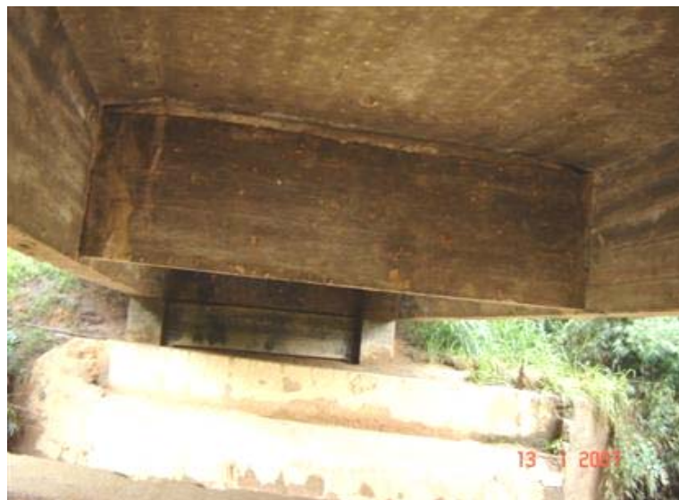
FOTO 3: Vista Inferior da Obra
