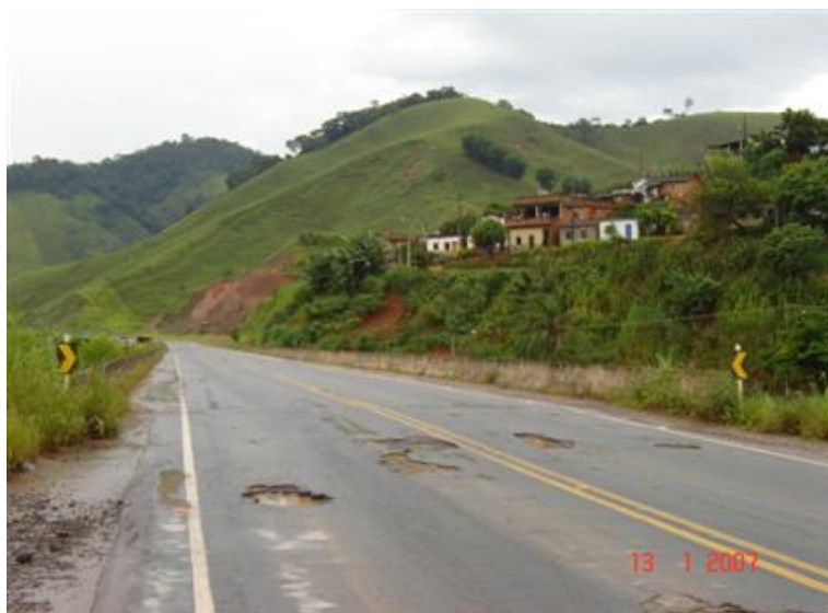
FOTO 1: Vista Superior da Obra
