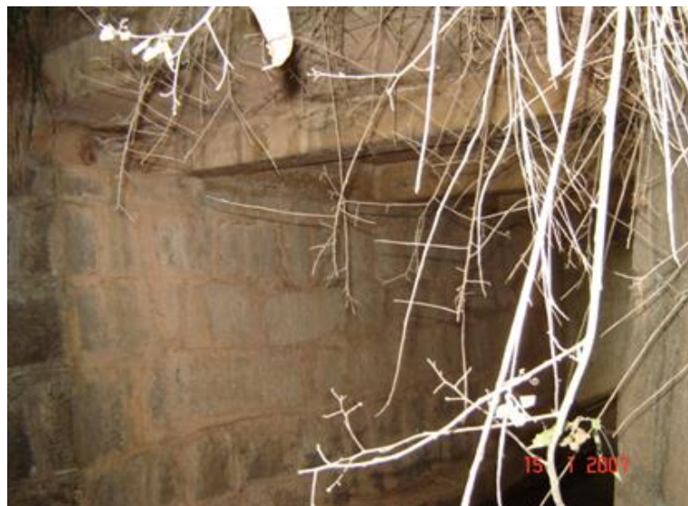
FOTO 3: Vista Inferior da Obra
