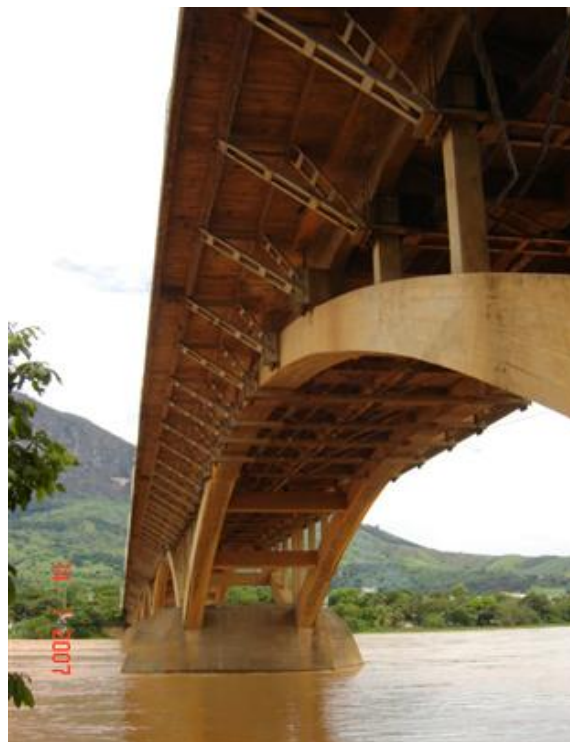
FOTO 3: Vista Inferior da Obra
