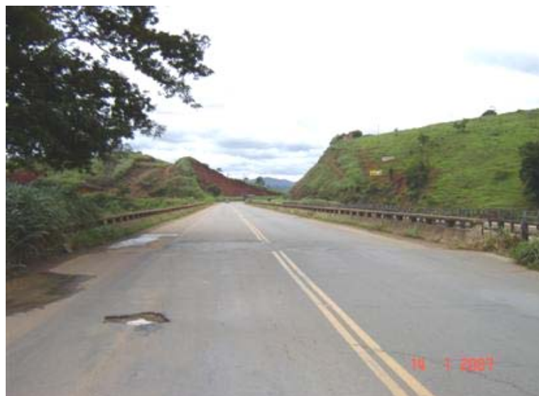
FOTO 1: Vista Superior da Obra
