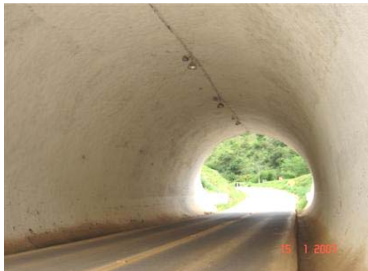
FOTO 3: Vista Interior da Obra
