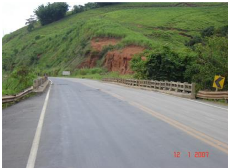
Vista Superior da Obra
