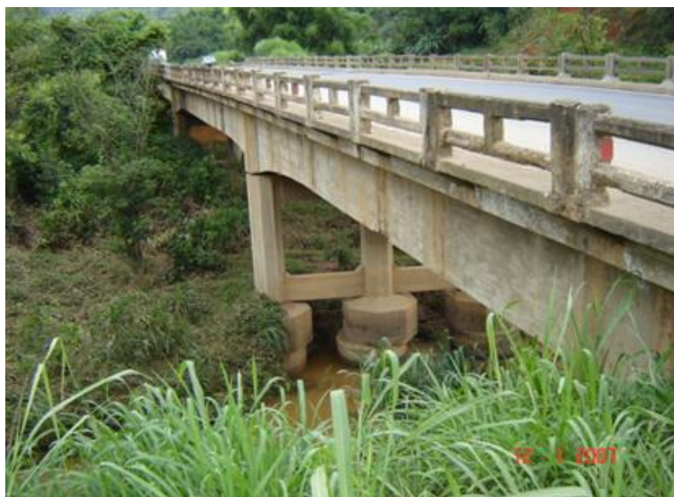
Vista Lateral da Obra
