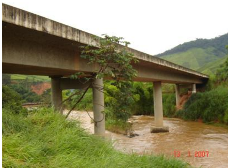
FOTO 2: Vista Lateral da Obra
