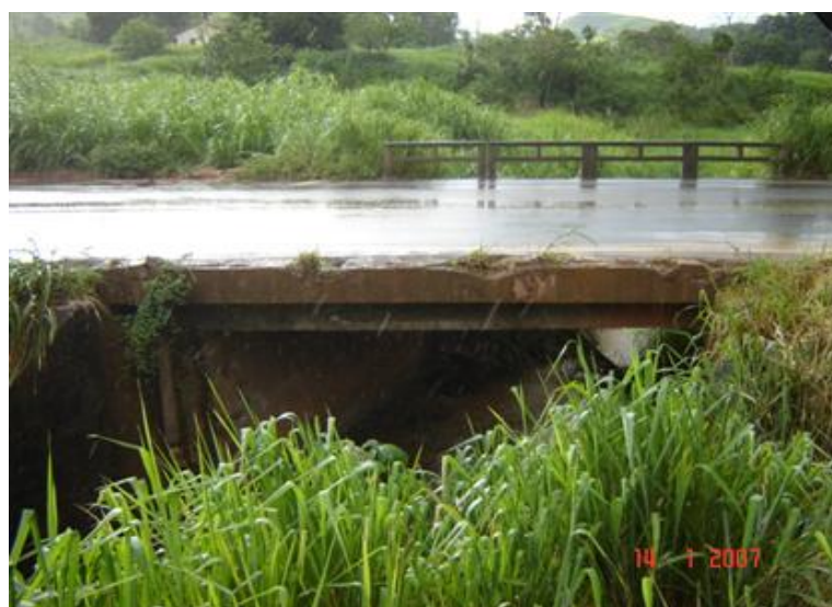
FOTO 4: Guarda-Corpo Faltante
