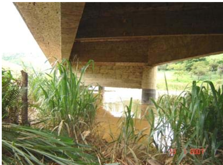
FOTO 3: Vista Inferior da Obra
