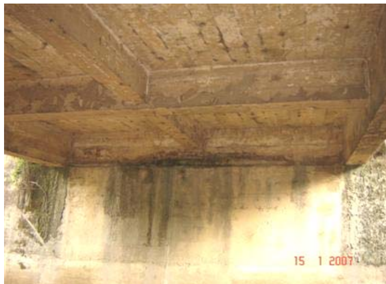
FOTO 3: Vista Inferior da Obra
