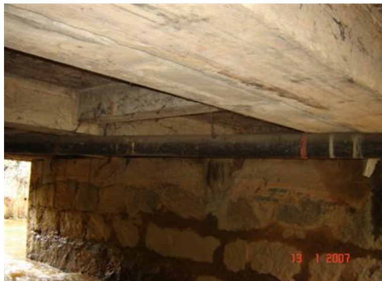
FOTO 3: Vista Inferior da Obra
