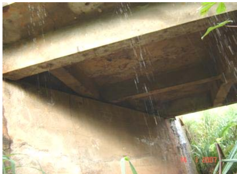
FOTO 3: Vista Inferior da Obra
