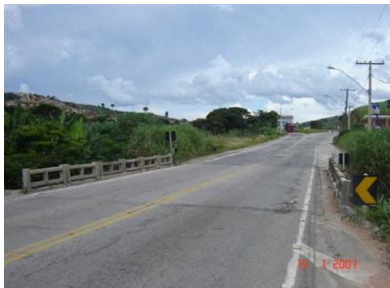
FOTO 1: Vista Superior da Obra
