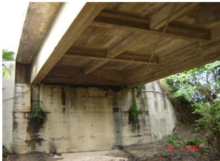
FOTO 3: Vista Inferior da Obra
