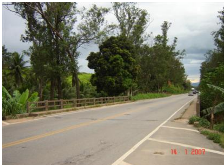
FOTO 1: Vista Superior da Obra
