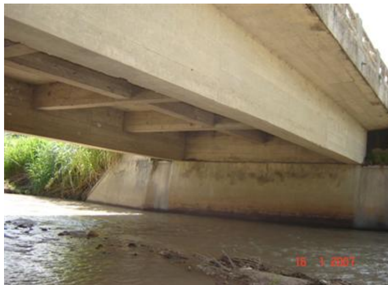
FOTO 3: Vista Inferior da Obra
