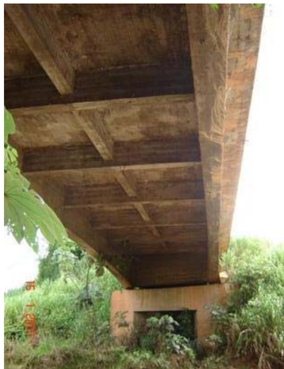
FOTO 3: Vista Inferior da Obra
