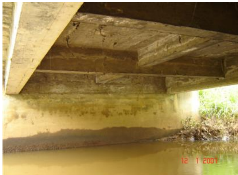
FOTO 3: Vista Inferior da Obra
