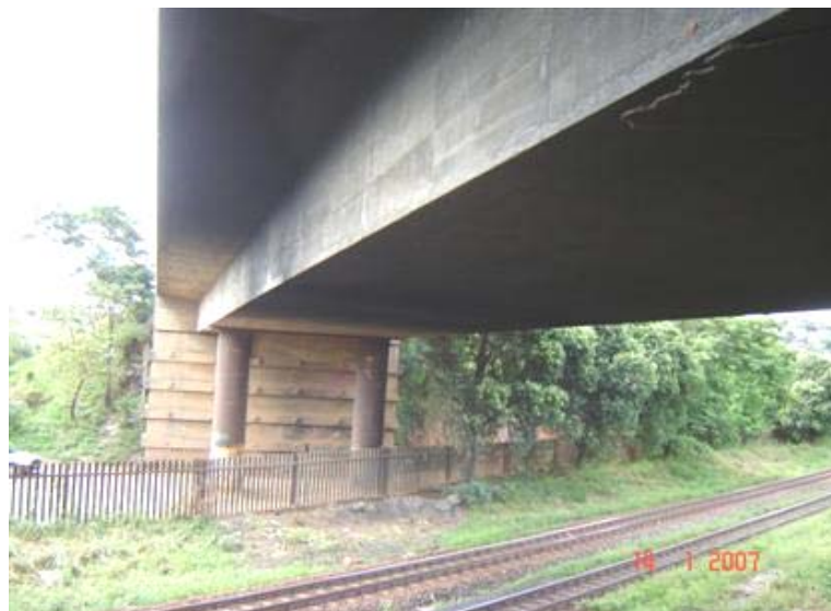
FOTO 3: Vista Inferior da Obra
