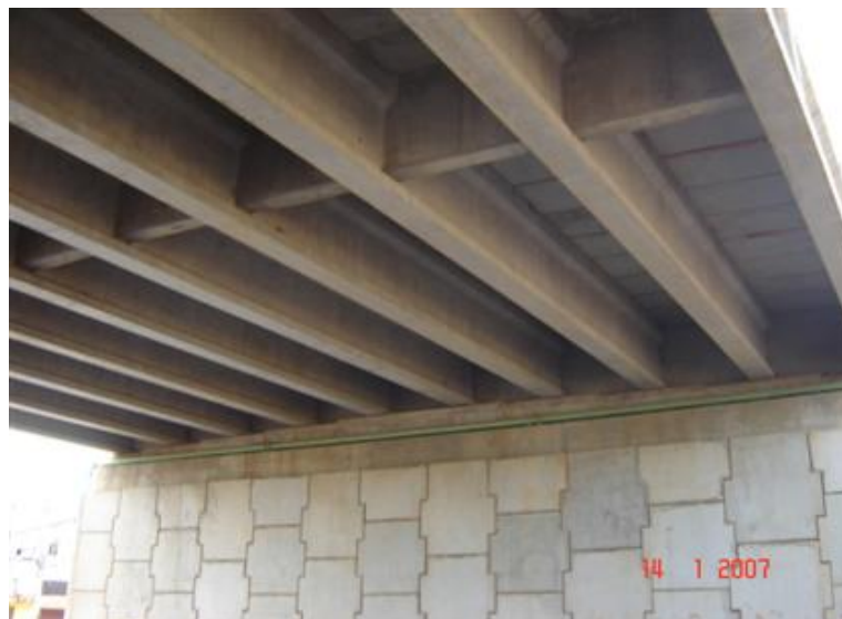
FOTO 3: Vista Inferior da Obra
