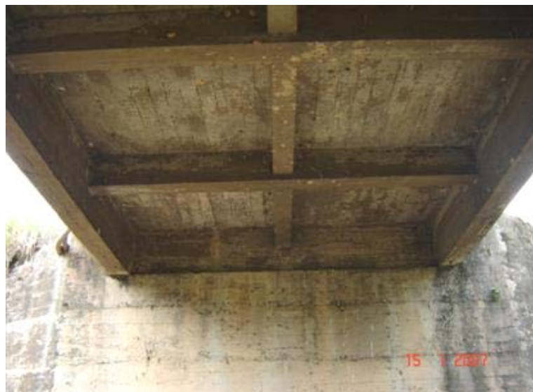
FOTO 3: Vista Inferior da Obra
