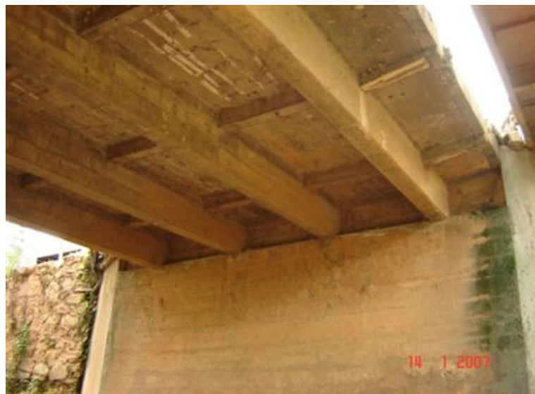
FOTO 3: Vista Inferior da Obra
