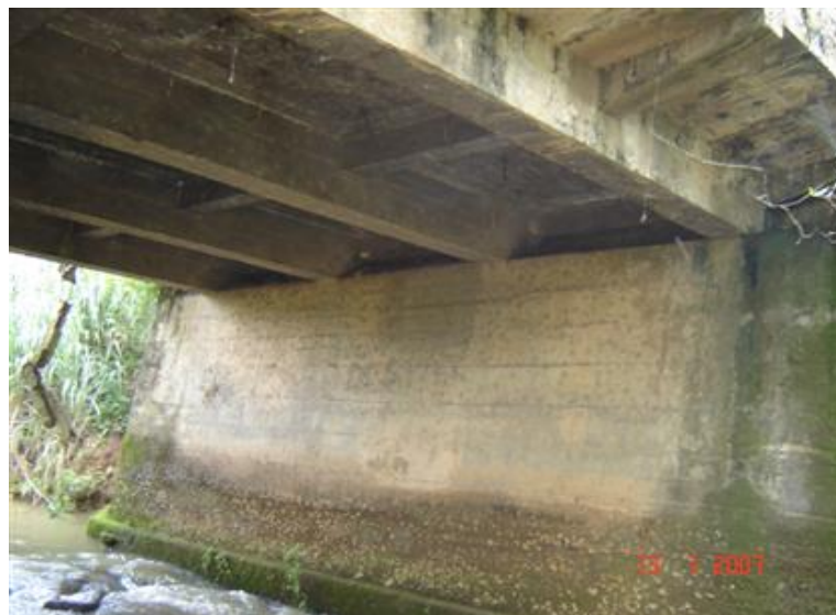
FOTO 3: Vista Inferior da Obra
