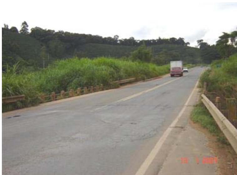
FOTO 1: Vista Superior da Obra
