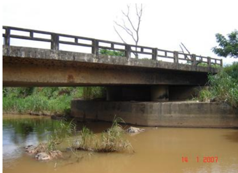
FOTO 4: Proteção dos Pilares
