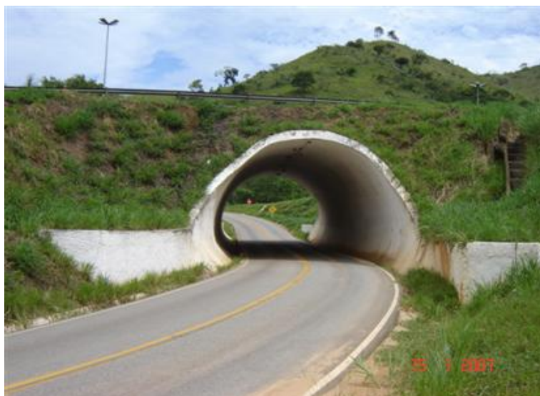
FOTO 2: Vista Lateral da Obra
