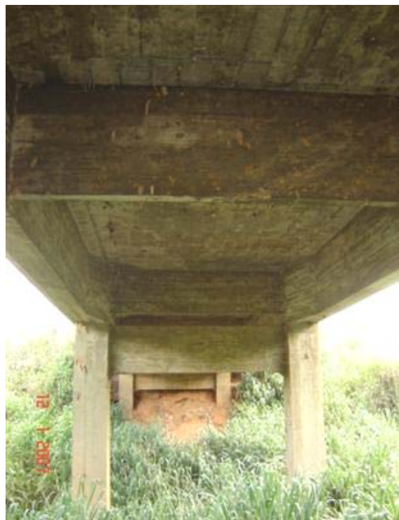
FOTO 3: Vista Inferior da Obra
