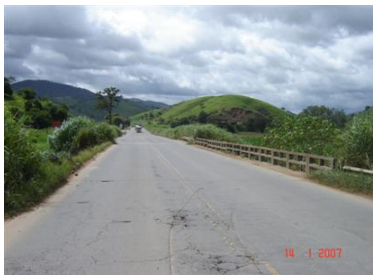
FOTO 1: Vista Superior da Obra
