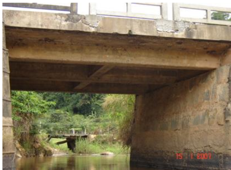
FOTO 3: Vista Inferior da Obra
