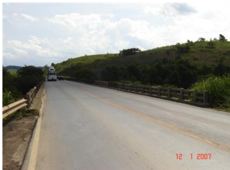
FOTO 1: Vista Superior da Obra
