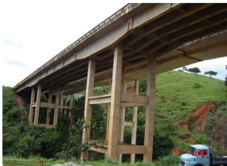
FOTO 2: Vista Lateral Inferior da Obra
