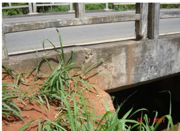
FOTO 4: Rompimento da Mureta
