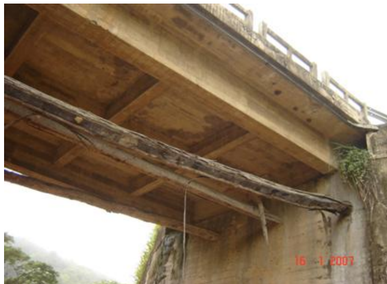
FOTO 3: Vista Inferior da Obra
