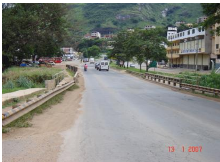
FOTO 1: Vista Superior da Obra
