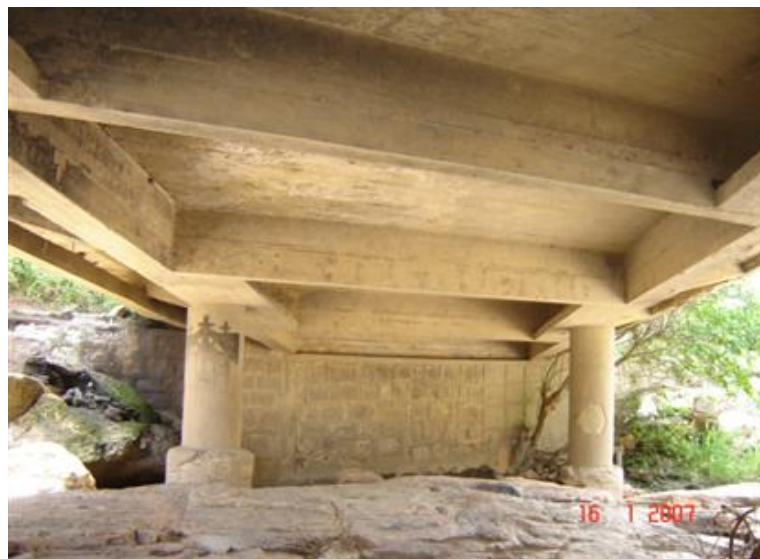
FOTO 3: Vista Inferior da Obra
