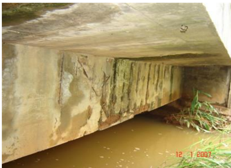
FOTO 4: Vista Lateral Inferior da Obra
