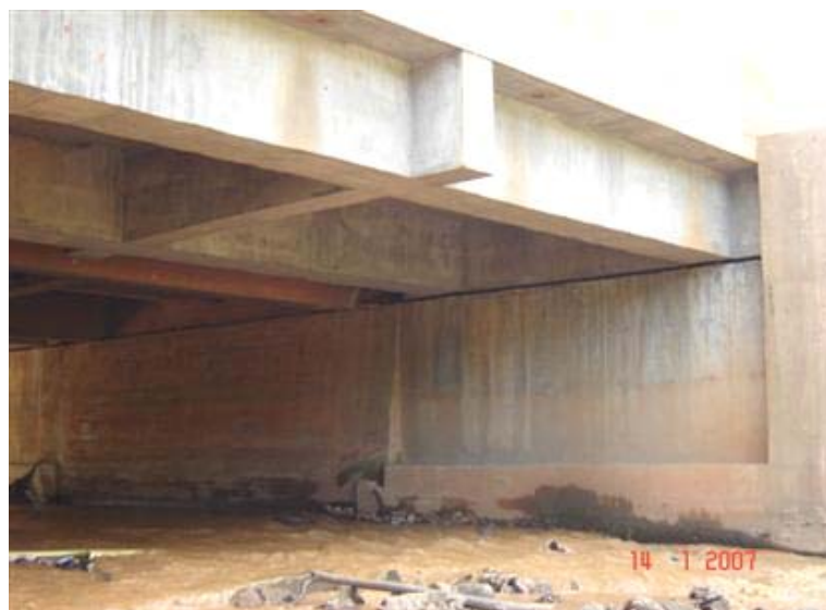
FOTO 3: Vista Inferior da Obra
