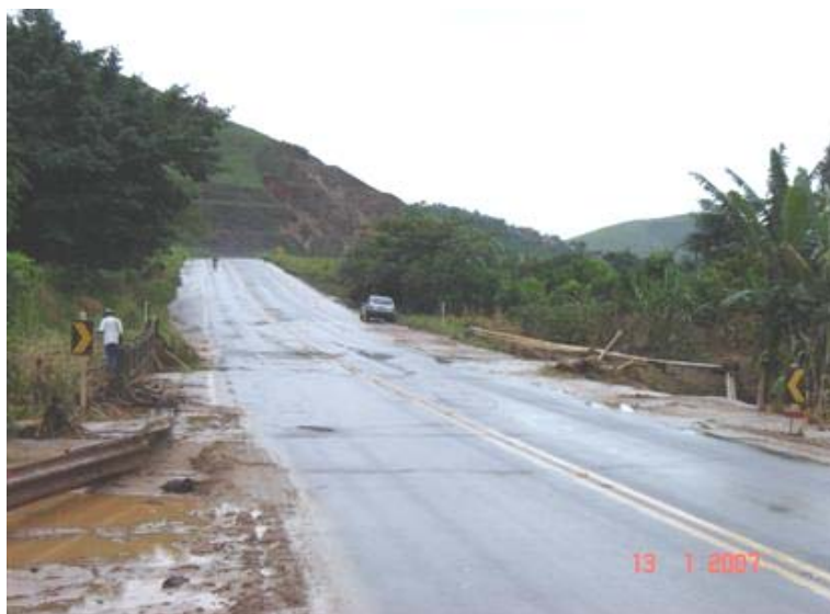
FOTO 1: Vista Superior da Obra
