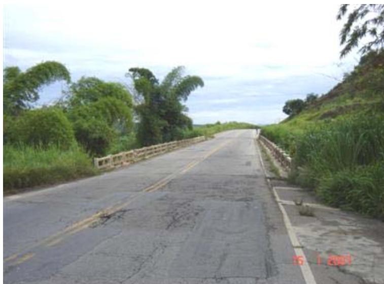
FOTO 1: Vista Superior da Obra
