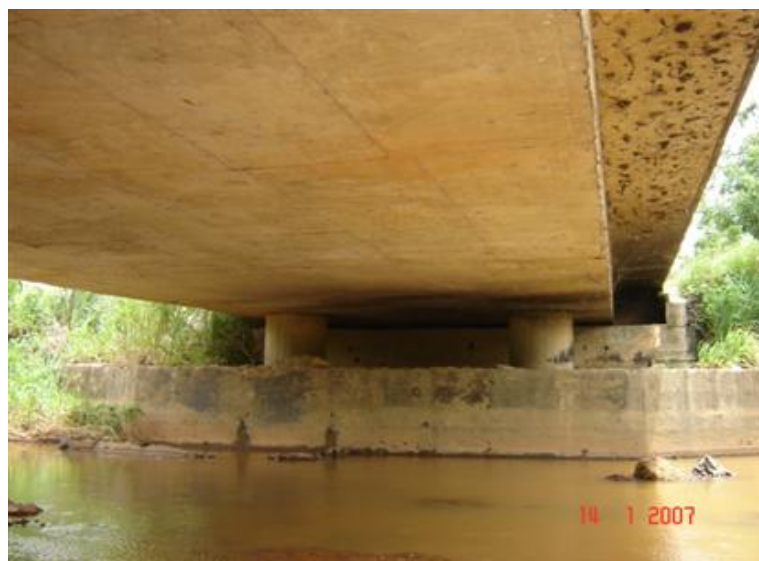
FOTO 3: Vista Inferior da Obra
