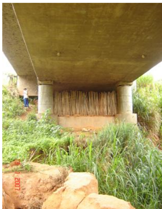
FOTO 4: Detalhe do talude sob a obra
