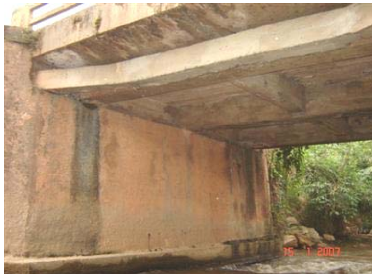
FOTO 3: Vista Inferior da Obra
