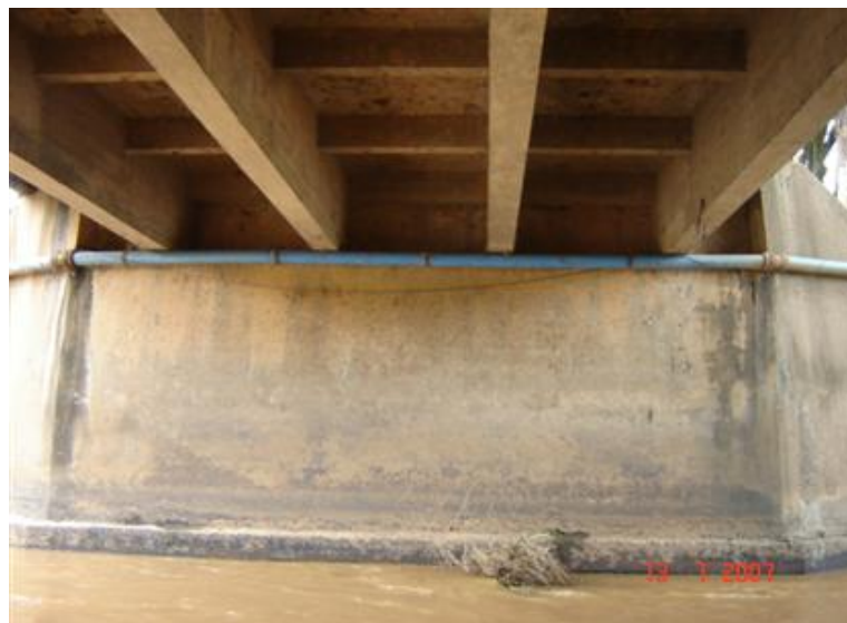
FOTO 3: Vista Inferior da Obra
