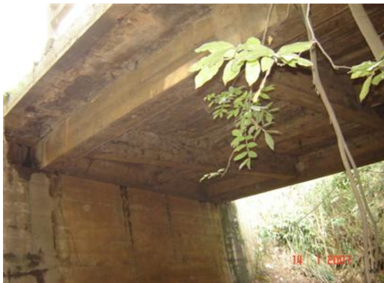
FOTO 3: Vista Inferior da Obra
