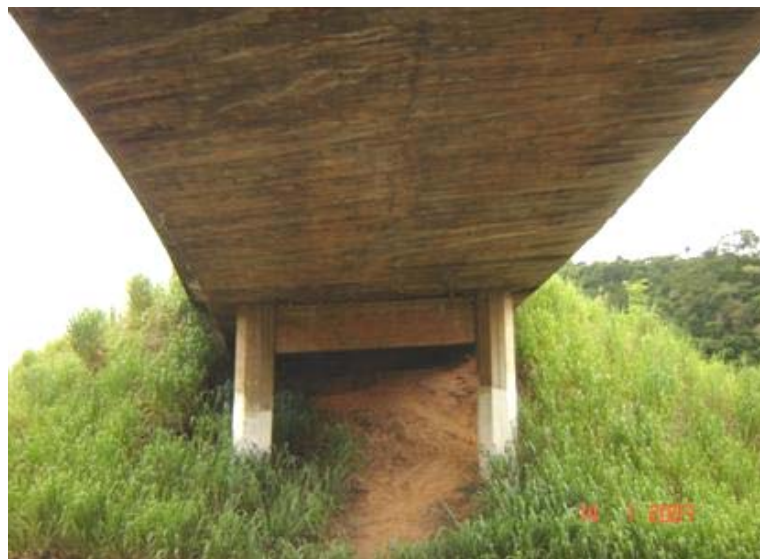
FOTO 3: Vista Inferior da Obra
