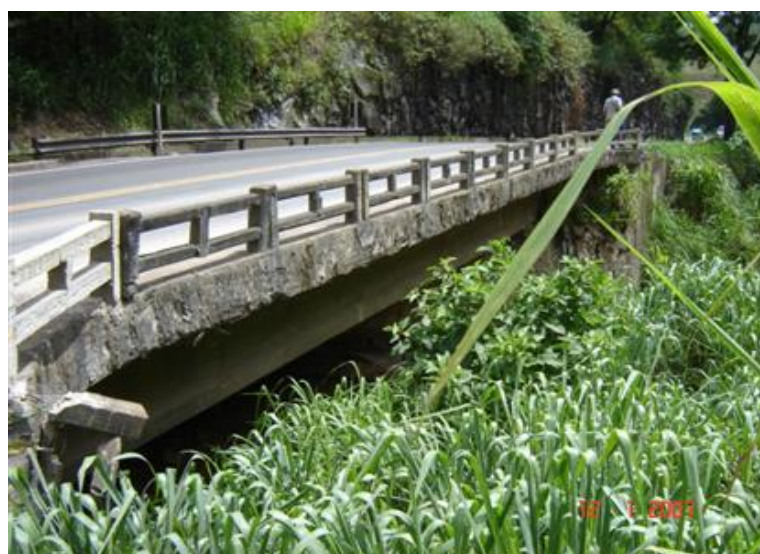
FOTO 4: Vista Lateral Superior da Obra
