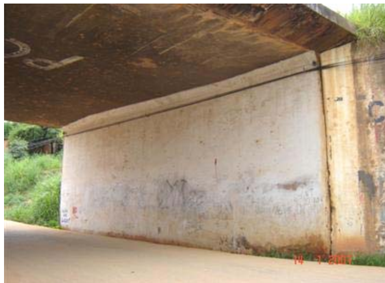
FOTO 3: Vista Inferior da Obra
