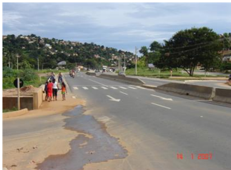
FOTO 1: Vista Superior da Obra
