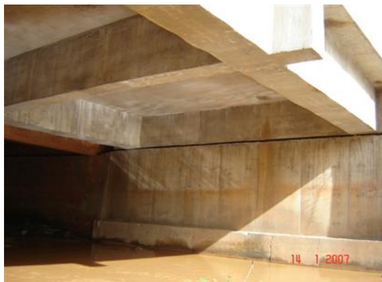
FOTO 3: Vista Inferior da Obra
