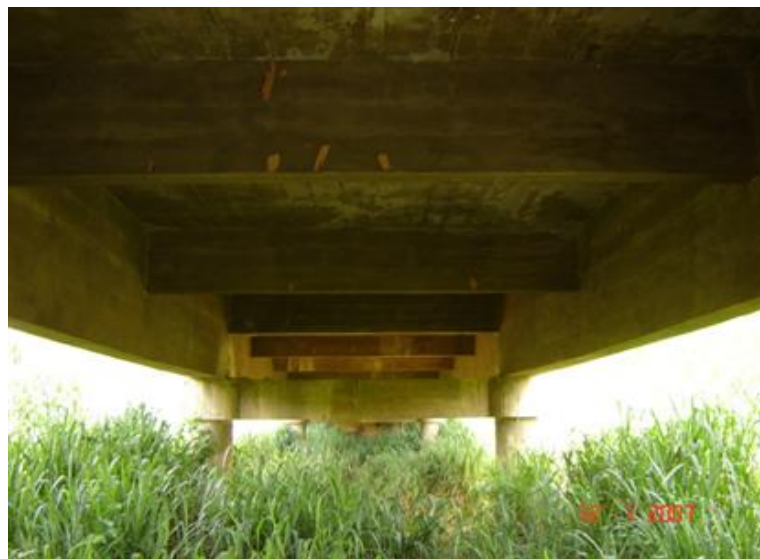
FOTO 3: Vista Inferior da Obra
