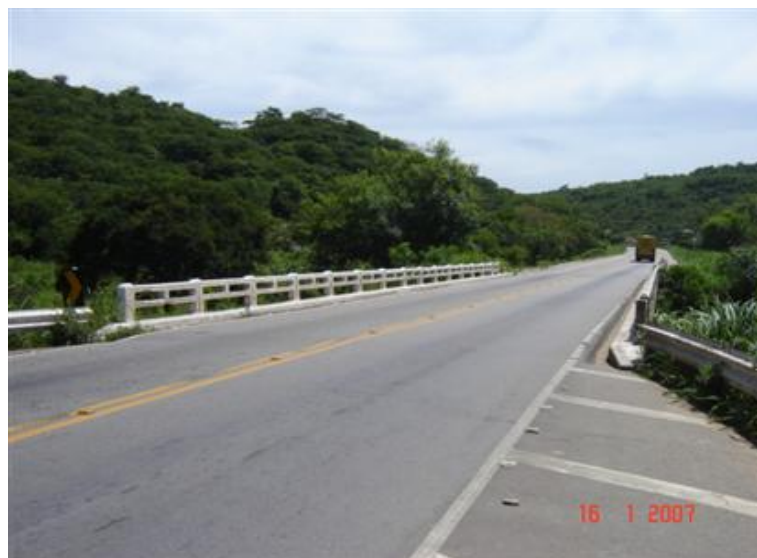
FOTO 1: Vista Superior da Obra
