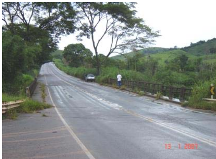
FOTO 1: Vista Superior da Obra
