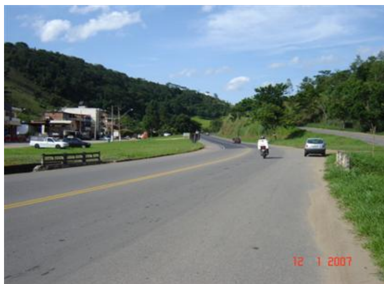
FOTO 1: Vista Superior da Obra
