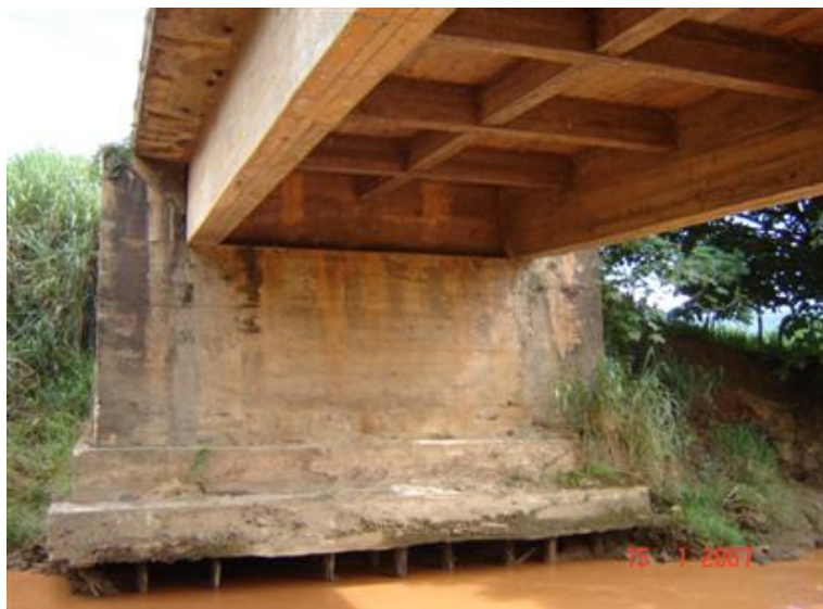
FOTO 3: Vista Inferior da Obra
