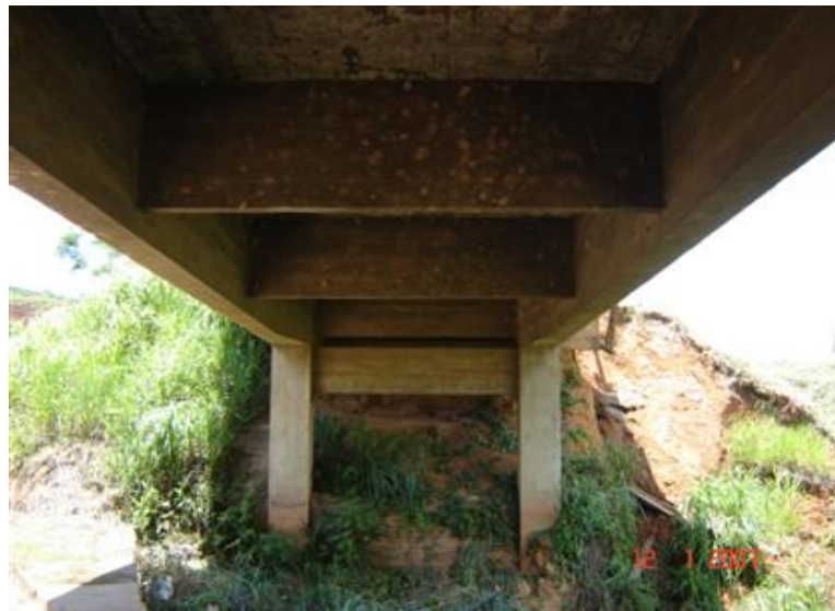
FOTO 3: Vista Inferior da Obra
