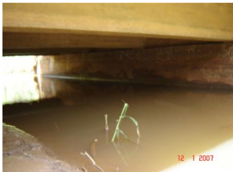
FOTO 3: Vista Inferior da Obra
