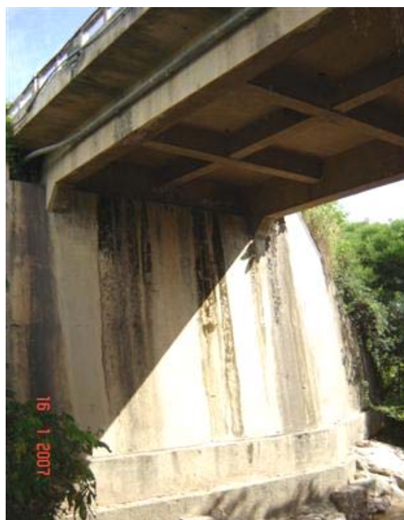
FOTO 4: Vista da Parede de Encontro
