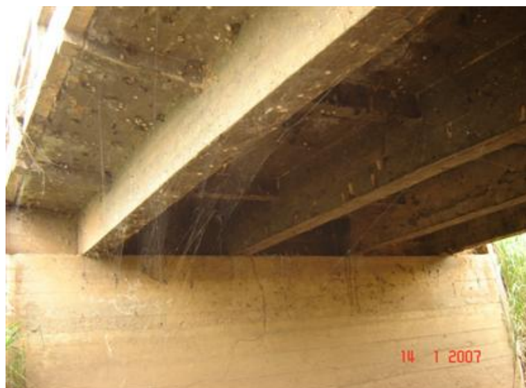
FOTO 3: Vista Inferior da Obra
