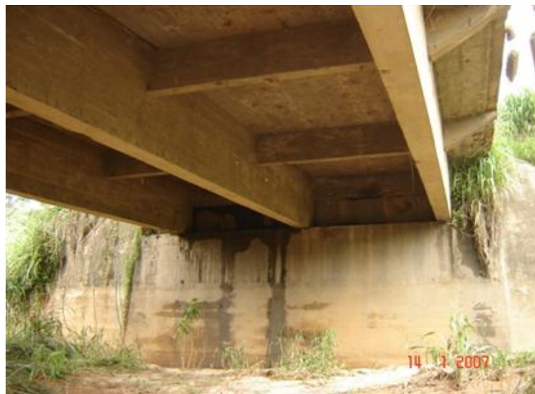
FOTO 3: Vista Inferior da Obra
