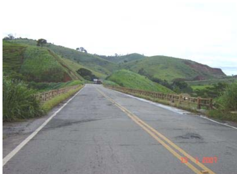
FOTO 1: Vista Superior da Obra
