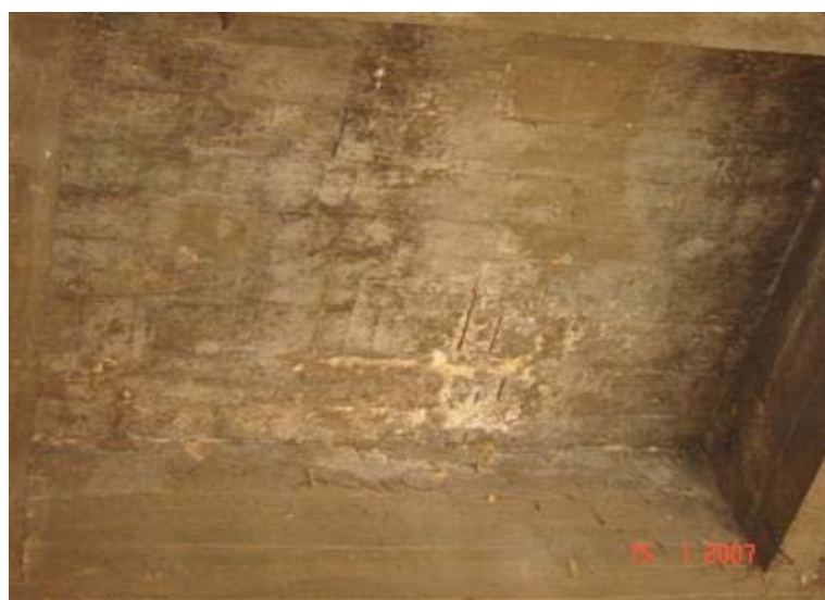
FOTO 4: Laje c/ C.D. + A.E.O.
