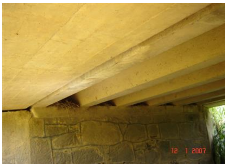
FOTO 4: Ampliação lateral em caixão
