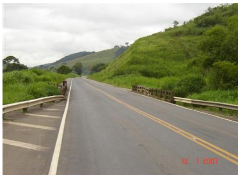
FOTO 1: Vista Superior da Obra
