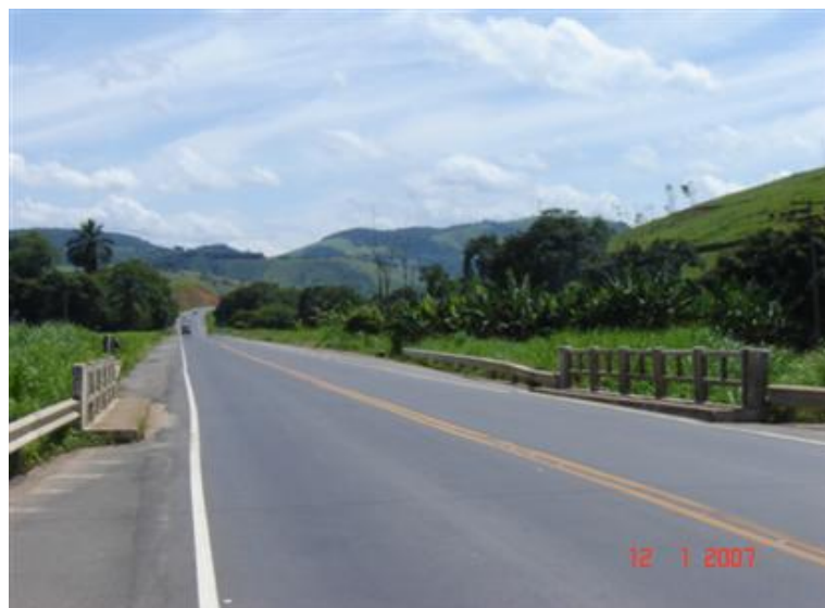
Vista Superior da Obra
