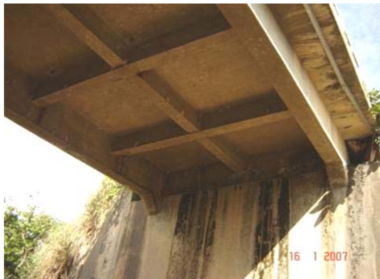
FOTO 3: Vista Inferior da Obra
