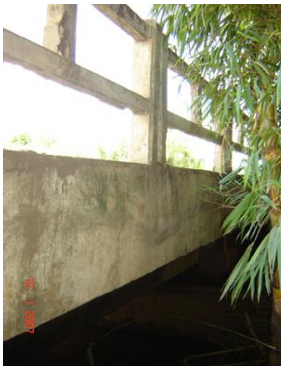
FOTO 3: Vista Lateral da Obra
