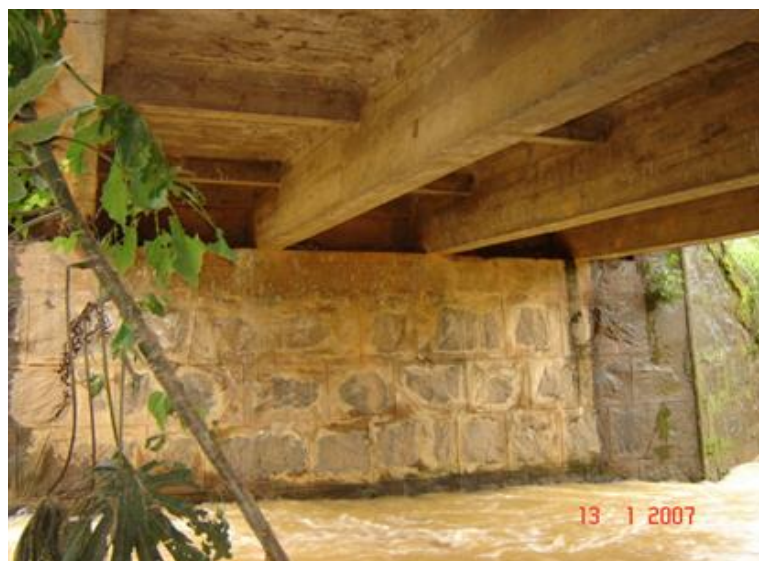
FOTO 3: Vista Inferior da Obra
