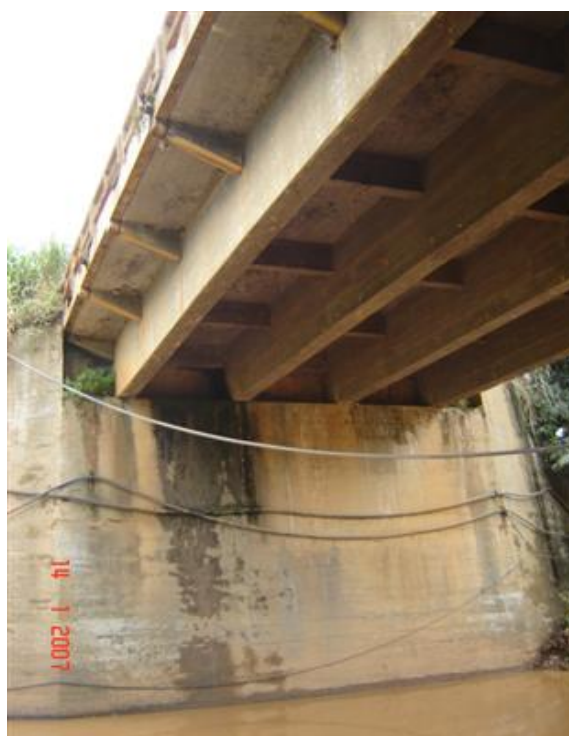
FOTO 4: Detalhe do Muro de Encontro
