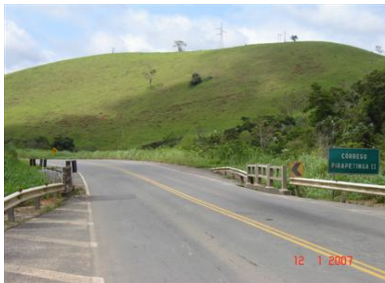
FOTO 1: Vista Superior da Obra
