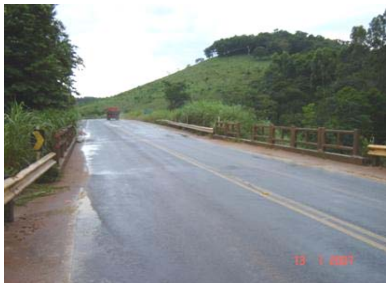
FOTO 1: Vista Superior da Obra
