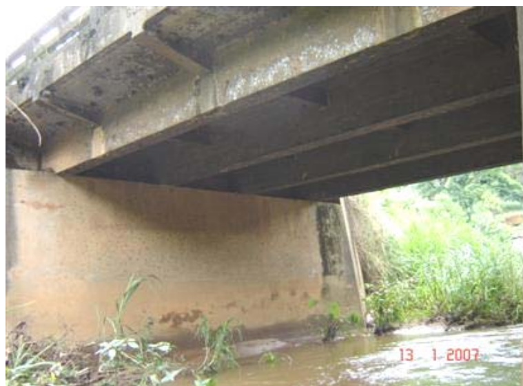
FOTO 3: Vista Inferior da Obra
