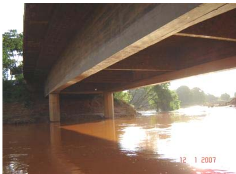
FOTO 3: Vista Inferior da Obra
