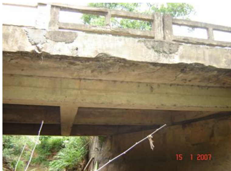
FOTO 3: Vista Inferior da Obra
