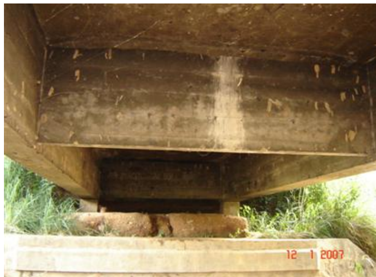
FOTO 3: Vista Inferior da Obra
