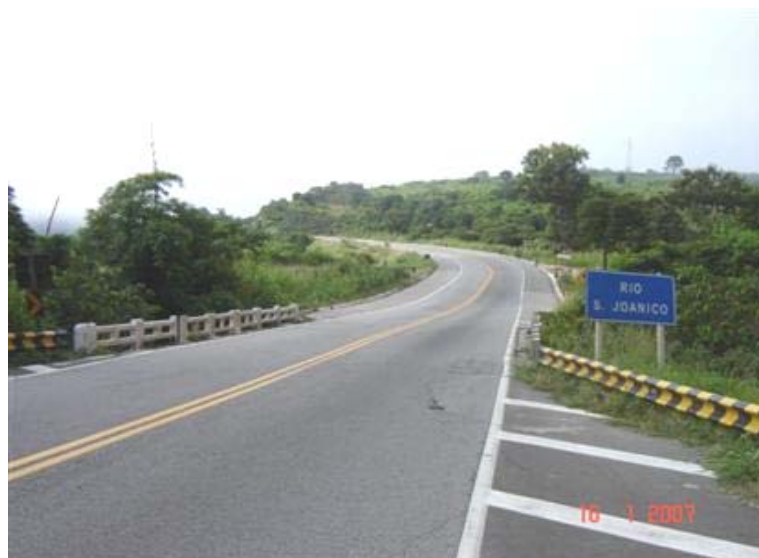
FOTO 1: Vista Superior da Obra
