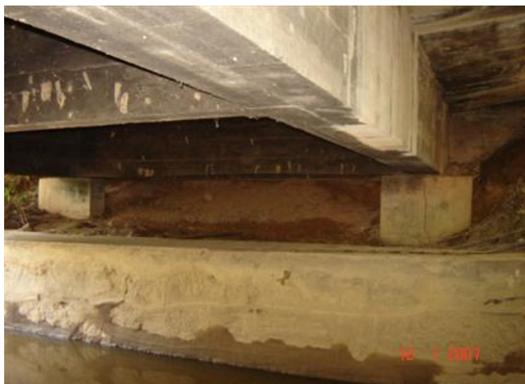
FOTO 2: Vista Inferior da Obra
