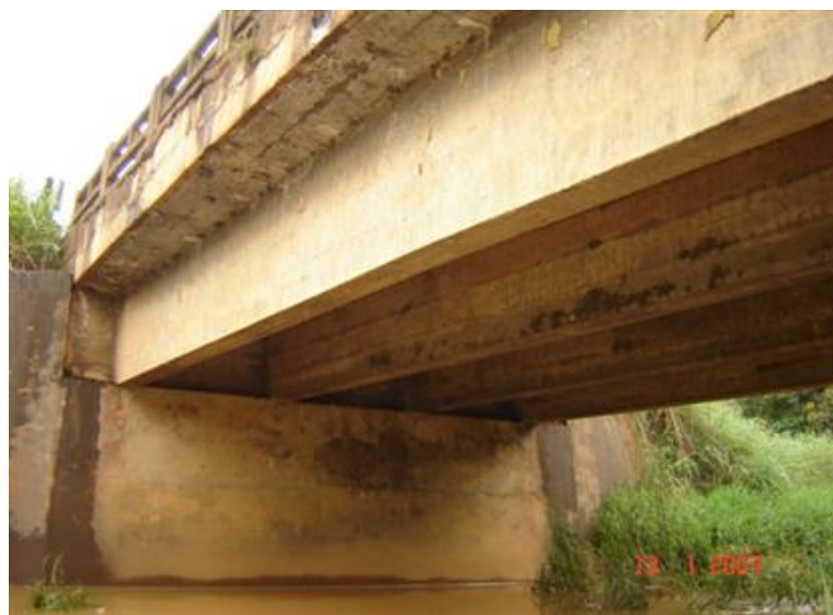
FOTO 3: Vista Inferior da Obra
