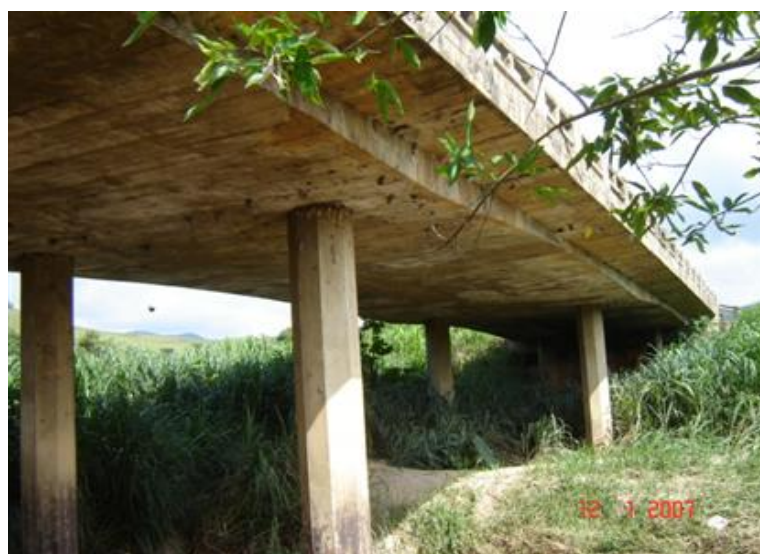
FOTO 4: Vista Lateral Inferior da Obra
