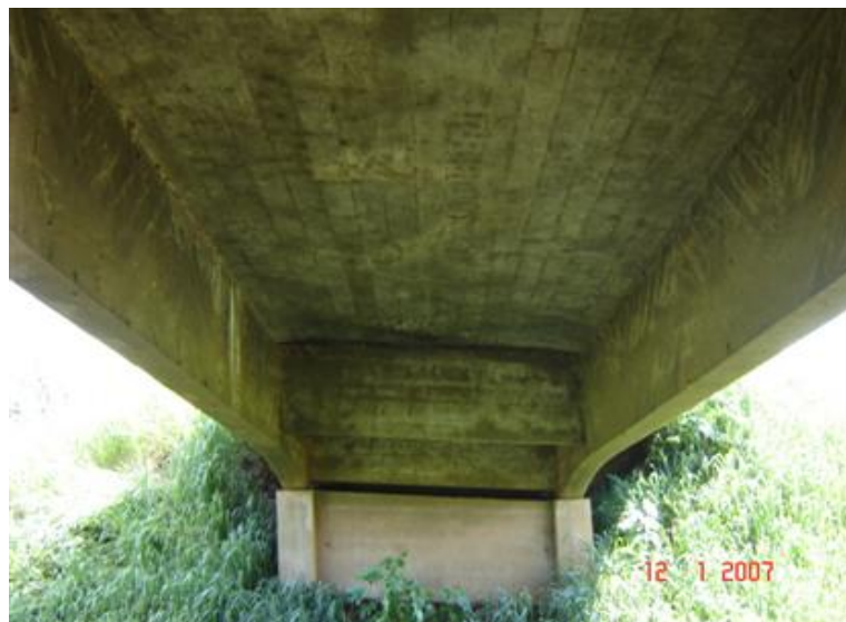
FOTO 3: Vista Inferior da Obra
