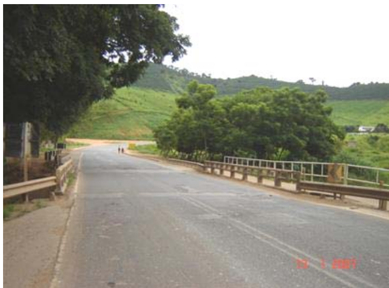
FOTO 1: Vista Superior da Obra
