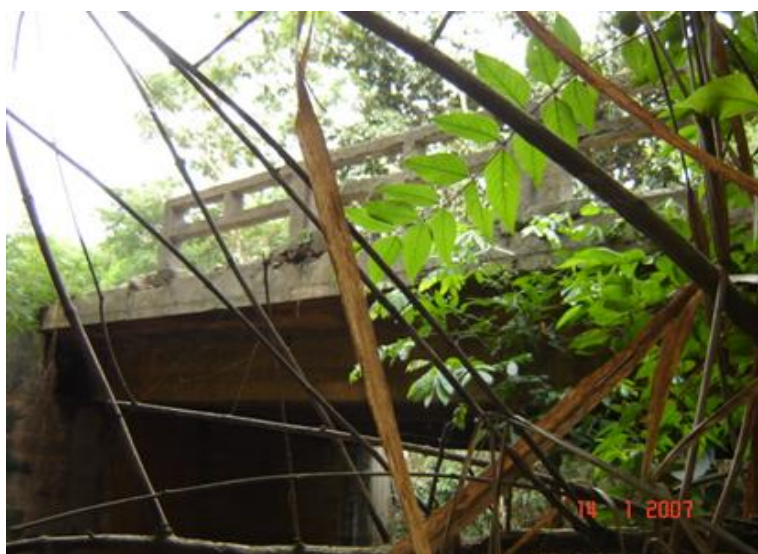
FOTO 4: Guarda-Corpo Faltante
