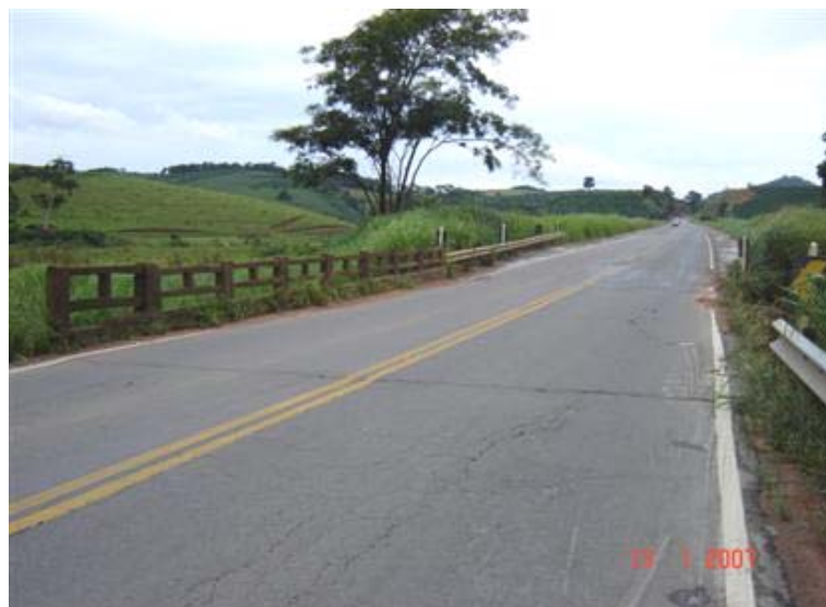
FOTO 1: Vista Superior da Obra
