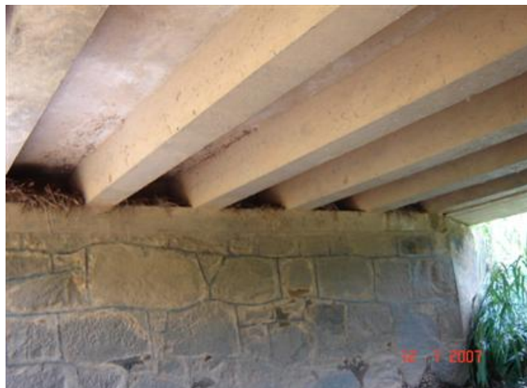
FOTO 3: Vista Inferior da Obra
