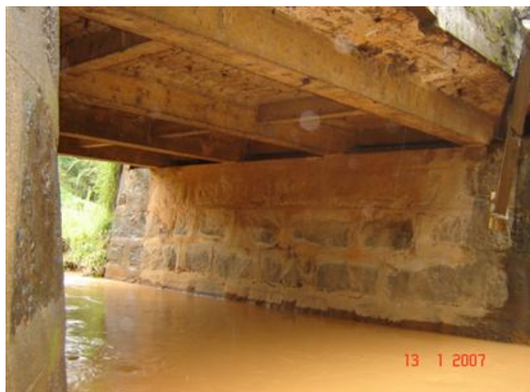
FOTO 3: Vista Inferior da Obra
