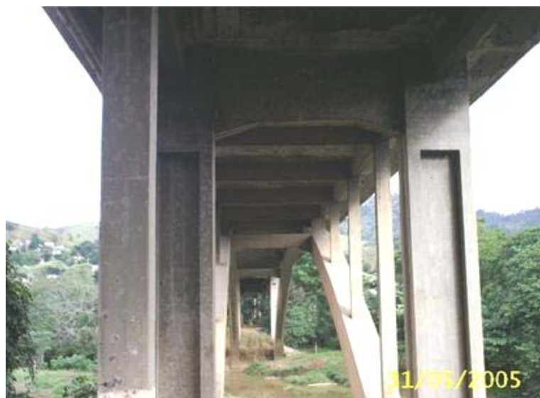
FOTO 3: Vista Inferior da Obra
