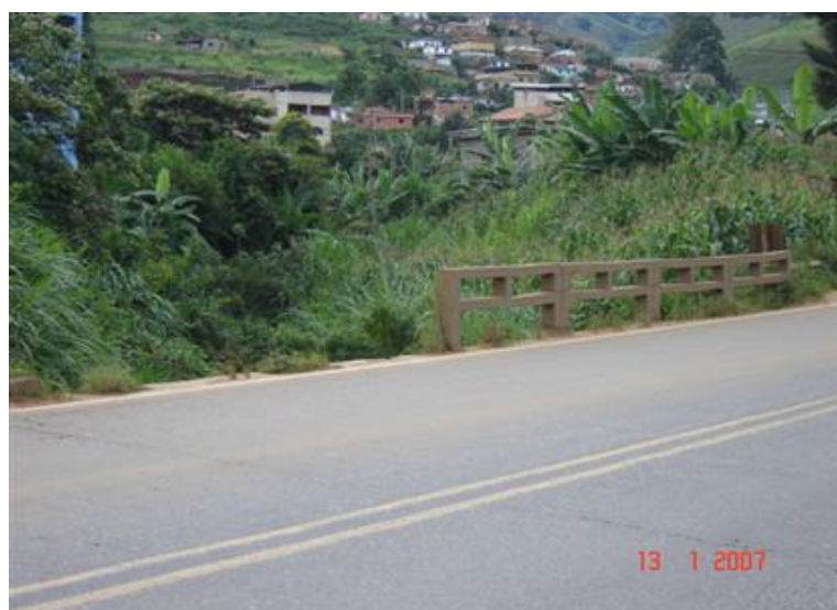
FOTO 4: Guarda-Corpo Faltante
