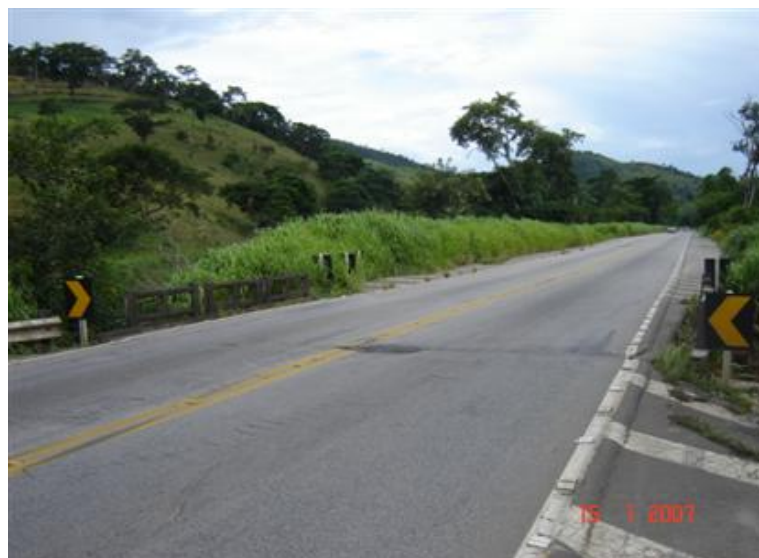
FOTO 1: Vista Superior da Obra
