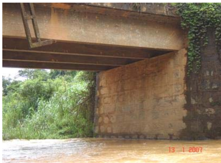
FOTO 3: Vista Inferior da Obra
