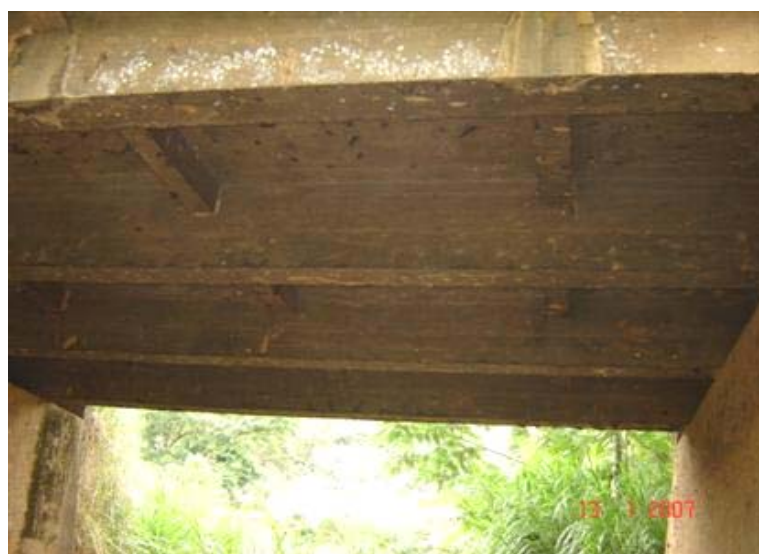
FOTO 4: Detalhe do Tabuleiro
