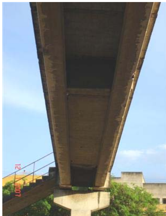
FOTO 3: Vista Inferior da Obra
