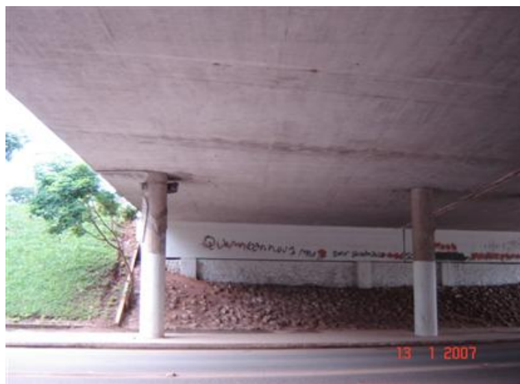
FOTO 3: Vista Inferior da Obra
