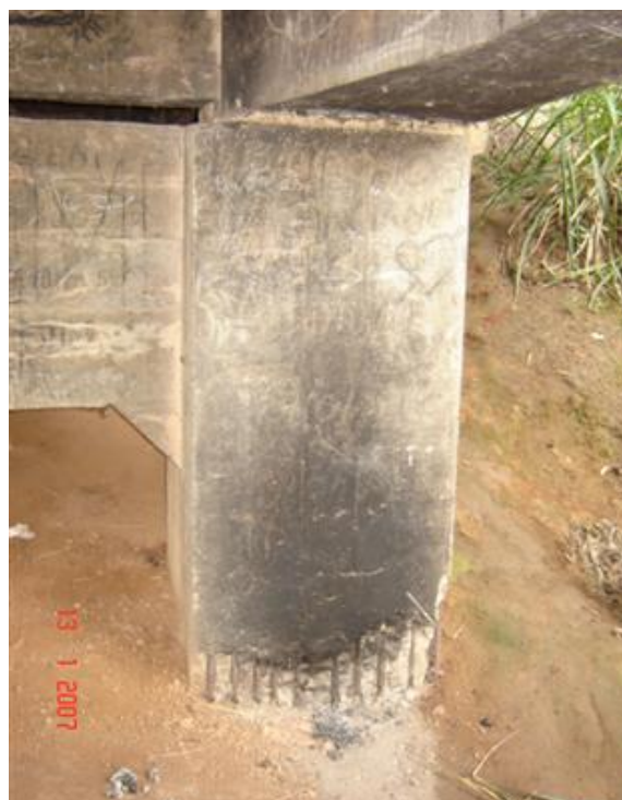
FOTO 4: Pilar com A.E.O. + C.D.
