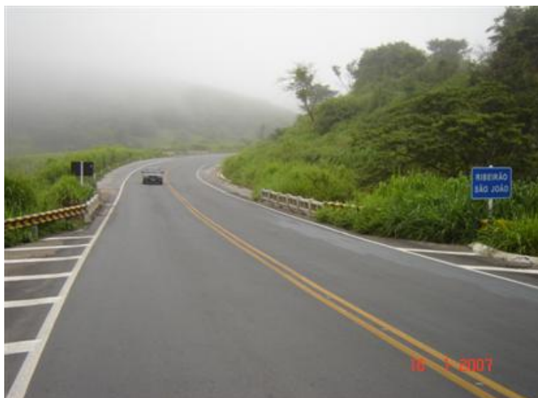
FOTO 1: Vista Superior da Obra
