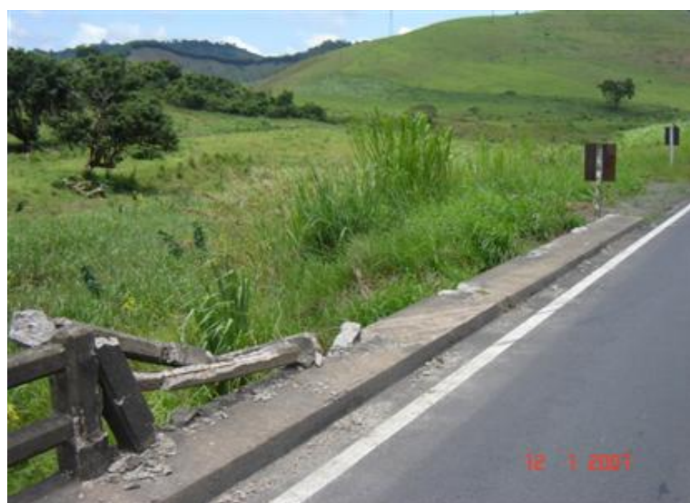
FOTO 4: Guarda - Corpos Quebrados
