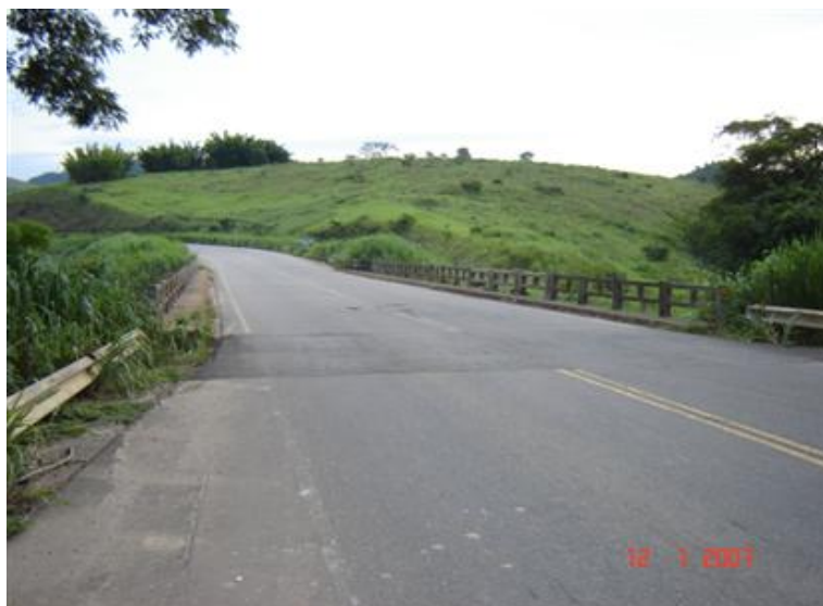
FOTO 1: Vista Superior da Obra
