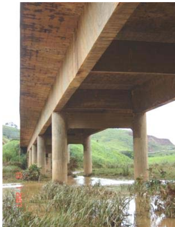
FOTO 3: Vista Inferior da Obra
