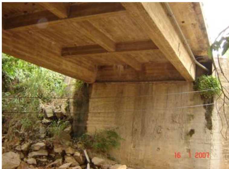
FOTO 3: Vista Inferior da Obra
