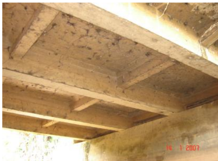
FOTO 3: Vista Inferior da Obra
