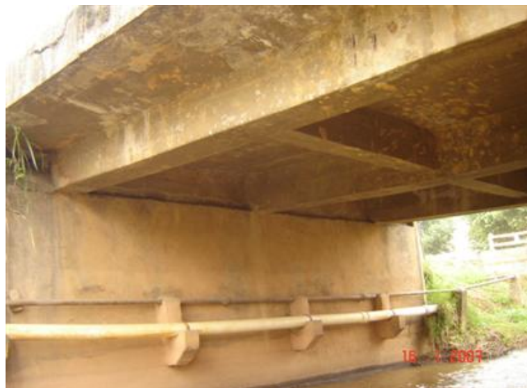
FOTO 3: Vista Inferior da Obra
