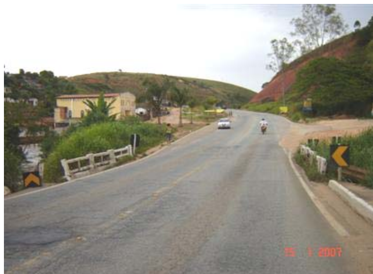
FOTO 1: Vista Superior da Obra
