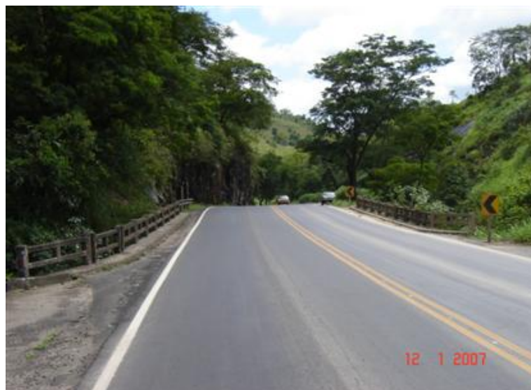
FOTO 1: Vista Superior da Obra
