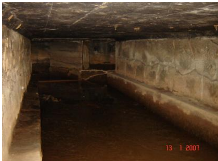
FOTO 3: Vista Inferior da Obra
