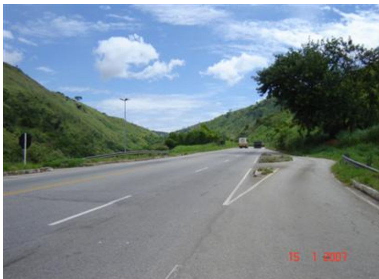
FOTO 1: Vista Superior da Obra
