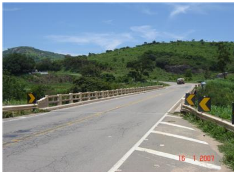
FOTO 1: Vista Superior da Obra
