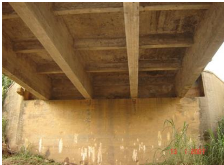
FOTO 3: Vista Inferior da Obra
