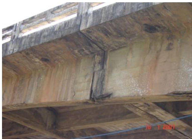
FOTO 4: Detalhe do Dente Gerber
