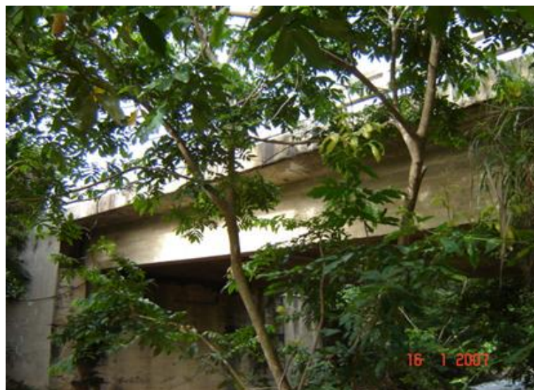
FOTO 2: Vista Lateral Inferior da Obra
