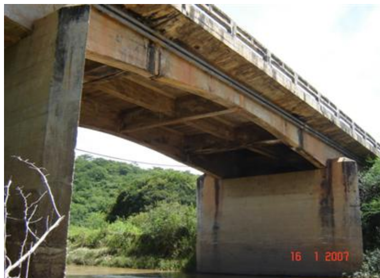
FOTO 2: Vista Lateral Inferior da Obra
