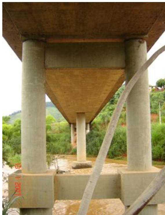
FOTO 3: Vista Inferior da Obra
