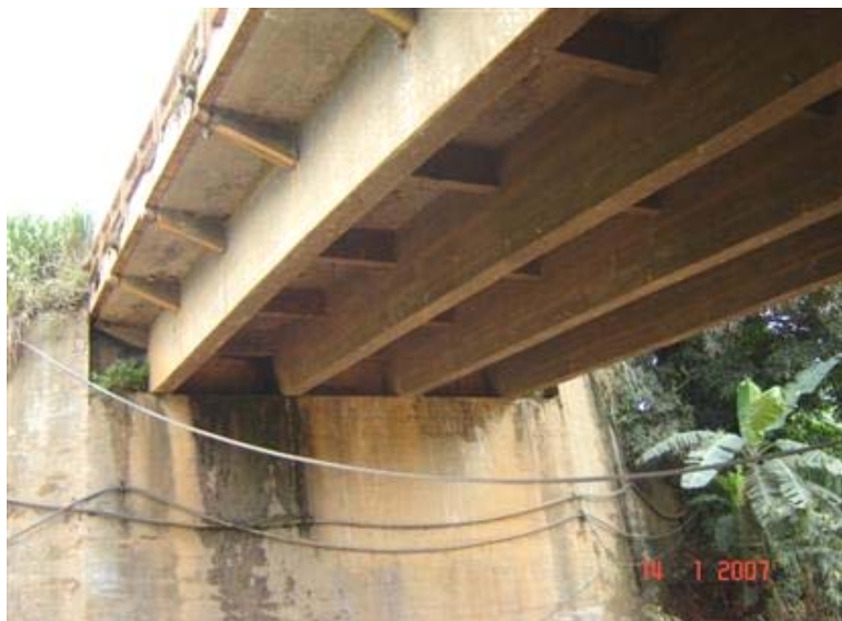
FOTO 3: Vista Inferior da Obra
