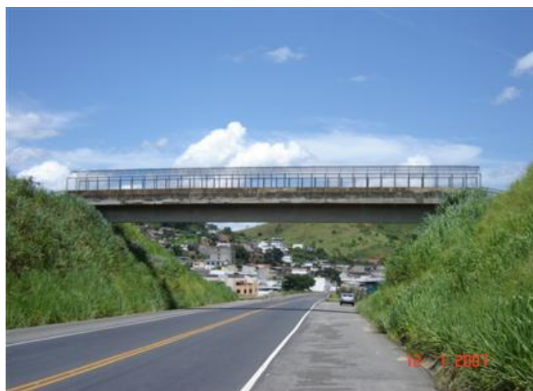
FOTO 2: Vista Lateral da Obra
