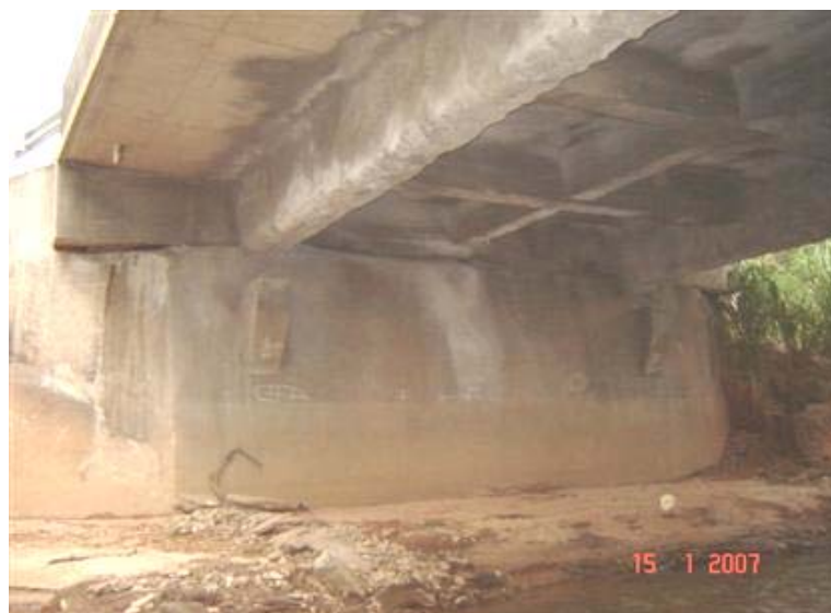
FOTO 3: Vista Inferior da Obra
