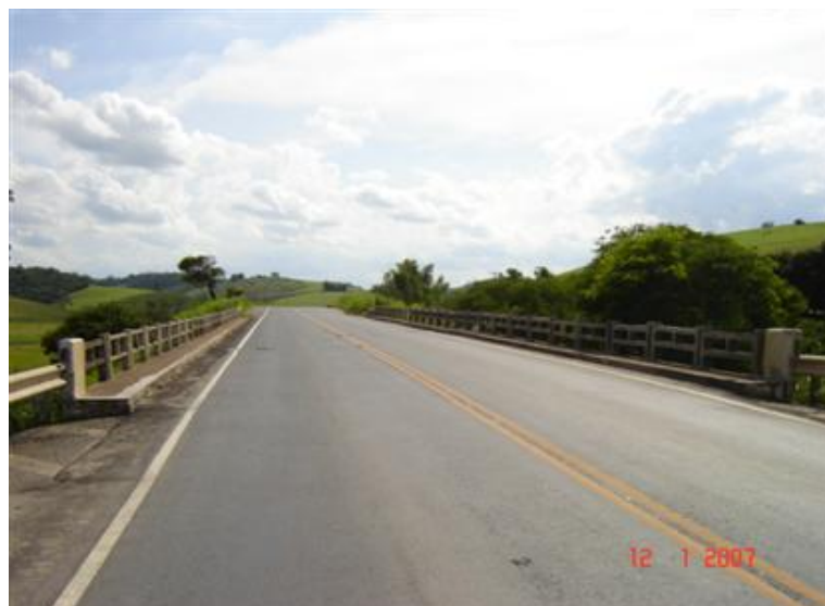
FOTO 1: Vista Superior da Obra
