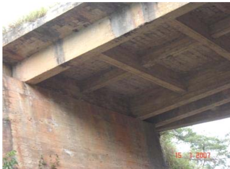
FOTO 3: Vista Inferior da Obra
