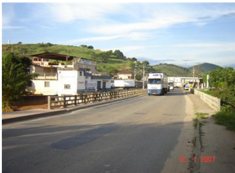
FOTO 1: Vista Superior da Obra
