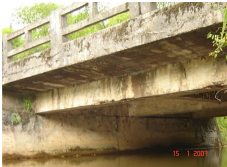
FOTO 3: Vista Inferior da Obra
