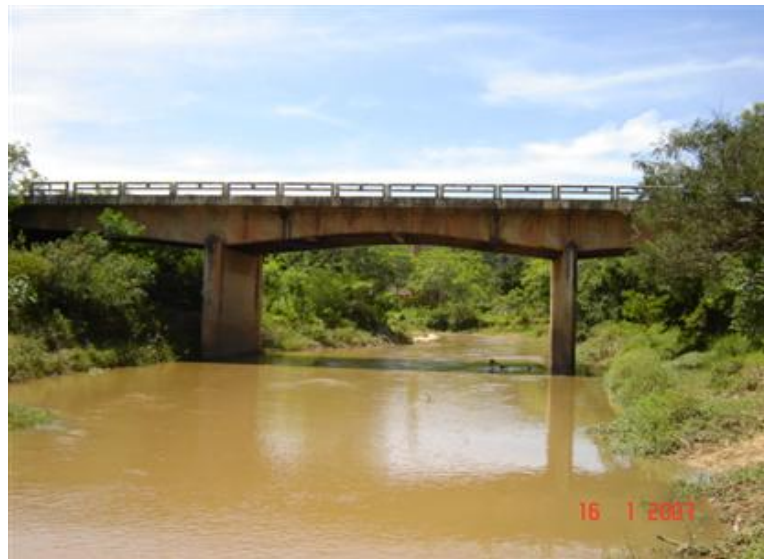
FOTO 3: Vista Lateral da Obra
