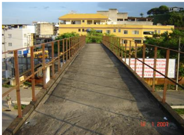
FOTO 1: Vista Superior da Obra
