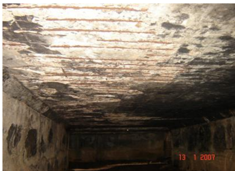
FOTO 4: Laje c/ C.D. + A.E.O.
