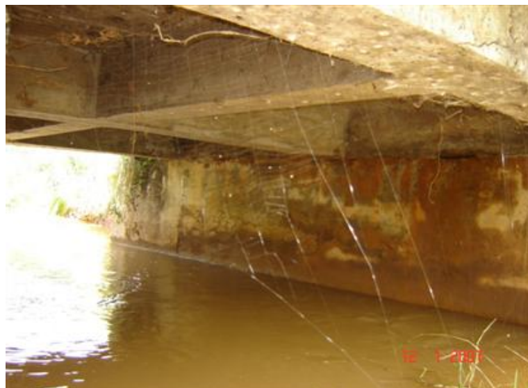
FOTO 3: Vista Inferior da Obra
