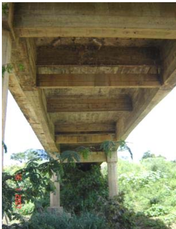
FOTO 3: Vista Inferior da Obra
