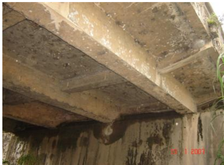
FOTO 3: Vista Inferior da Obra
