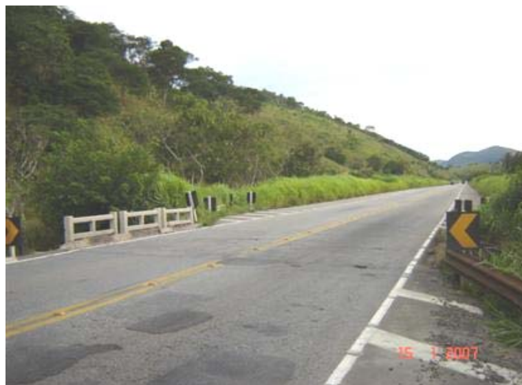
FOTO 1: Vista Superior da Obra
