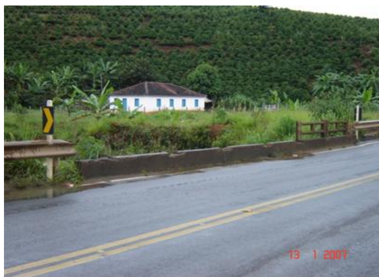
FOTO 4: Guarda-Corpo Faltante
