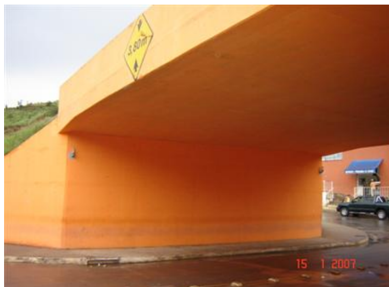
FOTO 3: Vista Inferior da Obra
