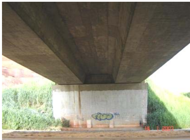
FOTO 3: Vista Inferior da Obra
