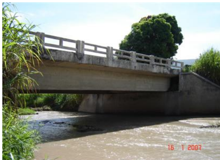
FOTO 2: Vista Lateral da Obra
