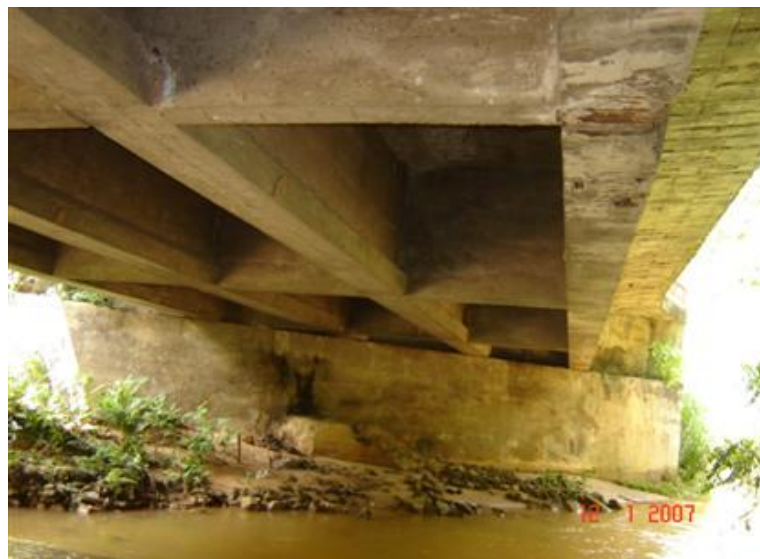
FOTO 3: Vista Inferior da Obra
