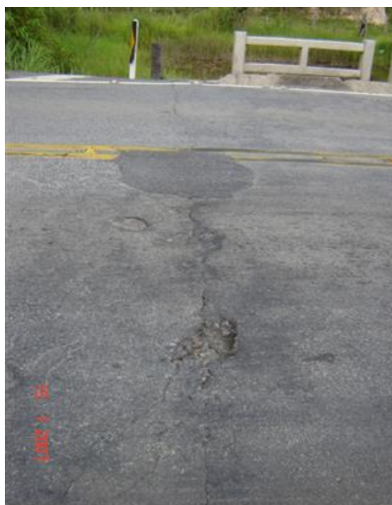
FOTO 4: Pavimento Deteriorado
