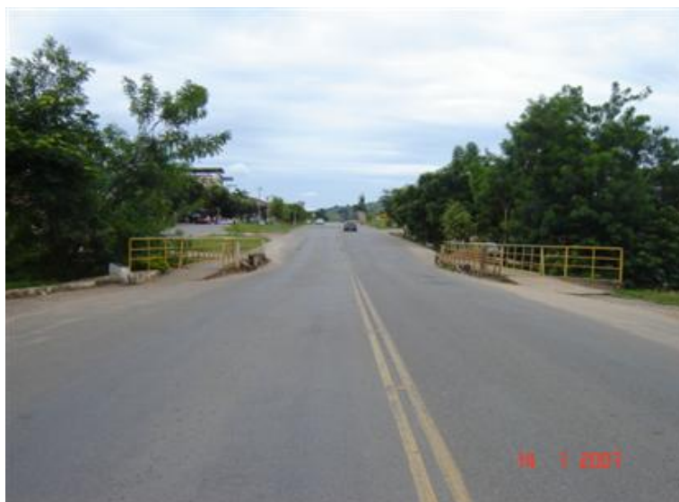
FOTO 1: Vista Superior da Obra
