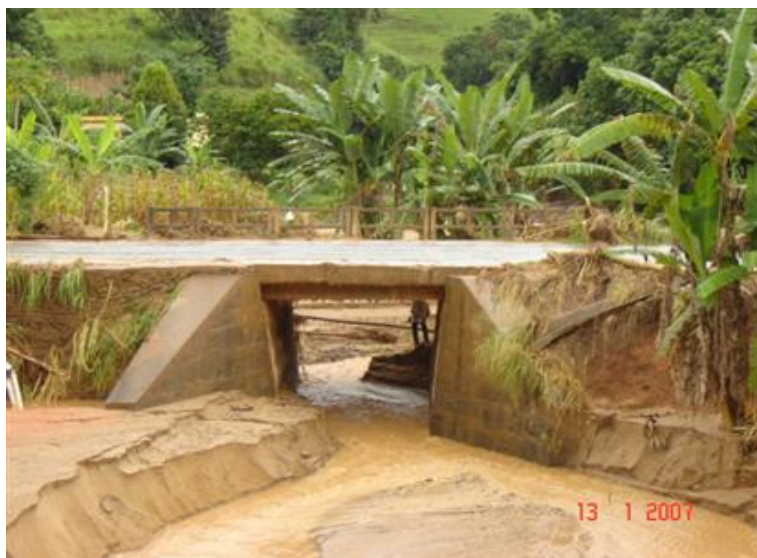
FOTO 2: Vista Lateral da Obra
