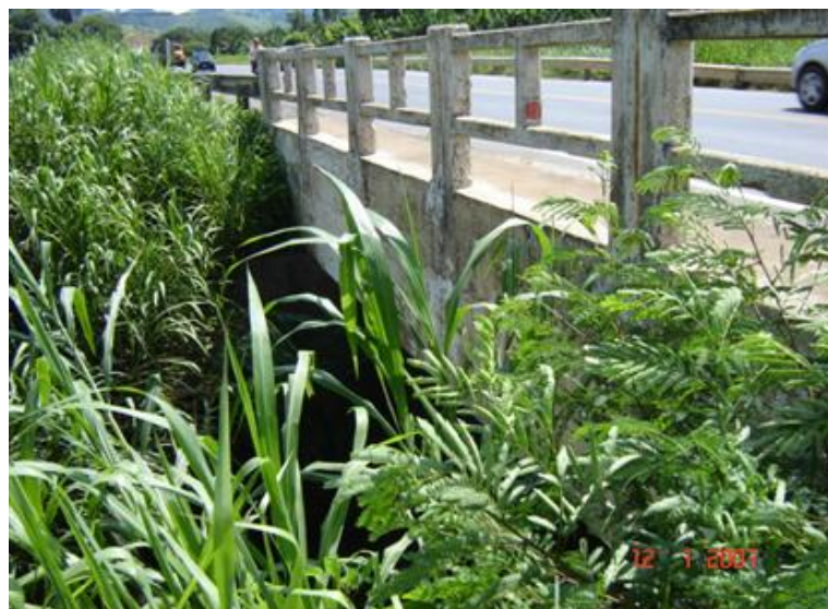
Vista Lateral da Obra
