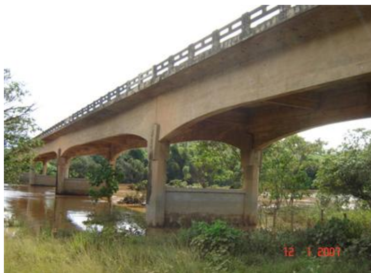
FOTO 2: Vista Lateral da Obra
