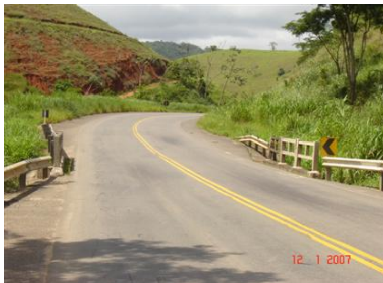
FOTO 1: Vista Superior da Obra
