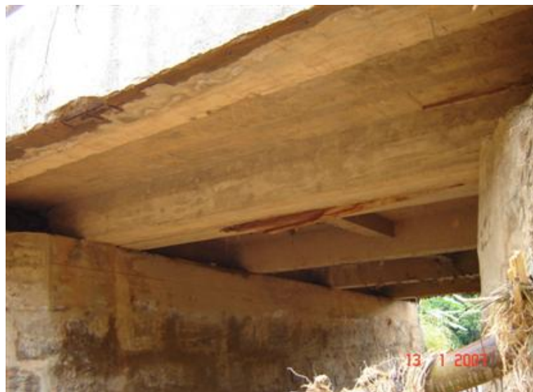
FOTO 3: Vista Inferior da Obra
