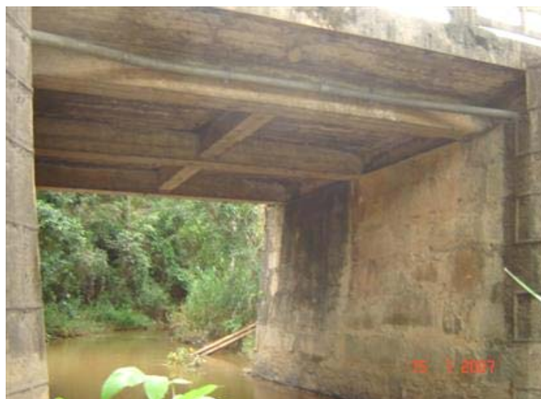
FOTO 3: Vista Inferior da Obra
