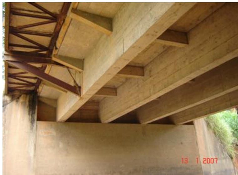
FOTO 3: Vista Inferior da Obra
