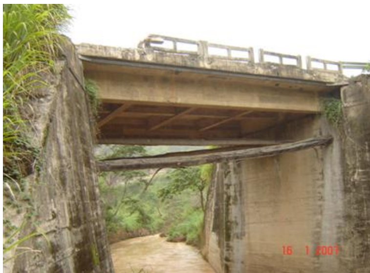
FOTO 2: Vista Lateral Inferior da Obra
